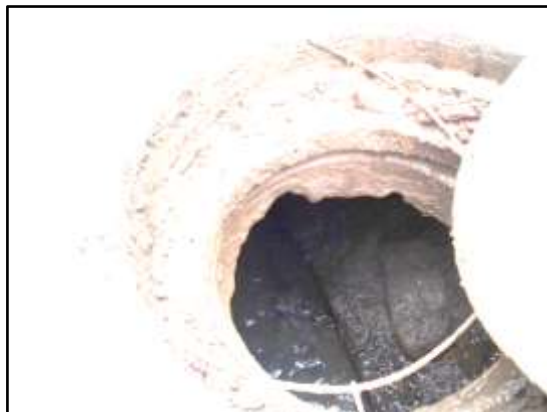
Figura N° 01: Buzón de Registro de la red de alcantarillado existente. Se encuentra en mal estado.
