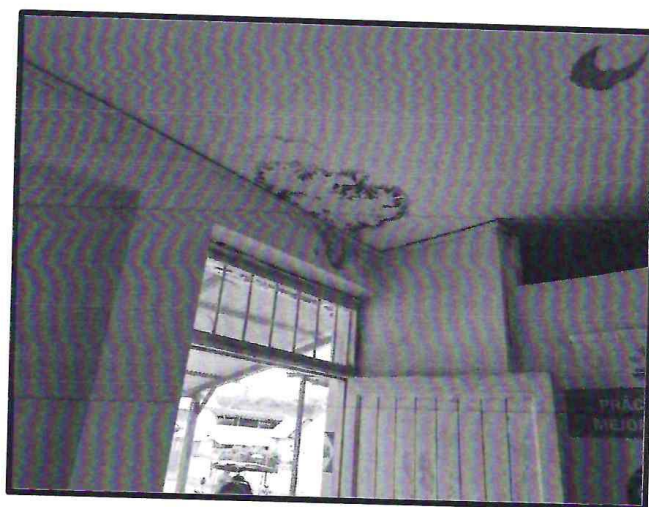
FOTO 06 – (28-02-2023) Se observa en la imagen otra perspectiva del deterioro del cielorraso debido al mal estado de la cobertura existente.
