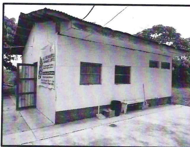
FOTO 02 – (28-02-2023) Se observa en la imagen el cielorraso exterior el cual esta proyectado a ser cambiado por el mal estado en la que se encuentra.
