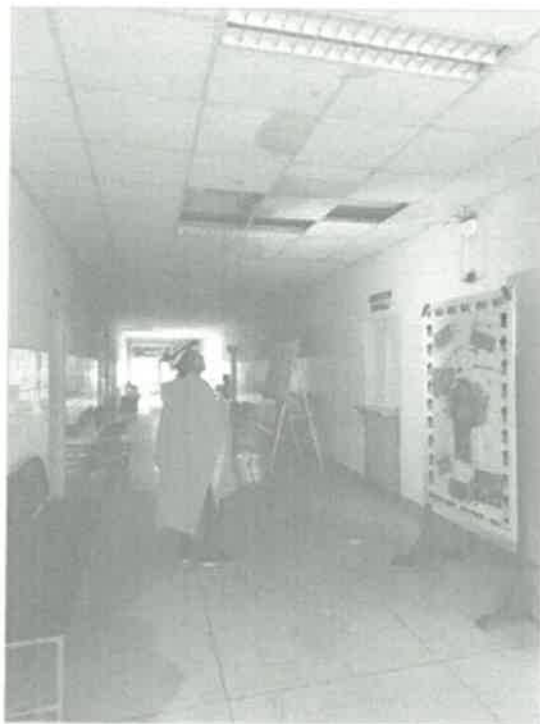
FILTRACIONES DE AGUA Y FALSO CIELO RASO CON PRESENCIA DE HUMEDAD
