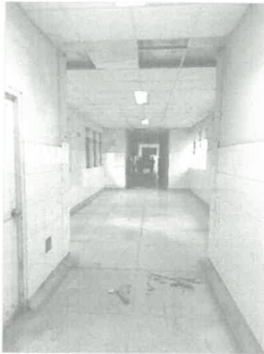
FILTRACIONES DE AGUA EN PASILLOS DEL ESTABLECIMIENTO
