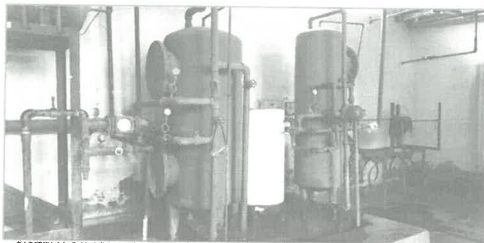
SISTEMA DE ABLANDADOR DE AGUA Y SISTEMA DE CLORACION, SE VIERON AFECTADOS POR LA SEDIMENTACION Y CONTAMINACION DEL AGUA
