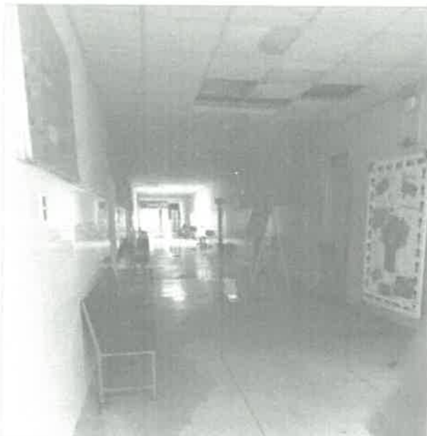
FILTRACIONES DE AGUA Y FALSO CIELO RASO CON PRESENCIA DE HUMEDAD
