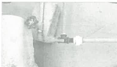
TUBERIAS METALICAS Y ACCESORIOS EXPUESTOS A LA LLUVIAS, PRESENTAN OXIDACION Y PROBLEMAS.
