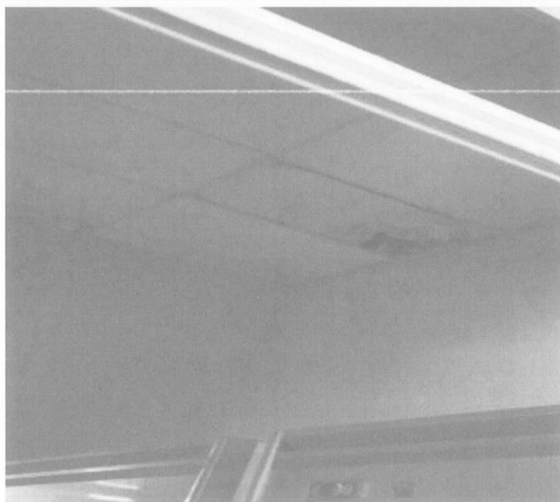
Foto 6.- Cielo raso en mal estado a reemplazar, dependiendo de su estado se contemplara el reemplazo de elementos de sujeción
