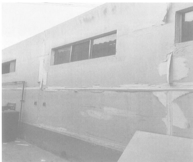
Foto 4.- Muros de drywall en mal estado, ausencia de cobertura
