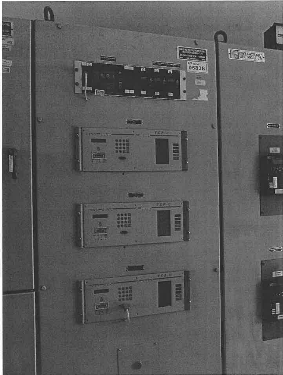
Imagen 5 Tablero de Protecciones líneas 33 kV SET Base Islay
