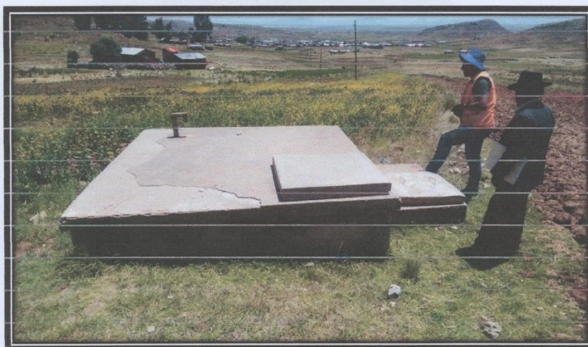
Foto N° 09. Reservorio del sistema existente en mal estado.
