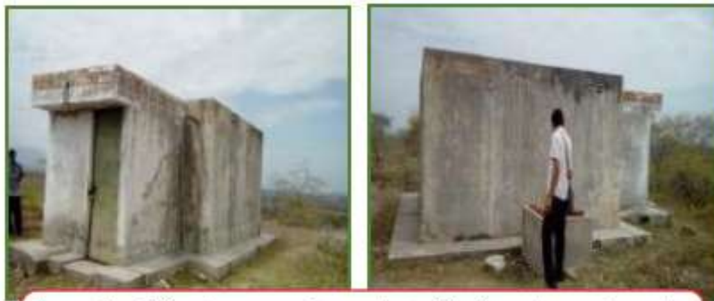
Imagen 7 y 8: Se observa reservorio apoyado de 32 m 3 , es de concreto armado, estructuralmente se encuentra en buenas condiciones, requiriendo trabajos de mantenimiento, por lo que se considera que el estado de conservación de su infraestructura es regular.
