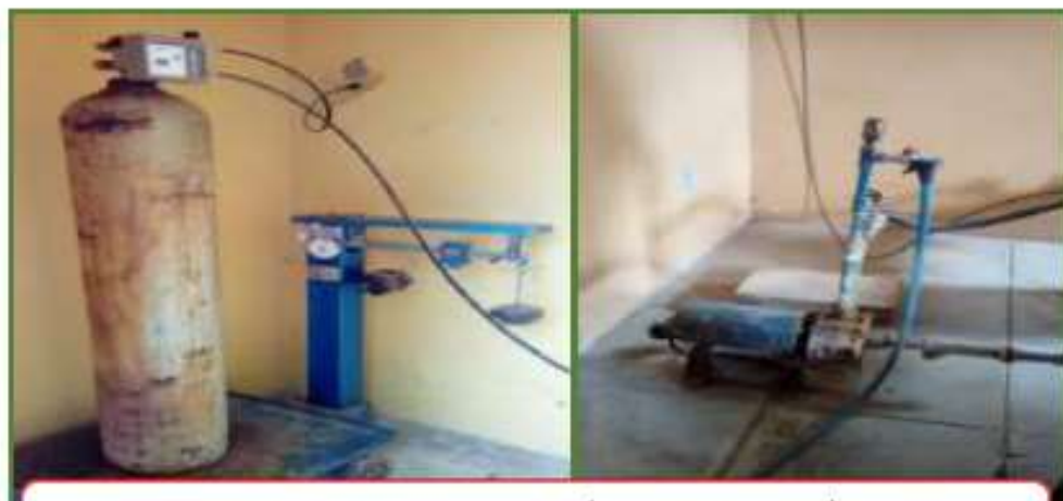
Imagen 5 y 6: Se puede ver sala y equipo de cloración. El equipo de cloración no se encuentra actualmente en funcionamiento.
