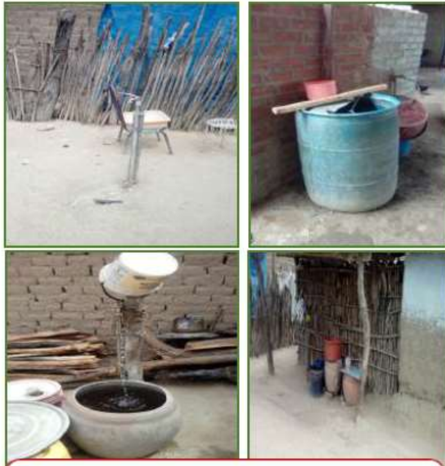
Imagen 8, 9, 10 y 11: Se puede observar conexiones domiciliarias instaladas en algunas viviendas sin criterio técnico adecuado. Asimismo, se aprecia los depósitos en que recogen y almacenan el agua. En la mayoría de casos estos recipientes no tienen tapa y son expuestos a la intemperie contaminándose el agua que las familias consumen, atentando contra su salud.
