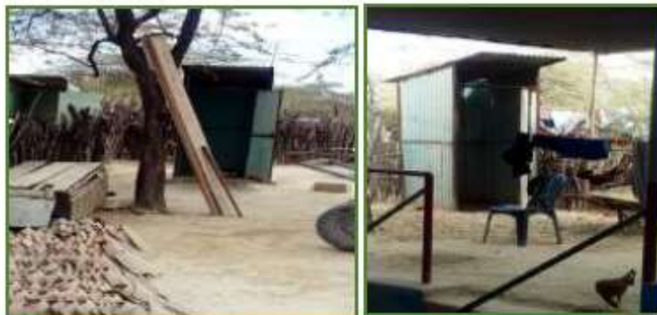
Imagen 12 y 13: Letrina tipo hoyo seco que fueron instaladas en el año 2006, actualmente en mal funcionamiento, habiendo cumplido su vida útil.
