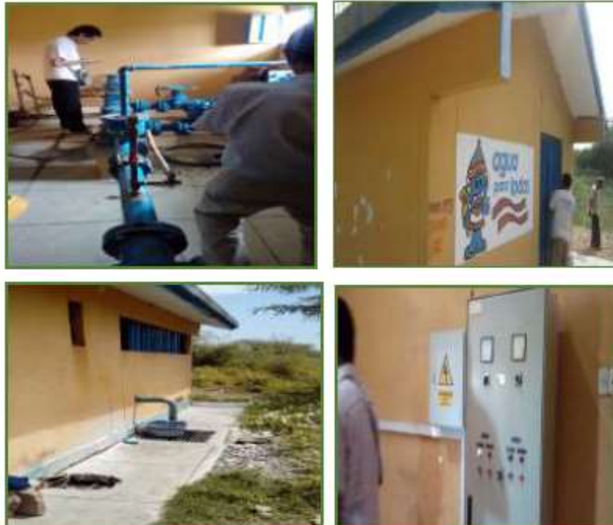
Imagen 1,2,3 y 4: Se puede apreciar el exterior e interior de la caseta de bombeo, su estructura se encuentra en buenas condiciones, presenta deterioro en puertas y pisos de sala de máquinas, sala de cloración y SS.HH., requiriendo trabajos de mantenimiento. En el interior se encuentra el pozo y el equipo de bombeo y de clorificación. En la imagen 1 y 4 se puede ver tuberías, válvulas y tablero de control. La bomba para extraer el agua es sumergible de 3" y es accionada con energía eléctrica, no tiene la potencia adecuada para sustraer la cantidad de agua que demanda la población y parte de la tubería que corresponde a este equipo de bombeo se encuentra deteriorada presentándose fugas que dan origen a las pérdidas de agua. En la imagen 3 se aprecia tubería deteriorada que da lugar a fugas y el agua es recepcionada en un depósito de plástico.
