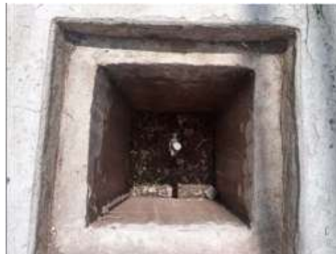
Fig. N° 29 UBICADO EN LADO IZQUIERDO EN LA PARTE DE LOS COSTADOS, PRESENTA TAPA DE CONCRETO QUEBRADA. (pozo a intervenir).
