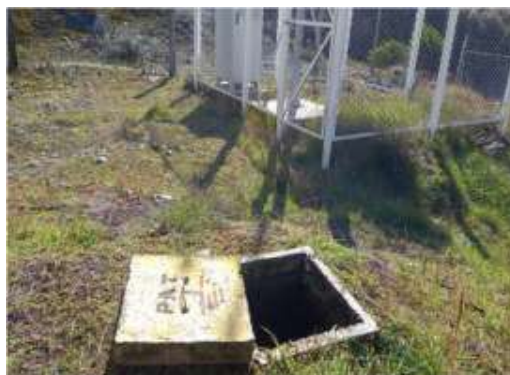
Fig. N° 39 UBICADO EN LA PARTE POSTERIOR IZQUIERDO DE LA PLATAFORMA, PRESENTA TAPA SIN PINTAR Y DETERIORO DEL INTERIOR DE LA CAJA, (pozo a intervenir).
