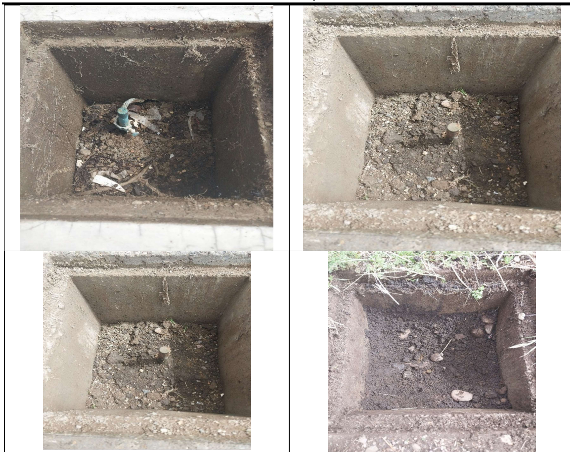
Fig. N° 09 POZOS UBICADOS ALREDEDOR DEL TAMBO, PARA EL CAMBIO DE CONECTOR, TAPA Y LIMPIEZA.
