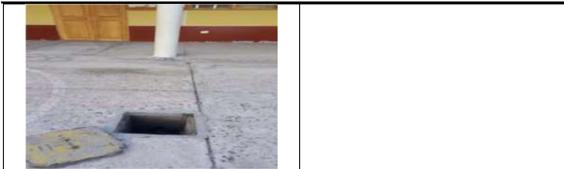
Fig. N° 40 POZOS UBICADOS ALREDEDOR DEL TAMBO, PARA CAMBIO DE CONECTOR, TAPA Y LIMPIEZA.
