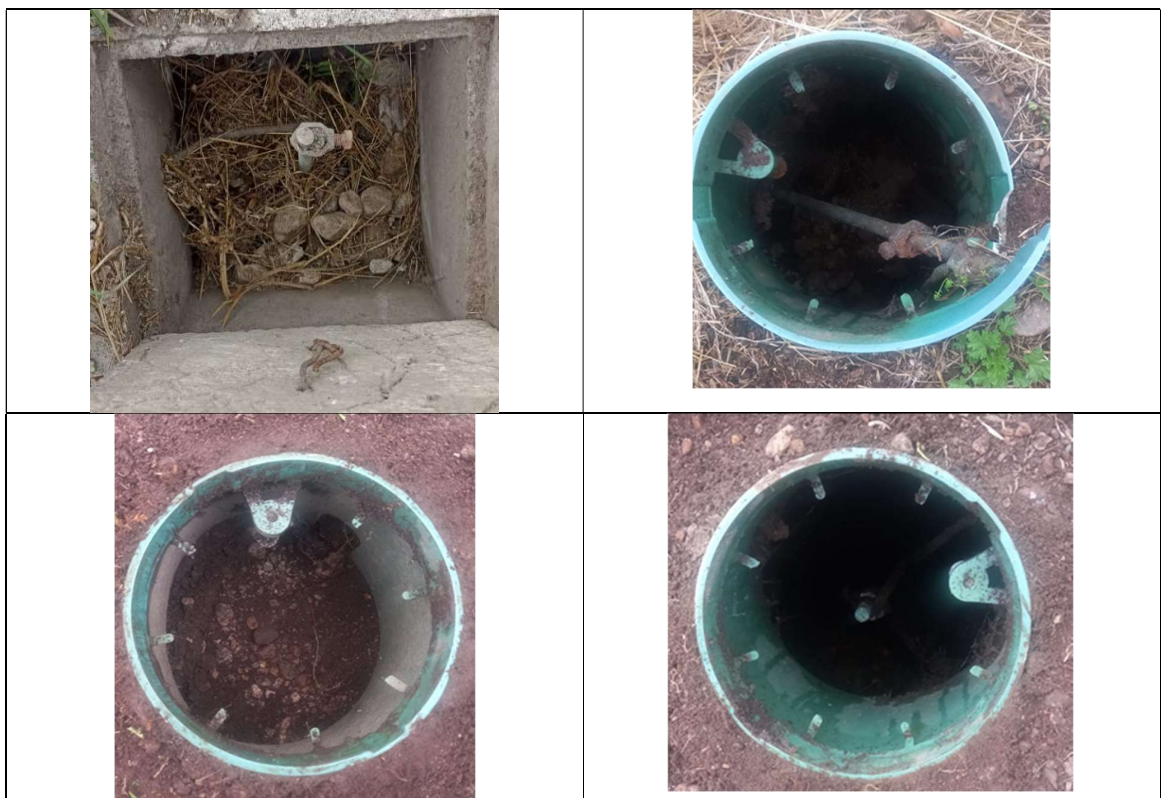
Fig. N° 24 POZOS A TIERRA ALREDEDOR DEL TAMBO QUE DEBEN SER REHECHOS Y CONECTADOS ENTRE ELLOS Y EL TABLERO GENERAL. (pozos a intervenir).
