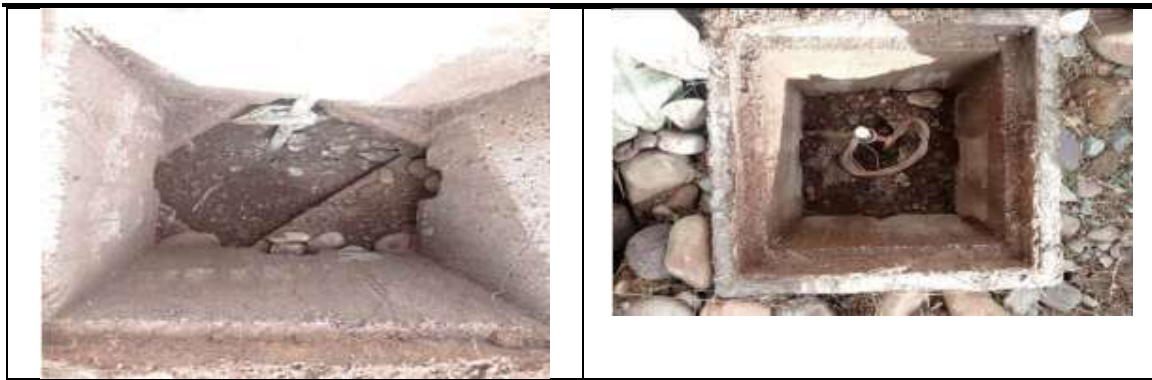
Fig. N° 36 POZOS UBICADOS ALREDEDOR DEL TAMBO, PARA CAMBIO DE CONECTOR, TAPA Y LIMPIEZA
