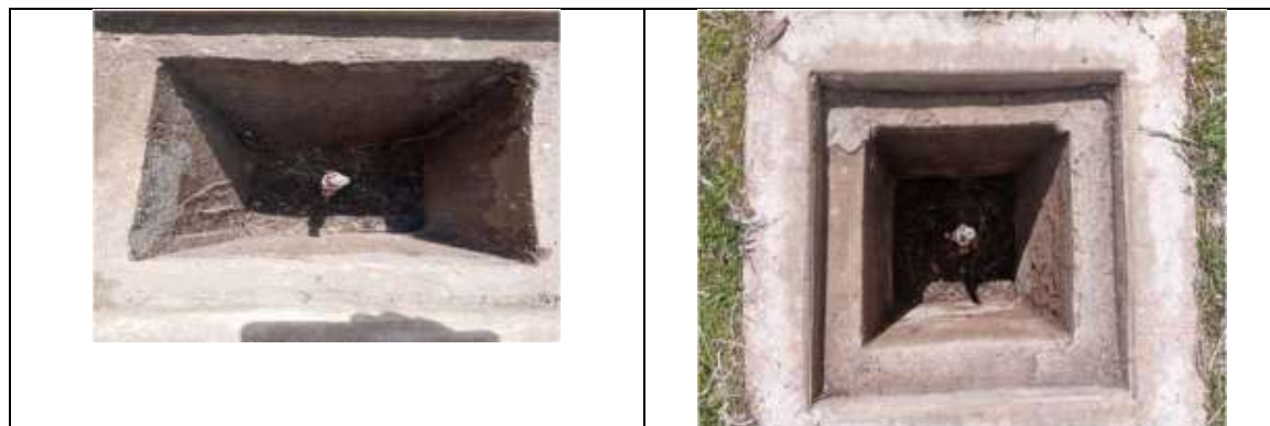
Fig. N° 29 UBICADO EN LADO IZQUIERDO EN LA PARTE DE LOS COSTADOS, PRESENTA TAPA DE CONCRETO QUEBRADA. (pozo a intervenir).
