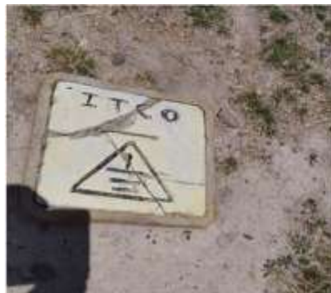
Fig. N° 21 UBICADO EN LA PARTE CENTRAL, PRESENTA TAPA DE CONCRETO FRAGMENTADO, PARA EL CAMBIO DE CONECTOR, TAPA Y LIMPIEZA
