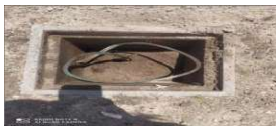
Fig. N° 19 UBICADO EN LA PARTE FRONTAL A LADO IZQUIERDA, PARA EL CAMBIO DE CONECTOR, TAPA Y LIMPIEZA
