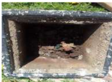
Fig. N°33 UBICADO EN LA PARTE POSTERIOR, COSTADO IZQUIERDO, CONCENTRO PRESENTA HUNDIMIENTO. (pozo a intervenir).
