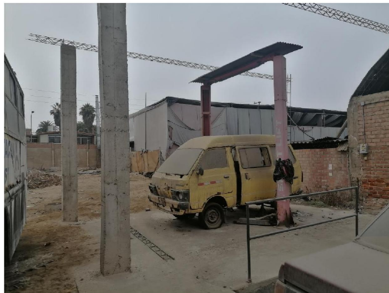
Notamos que en el taller se cuenta con columnas de concreto existentes para la colocación de la cobertura
