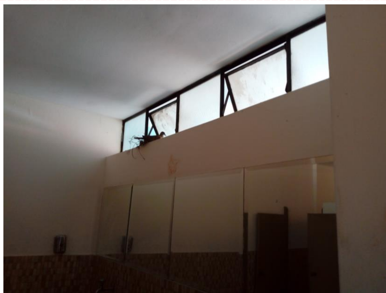
Fotografía 53: elevación 03 del módulo 10. Se evidencia el deterioro en las coberturas / accesorios / ventanas.
