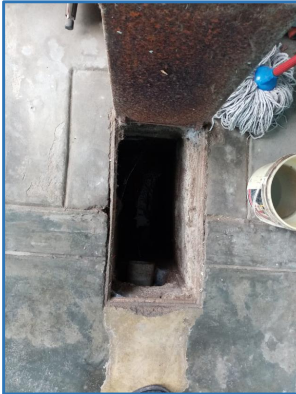
Imagen N°11 Verificación de profundidades de cajas de registro
