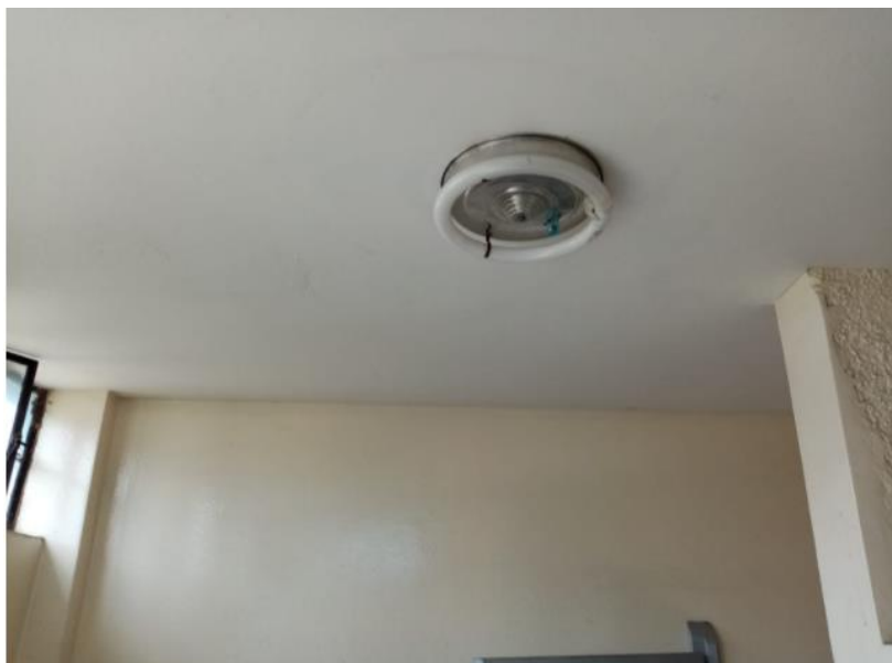
Fotografía 30: cielo raso del módulo 06. Se evidencia el deterioro de pintura / tarrajeo / baldosas acústicas / losa aligerada / otros.
