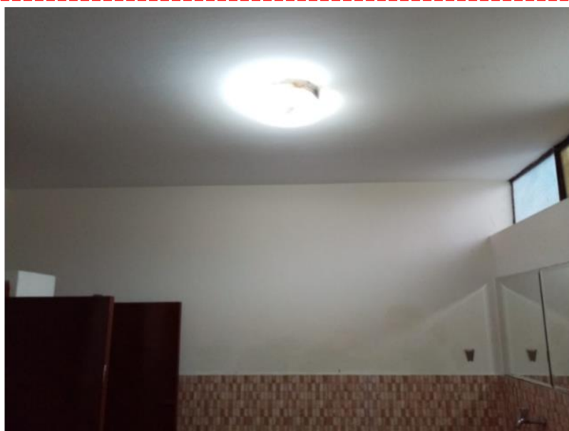
Fotografía 37: cielo raso del módulo 07. Se evidencia el deterioro de pintura.
