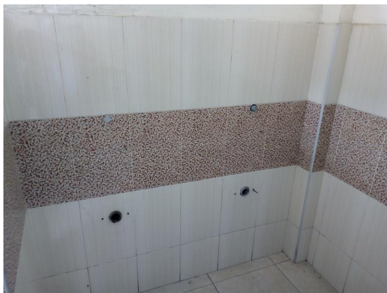
Fotografía 25: elevación 01 del módulo 06. Se evidencia el deterioro en las coberturas / accesorios.
