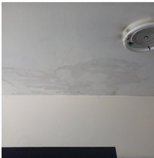
Fotografía 72: elevación 05 del módulo 13. Se evidencia el deterioro en las paredes y techo
