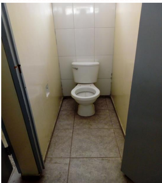
Fotografía 69: elevación 02 del módulo 13. Se evidencia el deterioro en las coberturas / equipamiento / accesorios.
