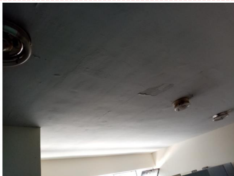
Fotografía 73: cielo raso del módulo 13. Se evidencia el deterioro de pintura.
