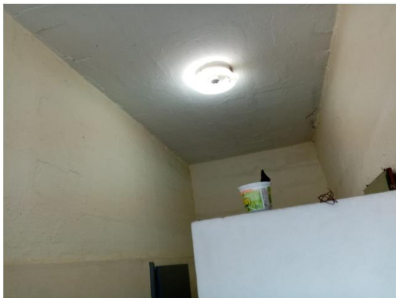
Fotografía 78: cielo raso del módulo 14. Se evidencia el deterioro de pintura.
