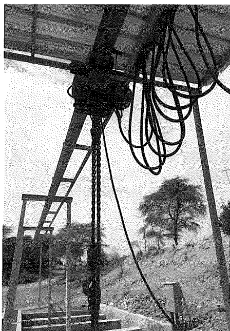
Mantenimiento del Monorriel y carro Trolley, en salida de bocatoma e inicio de canal Norte.
