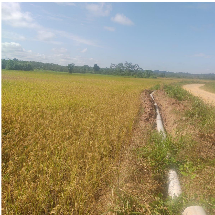
Tuberías de impulsión desde motobomba, Sector Quinayoc.
