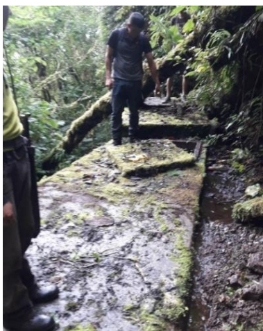
Captación existente de ladera
