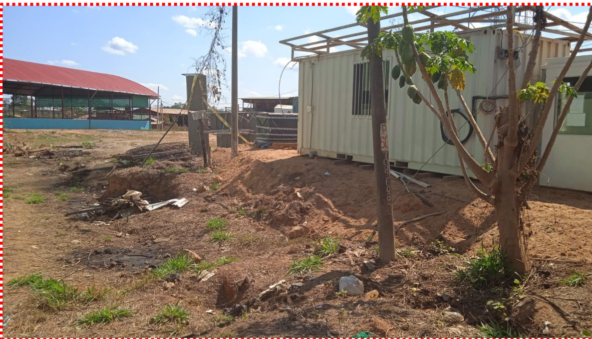
Ilustración 4. Vista de terreno natural (izquierda) y terreno con relleno afirmado (derecha) donde está ubicado la caseta de vigilancia y el módulo 1 reubicados de manera temporal
