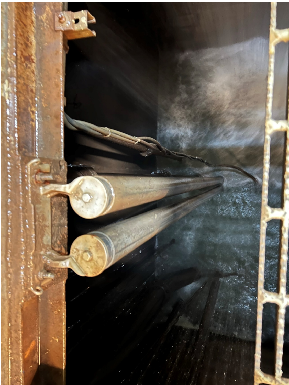
Estructura para izaje y descenso para autoacoplamiento
