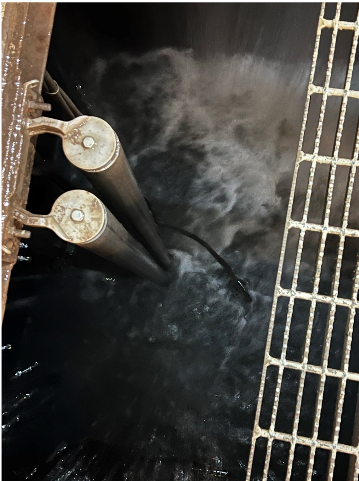
Estructura de montaje y electrobomba
