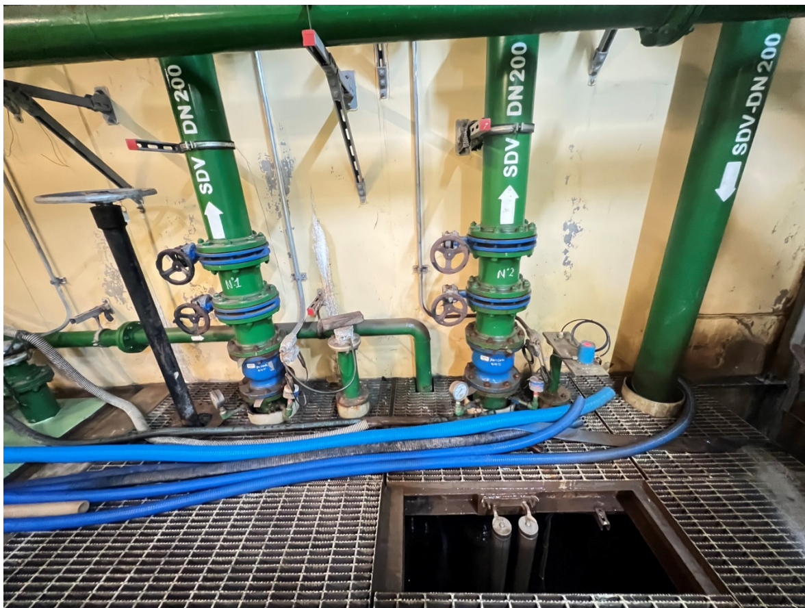
Escotilla de ingreso de electrobomba (reja desmontable)
