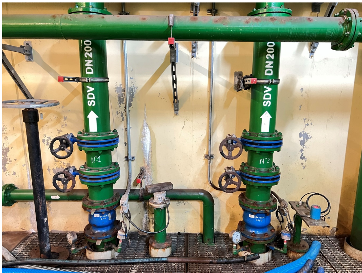
Línea de descarga de electrobombas
