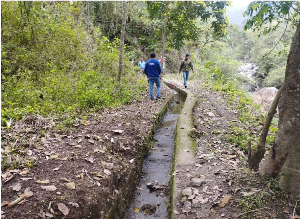
Foto N° 03: Se visualiza el tramo de canal revestido con malezas tanto interno como externamente.
