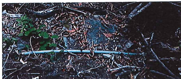
Vista 01: Tubería expuesta en Línea de conducción
