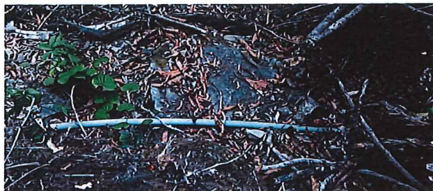
Vista 01: Tubería expuesta en Línea de conducción
