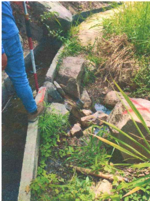
Afectación en canal revestido
