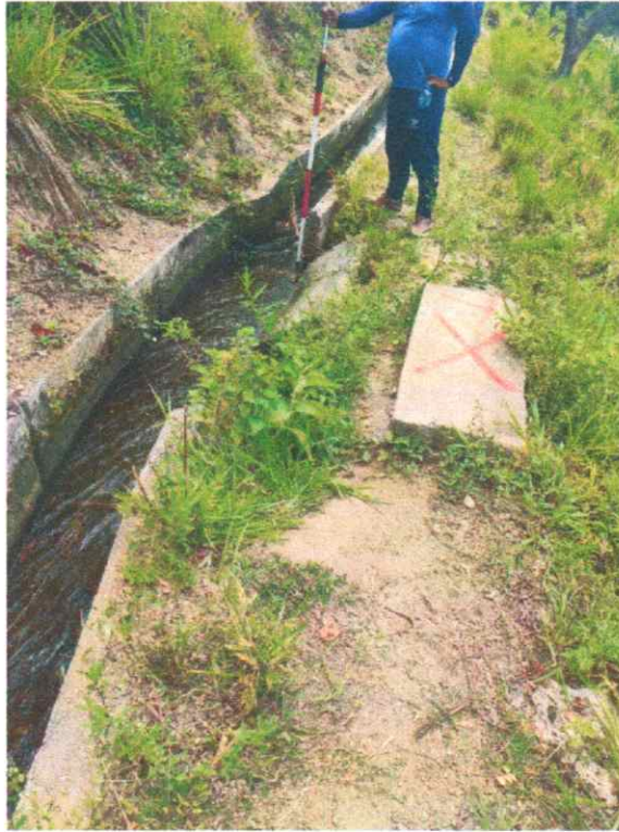
Afectación en canal revestido
