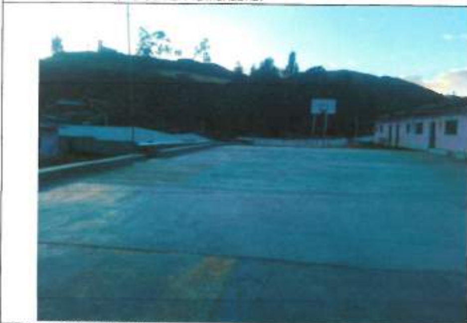
FOTOGRAFÍA N°22: PABELLÓN N° 06: LA LOSA DE CONCRETO PRESENTA RAJADURAS.
