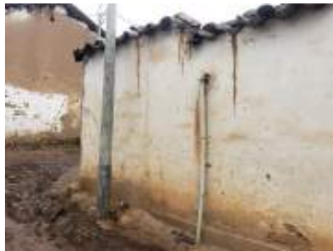
Se observa muros dañados por la humedad
