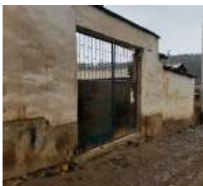
Se observa muros dañados por la humedad
