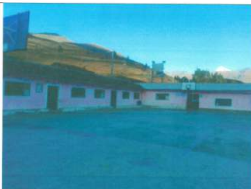
FOTOGRAFÍA N°01: PABELLÓN N° 01: ESTRUCTURA DE TAPIAL CONSTRUIDA POR AUTOCONSTRUCCIÓN. EXISTEN AULAS, DIRECCIÓN, SALA PROFESORES E INGRESO A LA I.E.
