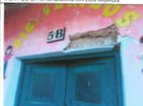
FOTOGRAFÍA N°15: SE PUEDE OBSERVAR DESPRENDIMIENTOS EN LA PARTE DEL DENTEL.
