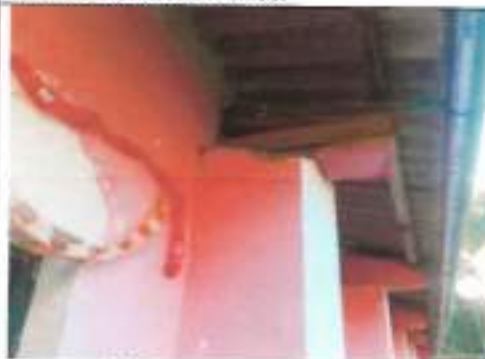
FOTOGRAFÍA N°14: SE PUEDE OBSERVAR DESPRENDIMIENTOS EN LA PARTE SUPERIOR DEL MURO.
