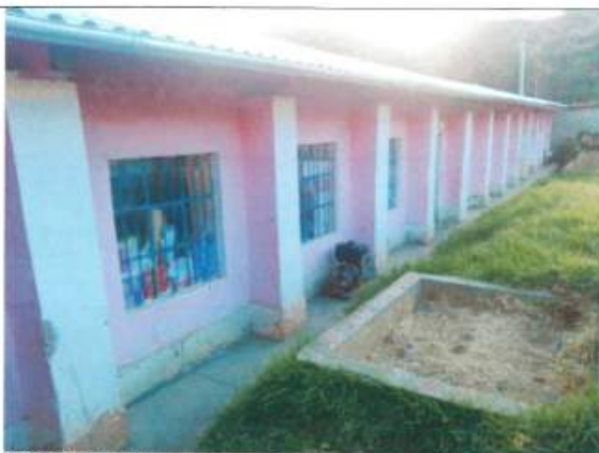
FOTOGRAFÍA N°11: PABELLÓN N° 03: ESTRUCTURA DE TAPIAL CONSTRUIDA POR AUTOCONSTRUCCIÓN, EXISTEN AULAS;
