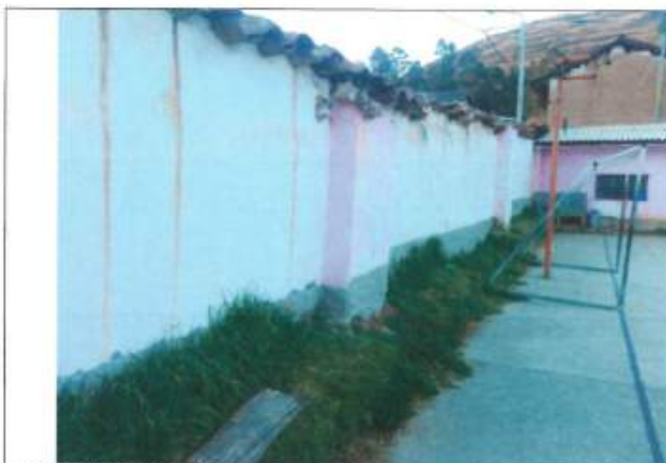
FOTOGRAFÍA N°21: PABELLÓN N° 05: ESTRUCTURA DE TAPIAL CONSTRUIDA POR AUTOCONSTRUCCIÓN, NO GUARDA VERTICALIDAD.
