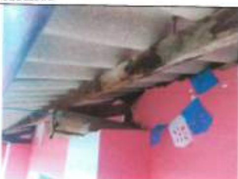
FOTOGRAFÍA N°10: SE OBSERVA QUE LAS MADERAS DE LAS CORREAS DE LOS TUALES SE ENCUENTRAN PODRIDAS EN MALAS CONDICIONES.
