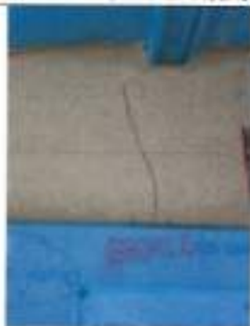
FOTOGRAFÍA N°12: SE PUEDE OBSERVAR RAJADURAS EN LOS MUROS.
