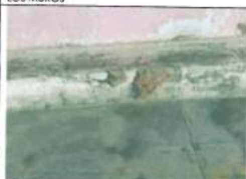
FOTOGRAFÍA N°05: SE PUEDE OBSERVAR DESPRENDIMIENTOS POR LA HUMEDAD EN LA PARTE INFERIOR DEL MURO
