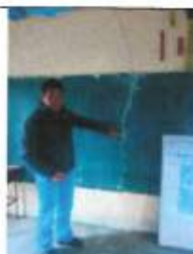
FOTOGRAFÍA N°13: SE PUEDE OBSERVAR OTRA VISTA DE LA RAJADURAS EN LOS MUROS
