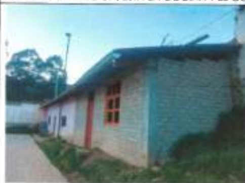
FOTOGRAFÍA N°17: OTRA VISTA DEL COMEDOR, ES UNA AMPLIACIÓN REALIZADA POR AUTOCONSTRUCCIÓN, CON ALBAÑILERÍA DE CONCRETO
