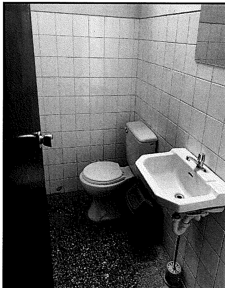
Fotografía 13. Demolición y construcción de piso (incluye falso piso) en baños de edificio de fitopatología. Así mismo, instalación de nuevos aparatos sanitarios e instalaciones de redes de agua y desagüe.
