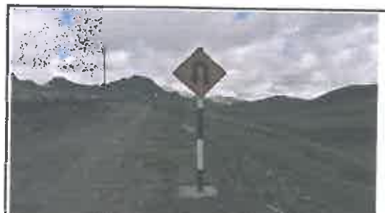
Foto N° 178: Señal preventiva de 0.8 x 0.8 m en buen estado, alerta de una curva en "U" a la izquierda, ubicada en la progresiva 29+169.
