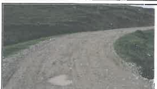
Foto N° 44: Evidencia de erosión afectando la plataforma en el Km 09+105
