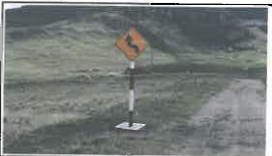
Foto N° 173: Señal preventiva de 0.8 x 0.8 m en buen estado, alerta de una curva en "S", ubicada en la progresiva 28+762.
