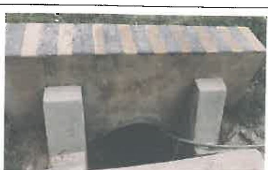
Salida de alcantarilla de concreto semi obstruida, ubicada en la progresiva 02+945
