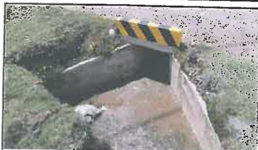
Foto N° 94: Alcantarilla tipo marco de 0.8 x 0.8 m en buen estado, ubicada en la progresiva 24+400.
