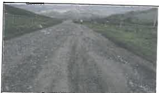
Foto N° 114: Evidencia de erosión afectando la plataforma en el Km 19+450
