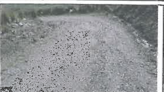
Foto N° 144: Evidencia de erosión afectando la plataforma en el Km 25+400
