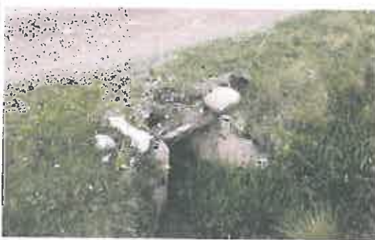
Alcantarilla de mampostería y losa de troncos de madera en mal estado, ubica en la progresiva 15+630
