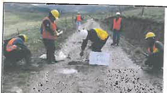
Foto N° 546: Prueba de la anchura de la superficie de rodadura en el Km 27+250.
