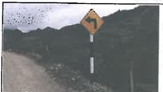
Foto N° 35: Señal preventiva de 0.8 x 0.8 m en buen estado, alerta de una curva pronunciada a la izquierda, ubicada en la progresiva 02+920.
