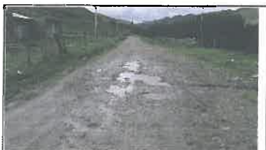
Foto N° 57: Evidencia de baches afectando la plataforma en el Km 12+320
