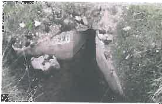
Alcantarilla de mampostería y losa de troncos de madera en mal estado, ubica en la progresiva 15+153
