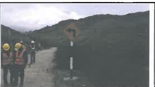
Foto N° 47: Señal preventiva de 0.8 x 0.8 m en buen estado, alerta de una curva pronunciada a la izquierda, ubicada en la progresiva 04+520.
