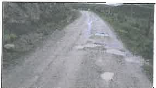
Foto N° 130: Evidencia de erosión afectando la plataforma en el Km 22+900
