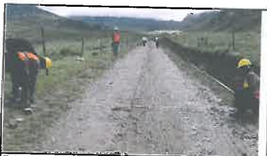
Foto N° 545: Prueba de la anchura de la superficie de rodadura en el Km 27+200.
