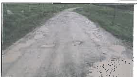
Foto N° 100: Evidencia de baches afectando la plataforma en el Km 17+350
