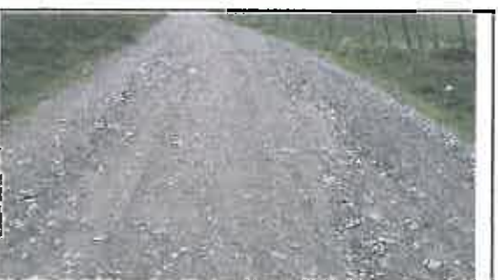
Foto N° 103: Evidencia de erosión afectando la plataforma en el Km 17+800
