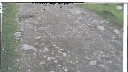
Foto N° 59: Evidencia de cruce de agua afectando la plataforma en el Km 12+500
