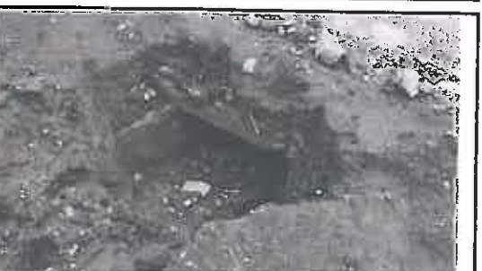
Foto N° 8: Parapeto roto del cabezal de entrada de alcantarilla tipo marco, ubicada en la progresiva 02+538.
