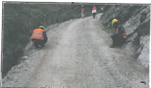
Foto N° 113: Prueba de la anchura de la superficie de rodadura en el Km 05+600.
