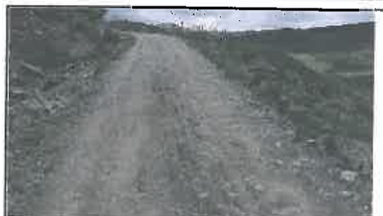
Foto N° 126: Evidencia de erosión afectando la plataforma en el Km 22+130
