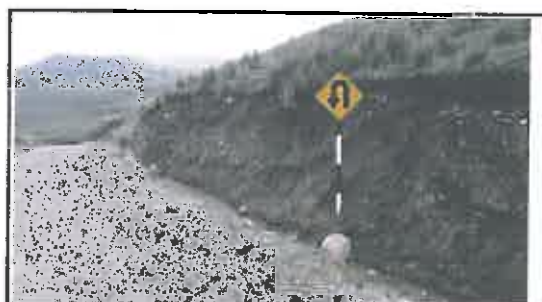
Foto N° 146: Señal preventiva de 0.8 x 0.8 m en buen estado, alerta de una curva en "U" a la izquierda, ubicada en la progresiva 24+935.
