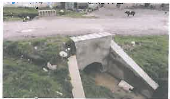
Salida de alcantarilla de concreto semi obstruida, ubicada en la progresiva 18+190
