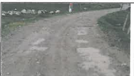
Foto N° 43: Evidencia de baches afectando la plataforma en el Km 08+950
