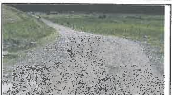
Foto N° 110: Evidencia de erosión afectando la plataforma en el Km 18+550
