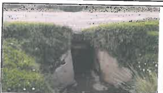
Foto N° 53: Alcantarilla de mampostería con rocas obstruyendo, ubicada en la progresiva 14+971.
