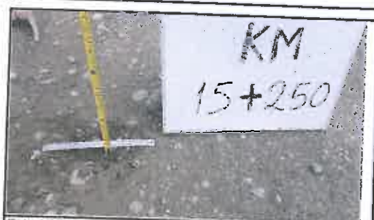
Foto N° 62: Desgaste del espesor del afirmado
