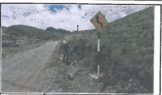
Foto N° 136: Señal preventiva de 0.8 x 0.8 m en buen estado, alerta de una curva en "S", ubicada en la progresiva 24+399.
