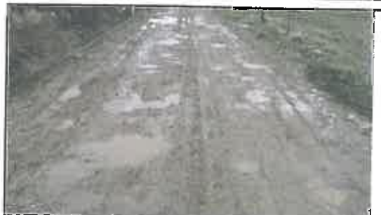
Foto N° 160: Evidencia de baches afectando la plataforma en el Km 28+170
