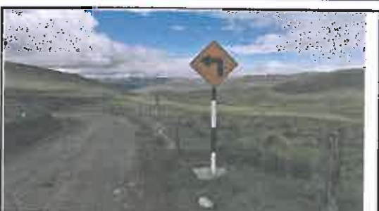
Foto N° 166: Señal preventiva de 0.8 x 0.8 m en buen estado, alerta de una curva pronunciada a la izquierda, ubicada en la progresiva 27+190.
