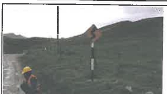
Foto N° 68: Señal preventiva de 0.8 x 0.8 m en buen estado, alerta un tramo sinuoso en la progresiva 09+000.
