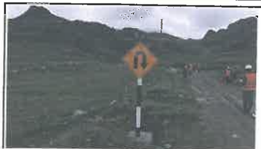
Foto N° 176: Señal preventiva de 0.8 x 0.8 m en buen estado, alerta de una curva en "U" a la derecha, ubicada en la progresiva 29+090.
