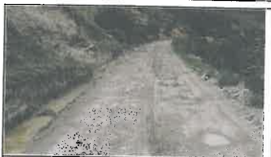
Foto N° 38: Evidencia de baches afectando la plataforma en el Km 07+490
