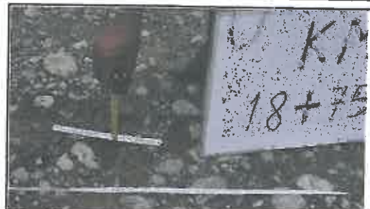
Foto N° 76: Desgaste del espesor del afirmado
