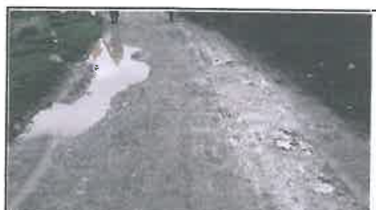
Foto N° 82: Evidencia de baches afectando la plataforma en el Km 15+510
