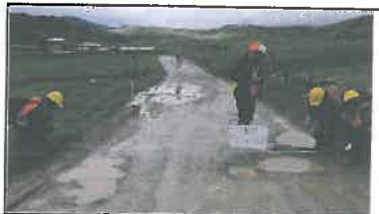
Foto N° 346: Prueba de la anchura de la superficie de rodadura en el Km 17+250.
