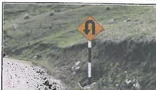
Foto N° 14: Señal preventiva de 0.8 x 0.8 m en buen estado, alerta de una curva en "U" a la izquierda, ubicada en la progresiva 01+113.
