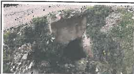
Foto N° 2: Cabezal de entrada de alcantarilla de concreto tipo marco, ubicada en la progresiva 00+608.
