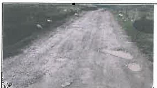
Foto N° 83: Evidencia de baches afectando la plataforma en el Km 15+600
