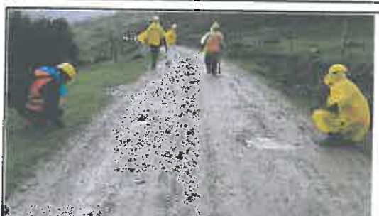
Foto N° 215: Prueba de la anchura de la superficie de rodadura en el Km 10+700.
