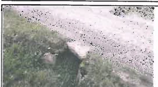
Foto N° 60: Alcantarilla de mampostería y semiobstruida generando erosión en la plataforma, ubicada en la progresiva 15+895.
