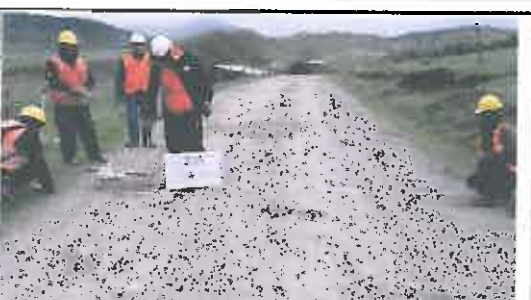
Foto N° 341: Prueba de la anchura de la superficie de rodadura en el Km 17+000.
