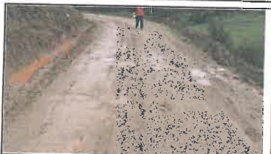
Foto N° 11: Evidencia de cruce de agua afectando la plataforma en el Km 01+970
