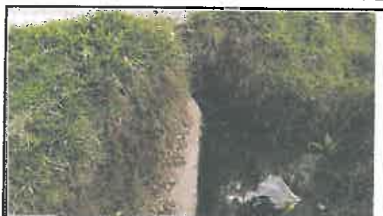
Foto N° 31: Entrada de alcantarilla de mampostería con losa de madera, ubicada en la progresiva 09+788.
