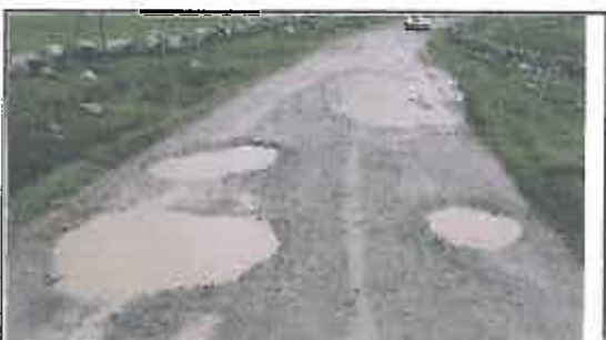
Foto N° 99: Evidencia de baches afectando la plataforma en el Km 17+260
