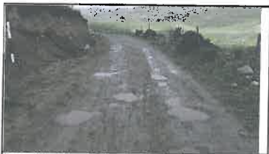
Foto N° 153: Evidencia de baches afectando la plataforma en el Km 27+065
