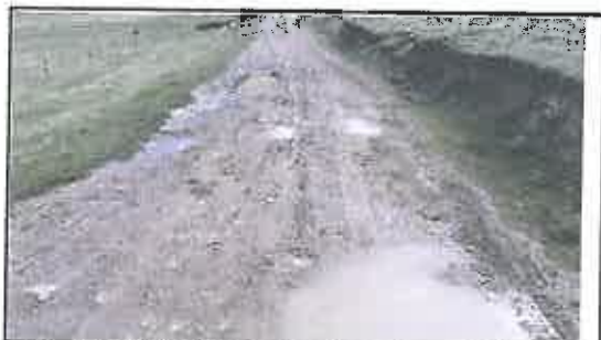
Foto N° 169: Evidencia de baches afectando la plataforma en el Km 29+640
