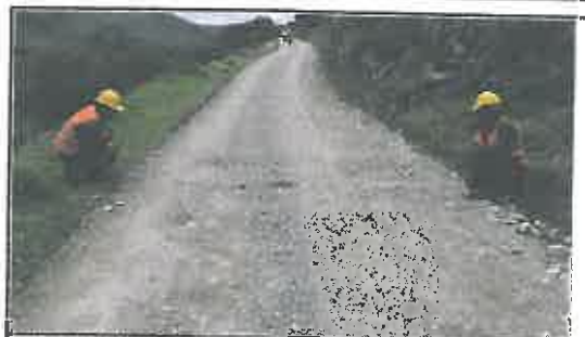
Foto N° 134: Prueba de la anchura de la superficie de rodadura en el Km 06+650.
