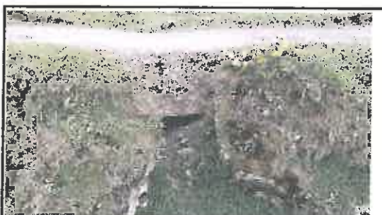
Foto N° 69: Salida de alcantarilla obstruida y genera erosión en la plataforma, ubicada en la progresiva 17+130.
