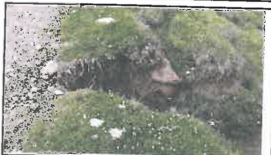
Foto N° 56: Tajea de piedra obstruida y generando erosión en la plataforma, ubicada en la progresiva 15+360.
