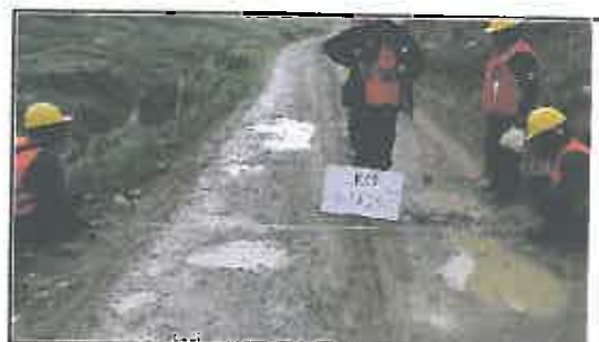
Foto N° 186: Prueba de la anchura de la superficie de rodadura en el Km 09+250.
