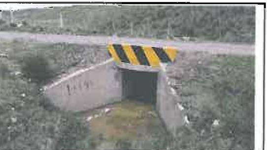
Foto N° 87: Alcantarilla tipo marco de 0.9 x 0.9 m en buen estado, ubicada en la progresiva 21+680.
