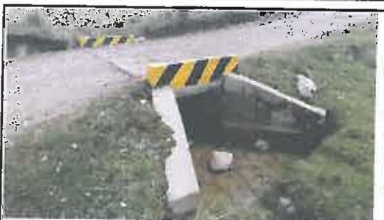
Foto N° 95: Alcantarilla tipo marco de 0.8 x 0.9 m en buen estado, ubicada en la progresiva 24+740.
