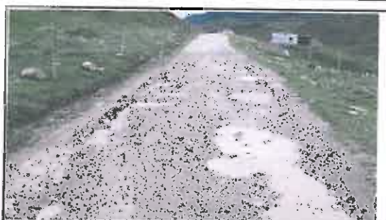
Foto N° 93: Evidencia de baches afectando la plataforma en el Km 16+670
