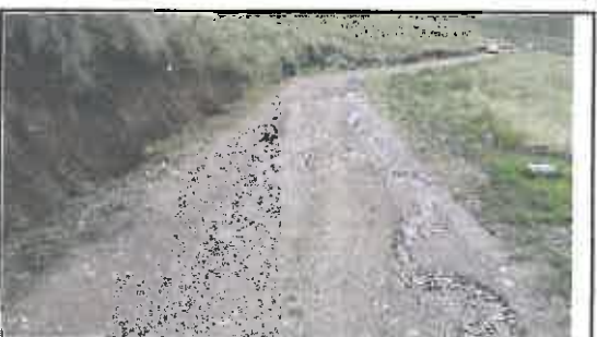
Foto N° 149: Evidencia de erosión afectando la plataforma en el Km 26+370
