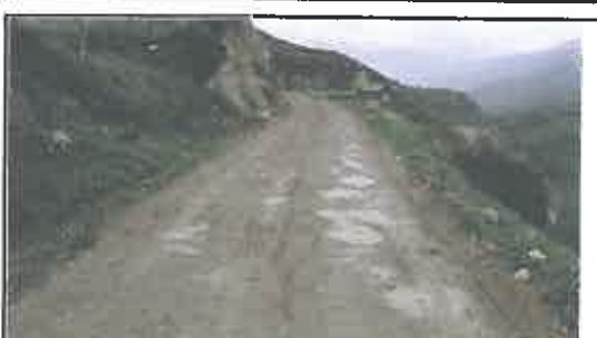
Foto N° 46: Evidencia de baches afectando la plataforma en el Km 09+305
