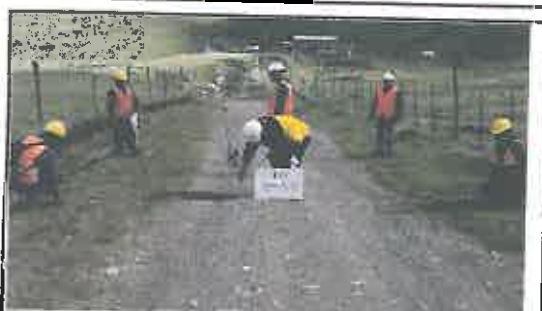
Foto N° 591: Prueba de la anchura de la superficie de rodadura en el Km 29+500.
