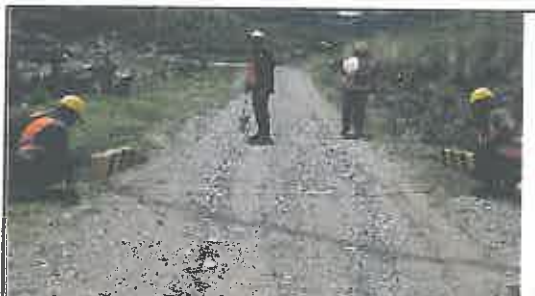
Foto N° 489: Prueba de la anchura de la superficie de rodadura en el Km 24+400.
