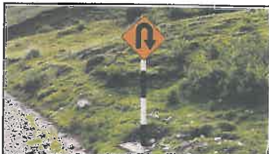
Foto N° 12: Señal preventiva de 0.80x 0.8 m en buen estado, alerta de una curva en "U" a la derecha, ubicada en la progresiva 01+011.
