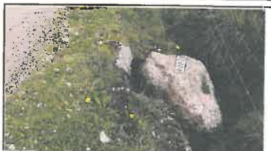
Foto N° 44: Entrada de alcantarilla tapada con una roca, ubicada en la progresiva 11+937.
