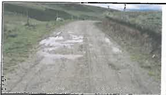
Foto N° 159: Evidencia de baches afectando la plataforma en el Km 28+050
