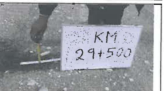
Foto N° 119: Desgaste del espesor del afirmado
