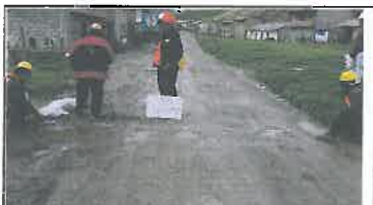
Foto N° 361: Prueba de la anchura de la superficie de rodadura en el Km 18+000.
