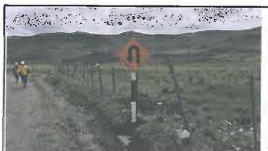
Foto N° 105: Señal preventiva de 0.8 x 0.8 m en buen estado, alerta de una curva en "U" a la izquierda, ubicada en la progresiva 20+780.
