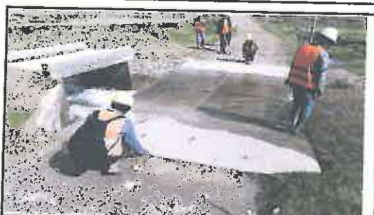
Foto N° 107: Badén de concreto de A = 4.0 m L = 6.7 m, existe un pontón para el paso peatonal, ubicado en la progresiva 29+560.
