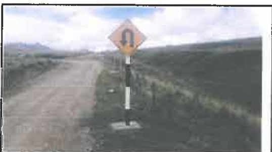
Foto N° 107: Señal preventiva de 0.8 x 0.8 m en buen estado, alerta de una curva en "U" a la izquierda, ubicada en la progresiva 21+095.
