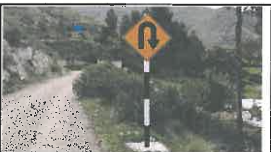
Foto N° 45: Señal preventiva de 0.8 x 0.8 m en buen estado, alerta de una curva en "U" a la derecha, ubicada en la progresiva 04+370.
