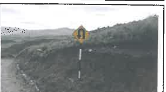
Foto N° 152: Señal preventiva de 0.8 x 0.8 m en buen estado, alerta de una curva en "U" a la izquierda, ubicada en la progresiva 25+390.
