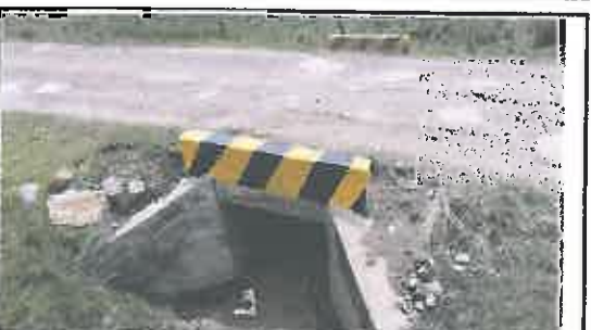
Foto N° 88: Alcantarilla tipo marco de 0.8 x 0.9 m en buen estado, ubicada en la progresiva 21+810.
