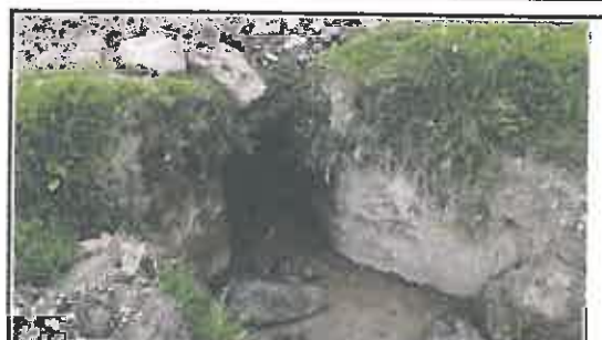
Foto N° 38: Salida de alcantarilla de mampostería, pequeña erosión en la plataforma, ubicada en la progresiva 10+973.
