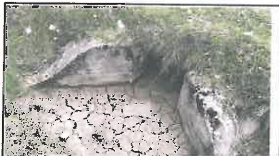
Foto N° 25: Entrada de alcantarilla de mampostería semiobstruida de 0.6 x 0.8 m, ubicada en la progresiva 08+075.
