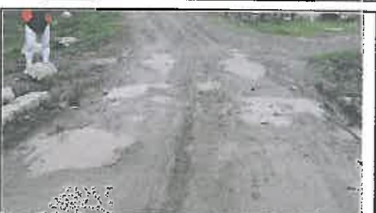
Foto N° 104: Evidencia de baches afectando la plataforma en el Km 17+890
