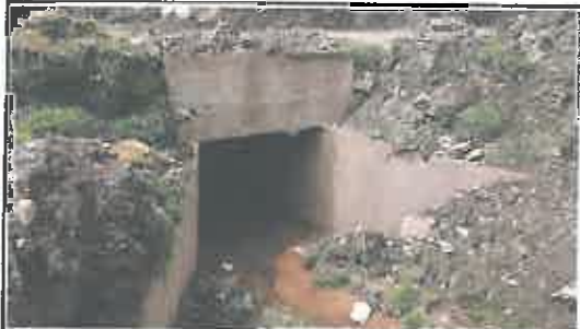
Foto N° 9: Cabezal de salida de alcantarilla de concreto tipo marco, ubicada en la progresiva 02+600.
