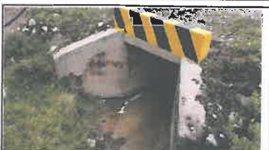
Foto N° 84: Alcantarilla tipo marco de 1.0 x 1.0 m en buen estado, ubicada en la progresiva 20+645.
