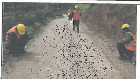
Foto N° 59: Prueba de la anchura de la superficie de rodadura en el Km 02+900.
