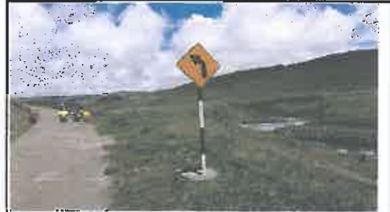
Foto N° 122: Señal preventiva de 0.8 x 0.8 m en buen estado, alerta de una curva a la izquierda, ubicada en la progresiva 23+518.
