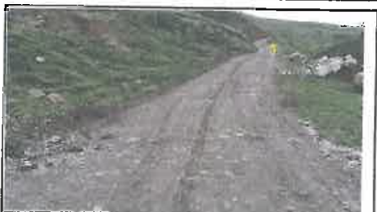
Foto N° 55: Evidencia de cruce de agua afectando la plataforma en el Km 11+685
