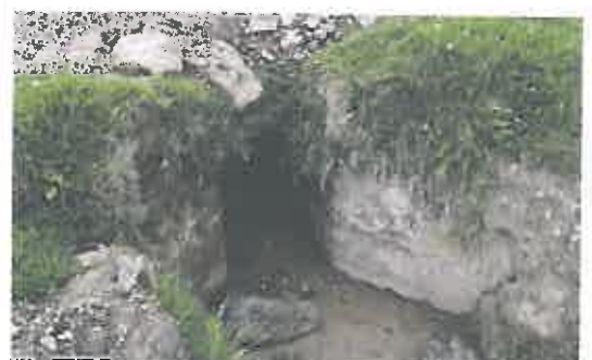
Alcantarilla de mampostería y losa de troncos de madera en mal estado, ubica en la progresiva 10+973
