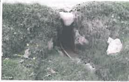
Alcantarilla de mampostería y losa de troncos de madera en mal estado, ubicada en la progresiva 16+970
