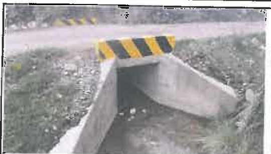
Foto N° 91: Alcantarilla tipo marco de 0.8 x 1.0 m en buen estado, ubicada en la progresiva 22+565.
