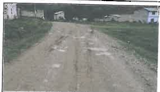
Foto N° 20: Evidencia de baches afectando la plataforma en el Km 03+845
