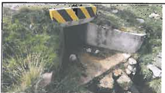
Foto N° 101: Alcantarilla tipo marco de 0.8 x 0.9 m en buen estado, ubicada en la progresiva 27+820.
