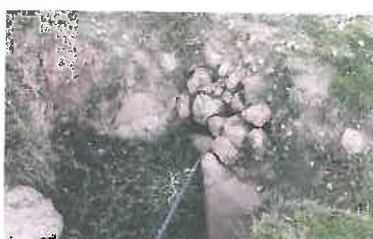
Alcantarilla de mampostería y losa de troncos de madera en mal estado, ubica en la progresiva 11+412
