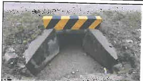
Foto N° 92: Alcantarilla tipo marco de 0.8 x 0.8 m en buen estado, ubicada en la progresiva 22+990.
