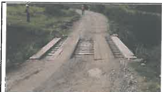
Foto N° 1: Pontón de madera de A=4.0m y L=4.8m en regular estado, ubicado en la progresiva 00+290.
