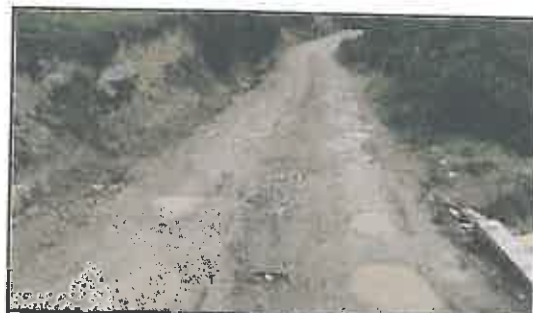
Foto N° 18: Evidencia de baches afectando la plataforma en el Km 03+085
