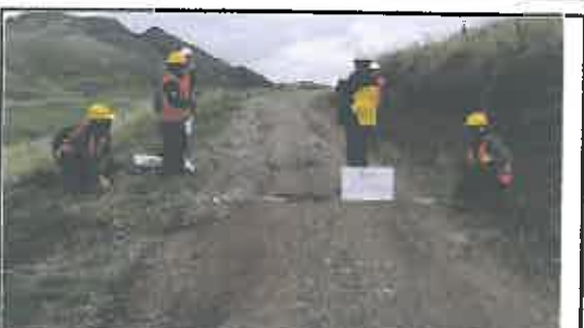
Foto N° 526: Prueba de la anchura de la superficie de rodadura en el Km 26+250.
