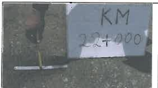
Foto N° 89: Desgaste del espesor del afirmado
