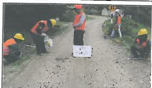
Foto N° 86: Prueba de la anchura de la superficie de rodadura en el Km 04+250.
