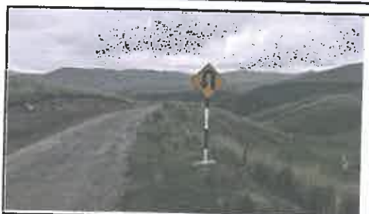
Foto N° 158: Señal preventiva de 0.8 x 0.8 m en buen estado, alerta de una curva en "U" a la izquierda, ubicada en la progresiva 25+600.
