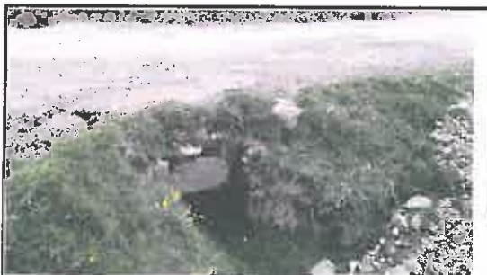
Foto N° 65: Alcantarilla de mampostería semiobstruida, ubicada en la progresiva 16+420.
