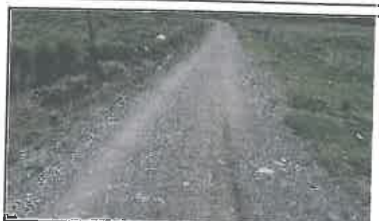
Foto N° 120: Evidencia de erosión afectando la plataforma en el Km 21+350
