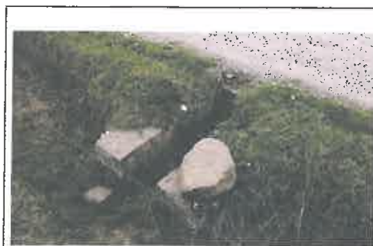
Tajea de piedra colapsada, ubicada en la progresiva 10+015
