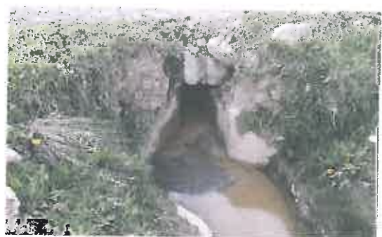
Alcantarilla de mampostería y losa de troncos de madera en mal estado, ubica en la progresiva 15+230
