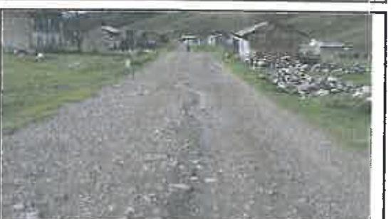
Foto N° 64: Evidencia de erosión afectando la plataforma en el Km 12+950
