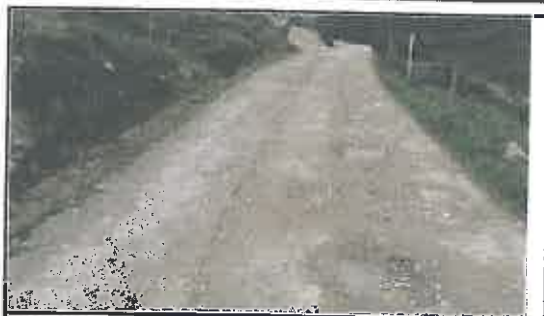
Foto N° 40: Evidencia de baches afectando la plataforma en el Km 07+940
