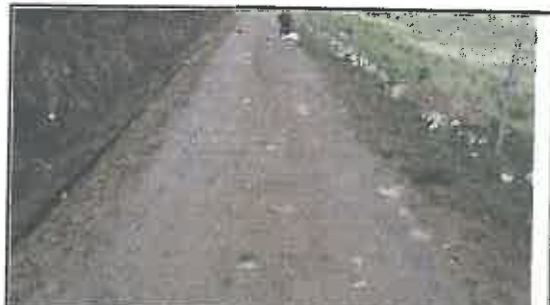
Foto N° 154: Evidencia de erosión afectando la plataforma en el Km 27+260
