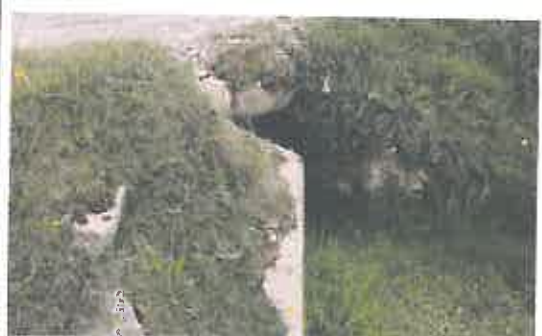
Alcantarilla de mampostería y losa de troncos de madera en mal estado, ubica en la progresiva 14+398
