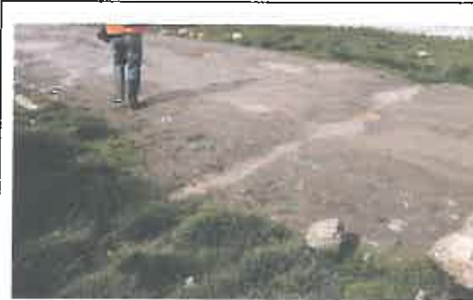
Salida de alcantarilla de concreto semi obstruida, ubicada en la progresiva 17+976
