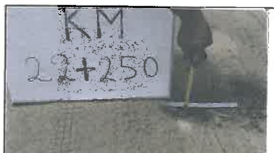
Foto N° 90: Desgaste del espesor del afirmado
