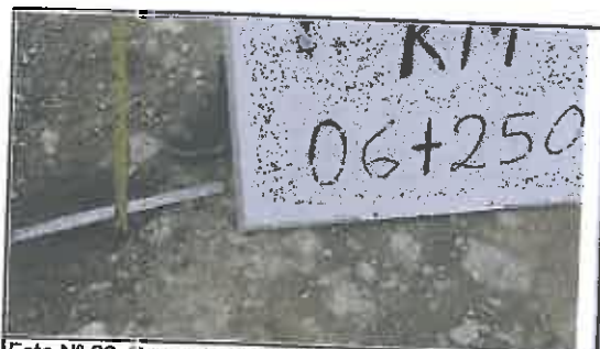
Foto N° 26: Desgaste del espesor del afirmado
