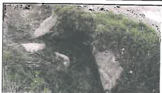
Foto N° 30: Entrada de alcantarilla de mampostería semiobstruida, ubicada en la progresiva 09+328.
