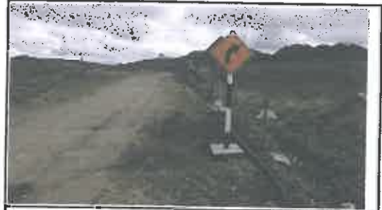
Foto N° 170: Señal preventiva de 0.8 x 0.8 m en buen estado, alerta de una curva a la derecha, v28+511.
