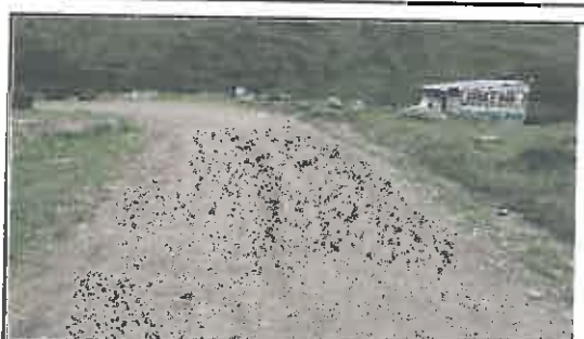
Foto N° 21: Evidencia de erosión afectando la plataforma en el Km 04+125
