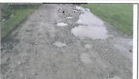
Foto N° 61: Evidencia de cruce de agua afectando la plataforma en el Km 12+695
