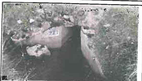
Foto N° 54: Alcantarilla de mampostería con losa de madera, ubicada en la progresiva 15+153.
