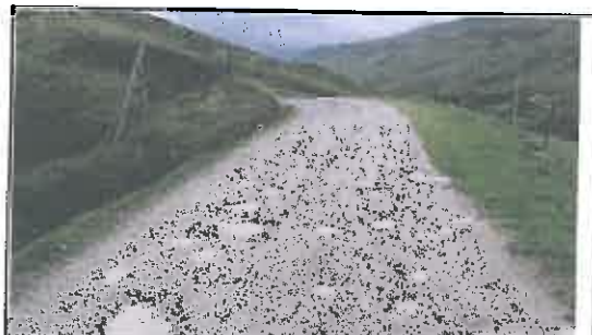
Foto N° 49: Evidencia de baches afectando la plataforma en el Km 10+120
