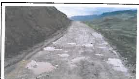
Foto N° 10: Se aprecia un talud inestable ubicado entre las progresivas Km 15+950 - Km 16+100.
