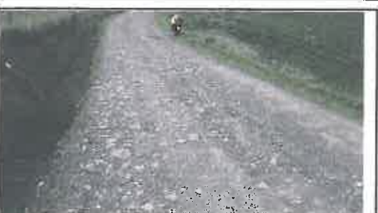
Foto N° 79: Evidencia de erosión afectando la plataforma en el Km 15+260
