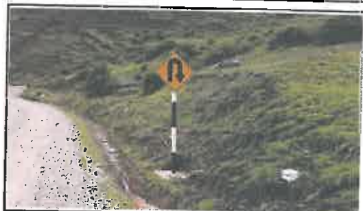
Foto N° 20: Señal preventiva de 0.8 x 0.8 m en buen estado, alerta de una curva en "U" a la derecha, ubicada en la progresiva 01+536.
