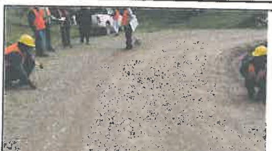
Foto N° 38: Prueba de la anchura de la superficie de rodadura en el Km 01+850.
