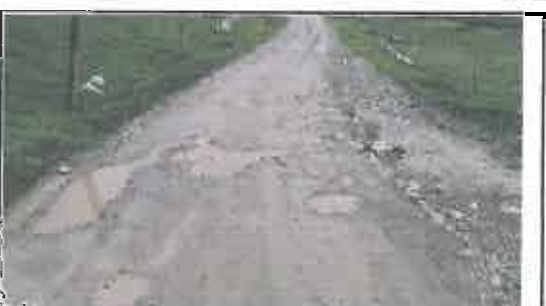
Foto N° 101: Evidencia de cruce de agua afectando la plataforma en el Km 17+375
