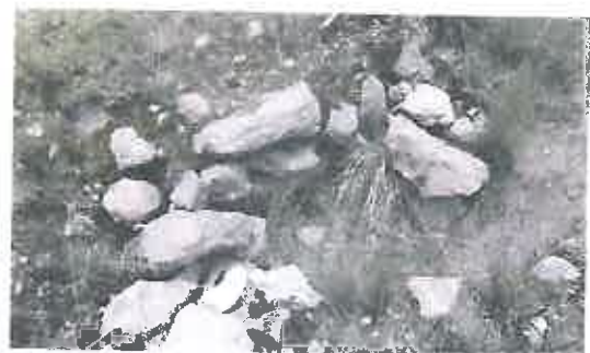
Tajea de piedra semi obstruida en regular estado, ubicada en la progresiva 22+493.
