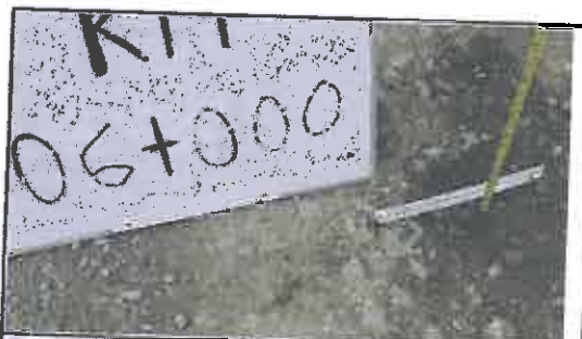
Foto N° 25: Desgaste del espesor del afirmado
