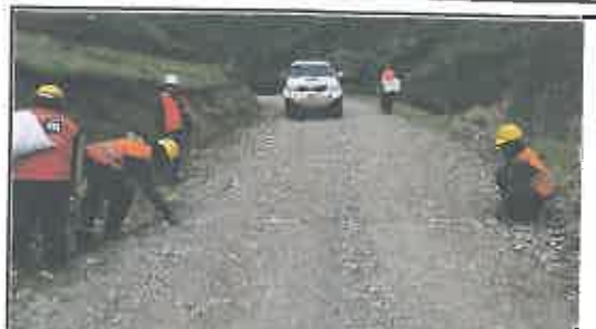
Foto N° 24: Prueba de la anchura de la superficie de rodadura en el Km 01+150.
