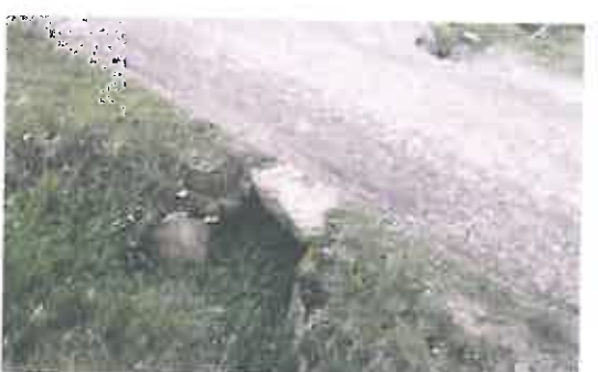
Alcantarilla de mampostería y losa de troncos de madera en mal estado, ubica en la progresiva 15+895
