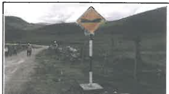
Foto N° 90: Señal preventiva de 0.8 x 0.8 m en buen estado, alerta de la proximidad de un badén, ubicada en la progresiva 17+510.
