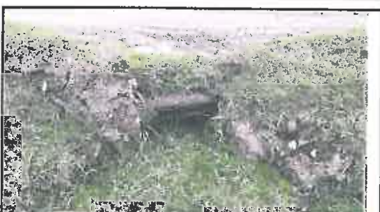
Foto N° 62: Alcantarilla con losa de madera, en mal estado, 16+095.
