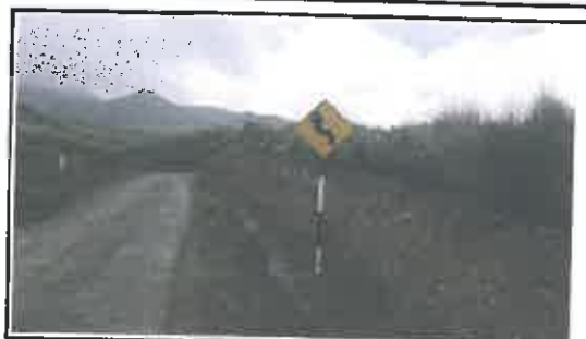
Foto N° 160: Señal preventiva de 0.8 x 0.8 m en buen estado, alerta de una curva en "S", ubicada en la progresiva 25+780.
