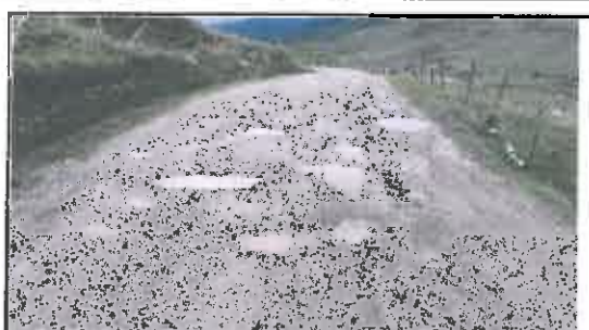
Foto N° 85: Evidencia de baches afectando la plataforma en el Km 15+780
