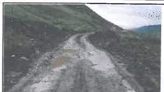
Foto N° 88: Evidencia de baches afectando la plataforma en el Km 16+050
