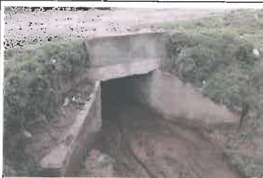
Salida de alcantarilla de concreto semi obstruida, ubicada en la progresiva 02+370
