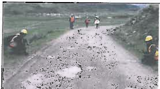
Foto N° 337: Prueba de la anchura de la superficie de rodadura en el Km 16+800.
