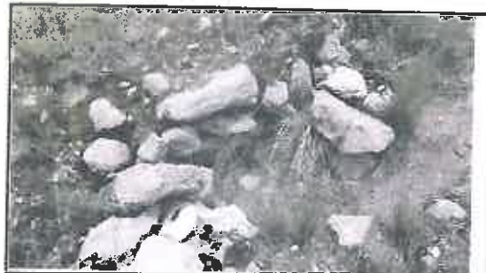
Foto N° 90: Tajera de piedra en regular estado y semiobstruida, ubicada en la progresiva 22+493.
