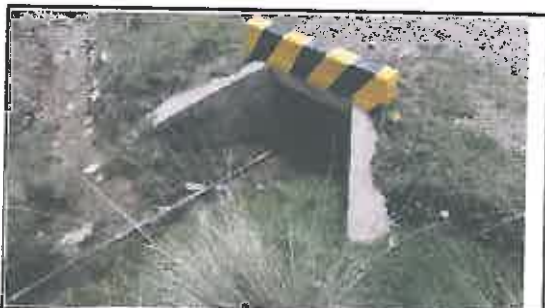
Foto N° 89: Alcantarilla tipo marco de 0.8 x 0.8 m en buen estado, ubicada en la progresiva 22+235.
