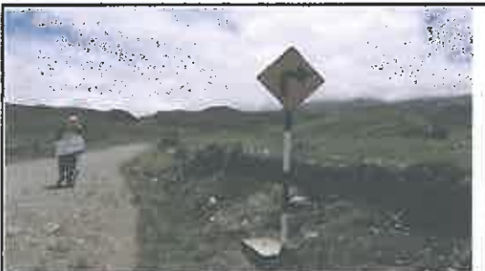
Foto N° 125: Señal preventiva de 0.8 x 0.8 m en buen estado, alerta de una curva pronunciada a la derecha, ubicada en la progresiva 23+610.
