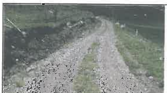
Foto N° 138: Evidencia de erosión afectando la plataforma en el Km 24+095
