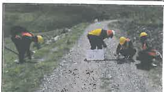
Foto N° 486: Prueba de la anchura de la superficie de rodadura en el Km 24+250.
