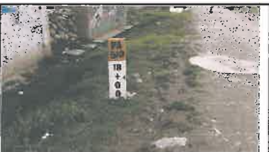
Foto N° 93: Poste kilométrico en regular estado con una leve inclinación, ubicado en la progresiva 17+920.
