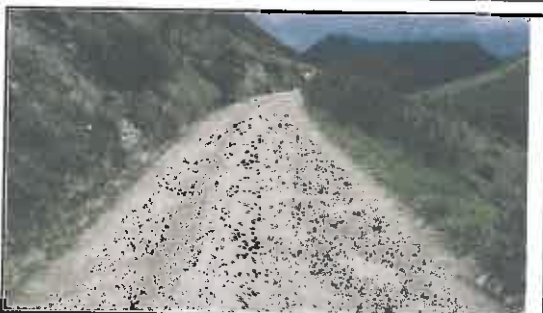
Foto N° 35: Evidencia de erosión afectando la plataforma en el Km 07+240
