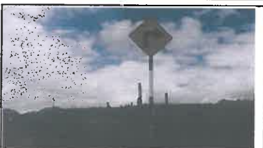
Foto N° 111: Señal preventiva de 0.8 x 0.8 m en buen estado, alerta de una curva pronunciada a la derecha, ubicada en la progresiva 21+410.
