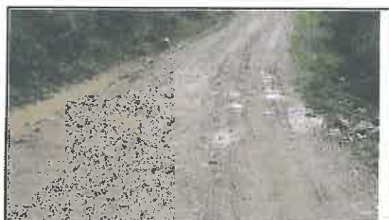
Foto N° 1: Evidencia de cruce de agua afectando la plataforma en el Km 00+050
