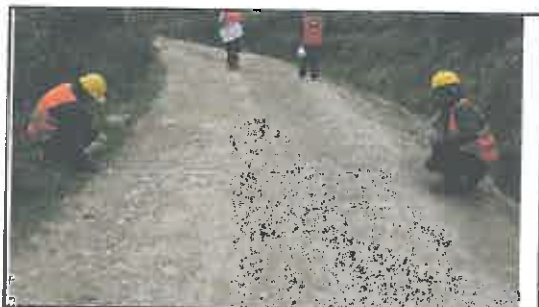
Foto N° 153: Prueba de la anchura de la superficie de rodadura en el Km 07+600.
