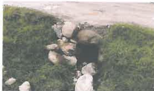
Tajea de piedra colapsada ubicada en la progresiva 17+720
