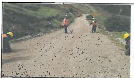
Foto N° 33: Prueba de la anchura de la superficie de rodadura en el Km 01+600.
