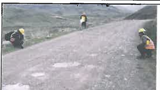
Foto N° 307: Prueba de la anchura de la superficie de rodadura en el Km 15+300.
