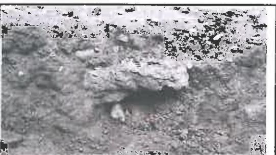
Foto N° 61: Tajera de piedra obstruida, ubicada en la progresiva 15+978.
