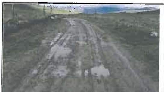
Foto N° 161: Evidencia de baches afectando la plataforma en el Km 28+380
