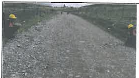
Foto N° 290: Prueba de la anchura de la superficie de rodadura en el Km 14+450.
