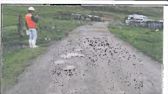
Foto N° 102: Evidencia de baches afectando la plataforma en el Km 17+500
