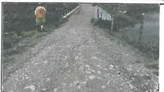
Foto N° 136: Evidencia de erosión afectando la plataforma en el Km 23+680
