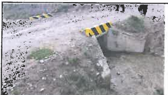
Foto N° 99: Alcantarilla tipo marco de 0.8 x 0.9 m en buen estado, ubicada en la progresiva 27+110.
