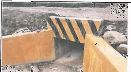
Foto N° 12: Cabezal de salida con aleta de alcantarilla tipo marco en buen estado, ubicada en la progresiva 03+091.
