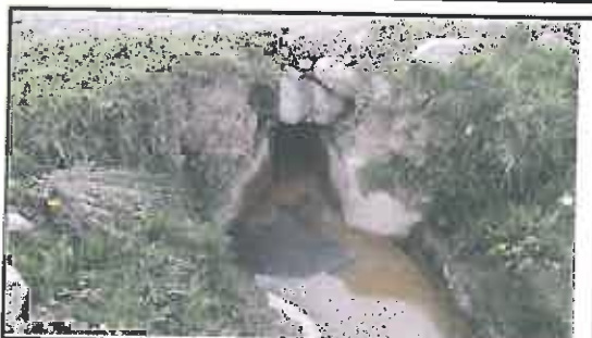
Foto N° 55: Alcantarilla de mampostería semiobstruida, ubicada en la progresiva 15+230.
