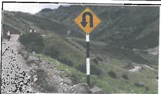
Foto N° 23: Señal preventiva de 0.8 x 0.8 m en buen estado, alerta de una curva en "U" a la izquierda, ubicada en la progresiva 01+634.
