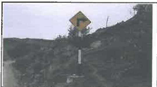
Foto N° 49: Señal preventiva de 0.8 x 0.8 m en buen estado, alerta de una curva pronunciada a la derecha, ubicada en la progresiva 04+632.
