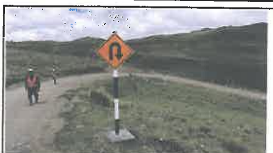
Foto N° 108: Señal preventiva de 0.8 x 0.8 m en buen estado, alerta de una curva en "U" a la derecha, ubicada en la progresiva 21+179.
