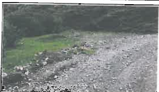
Foto N° 21: Plazoleta de cruce y volteo con terreno irregular y vegetación en la progresiva 01+575.
