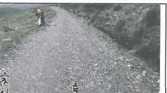
Foto N° 143: Evidencia de erosión afectando la plataforma en el Km 25+110
