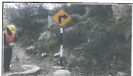
Foto N° 38: Señal preventiva en buen estado y con daños de pintura, alerta de una curva pronunciada a la derecha, ubicada en la progresiva 03+750.
