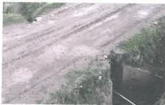
Alcantarilla de mampostería y losa de troncos de madera en mal estado, ubica en la progresiva 14+015
