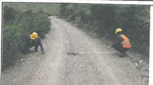
Foto N° 70: Prueba de la anchura de la superficie de rodadura en el Km 03+450.
