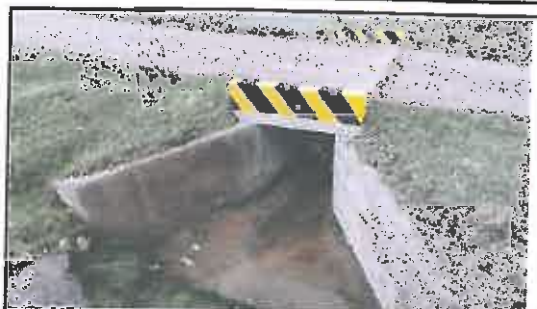
Foto N° 96: Alcantarilla tipo marco de 0.8 x 0.8 m en buen estado, ubicada en la progresiva 25+540.
