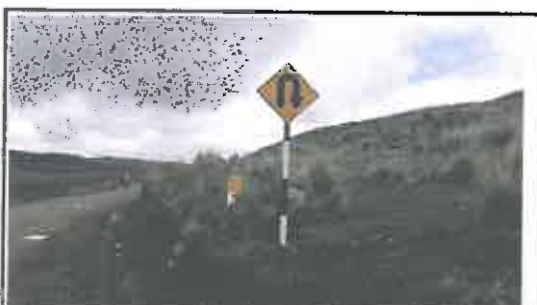
Foto N° 141: Señal preventiva de 0.8 x 0.8 m en buen estado, alerta de una curva en "U" a la derecha, ubicada en la progresiva 24+829.
