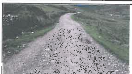
Foto N° 86: Evidencia de erosión afectando la plataforma en el Km 15+850
