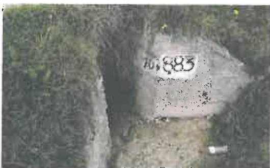
Alcantarilla de mampostería y losa de troncos de madera en mal estado, ubica en la progresiva 10+810
