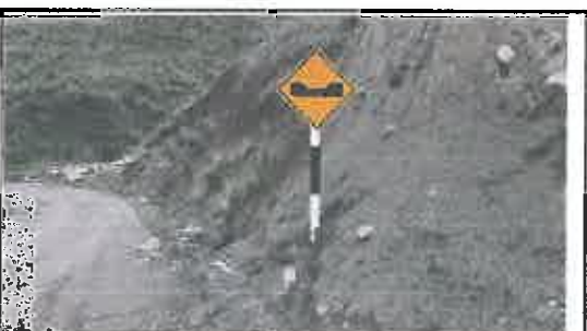
Foto N° 101: Señal preventiva de 0.8 x 0.8 m en buen estado, alerta la proximidad de un badén, ubicada en la progresiva 20+575.
