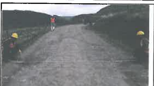
Foto N° 315: Prueba de la anchura de la superficie de rodadura en el Km 15+700.
