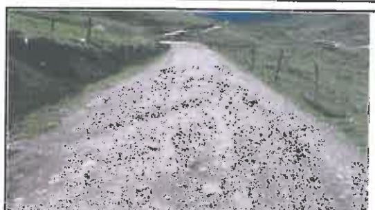
Foto N° 84: Evidencia de erosión afectando la plataforma en el Km 15+710
