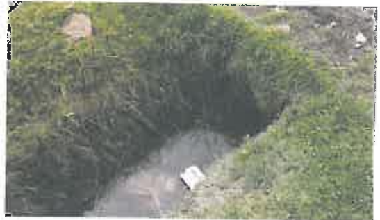
Tajea de piedra semi obstruida en regular estado, ubicada en la progresiva 17+527
