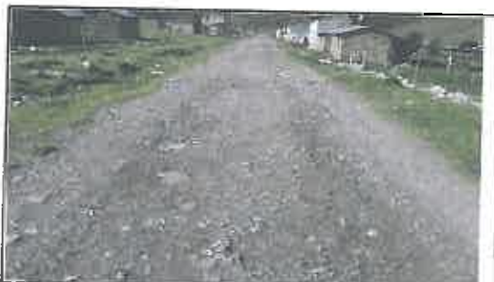
Foto N° 65: Evidencia de erosión afectando la plataforma en el Km 13+235
