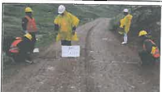
Foto N° 236: Prueba de la anchura de la superficie de rodadura en el Km 11+750.
