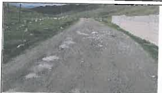
Foto N° 67: Evidencia de baches afectando la plataforma en el Km 13+450
