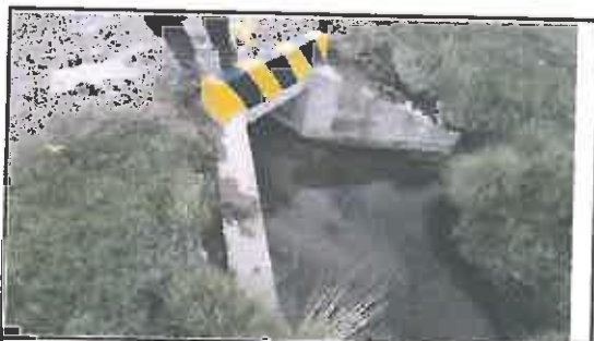
Foto N° 105: Alcantarilla tipo marco de 0.8 x 0.8 m en buen estado, ubicada en la progresiva 29+050.
