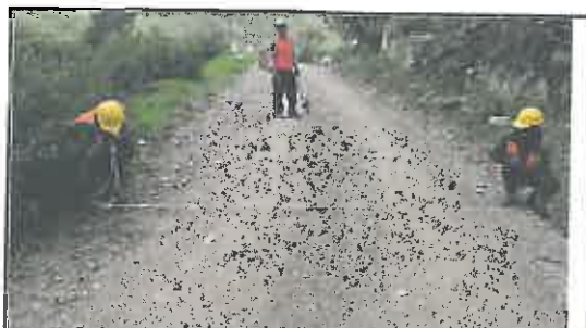
Foto N° 73: Prueba de la anchura de la superficie de rodadura en el Km 03+600.
