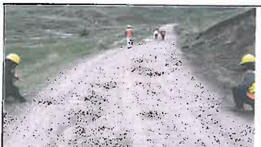
Foto N° 325: Prueba de la anchura de la superficie de rodadura en el Km 16+200.
