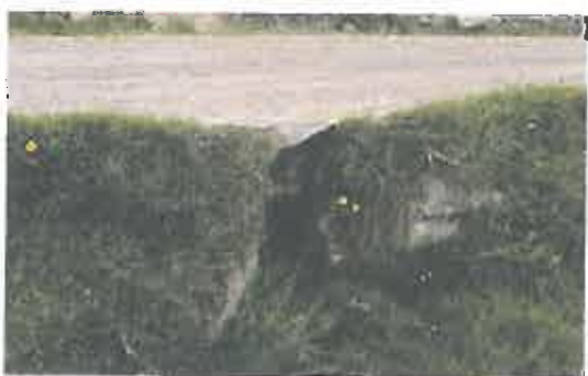
Alcantarilla de mampostería y losa de troncos de madera en mal estado, ubica en la progresiva 09+208
