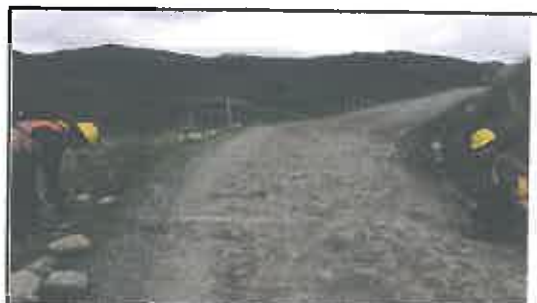
Foto N° 314: Prueba de la anchura de la superficie de rodadura en el Km 15+650.
