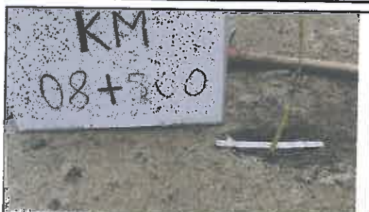
Foto N° 35: Desgaste del espesor del afirmado
