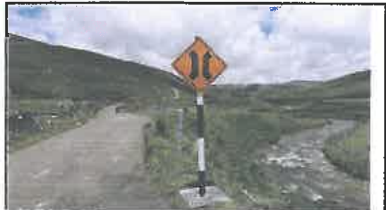
Foto N° 126: Señal preventiva de 0.8 x 0.8 m en buen estado, alerta de un puente angosto, ubicada en la progresiva 23+634.
