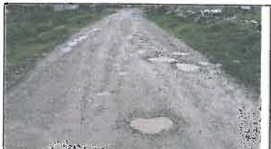
Foto N° 108: Evidencia de baches afectando la plataforma en el Km 18+220
