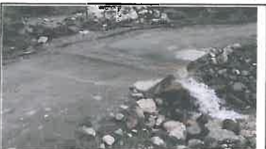
Foto N° 83: Badén de A = 4.3 m y L = 5.4 m, ubicado en la progresiva 20+620.
