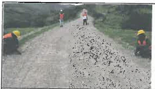
Foto N° 133: Prueba de la anchura de la superficie de rodadura en el Km 06+600.
