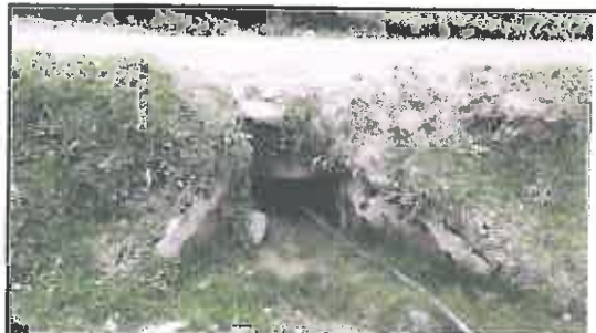
Foto N° 66: Salida de alcantarilla en regular estado, ubicada en la progresiva 16+675.
