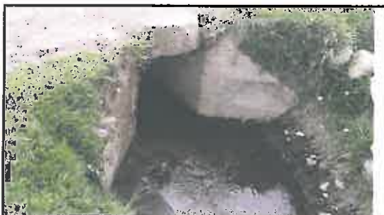
Foto N° 57: Salida de alcantarilla en regular estado, ubicada en la progresiva 15+528.
