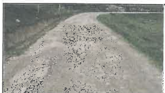
Foto N° 42: Evidencia de baches afectando la plataforma en el Km 08+445
