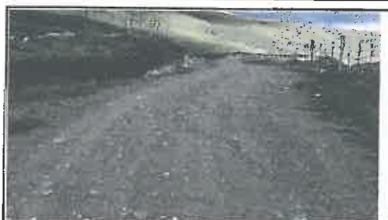
Foto N° 167: Evidencia de erosión afectando la plataforma en el Km 29+485
