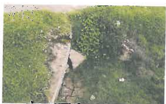
Alcantarilla de mampostería y losa de troncos de madera en mal estado, ubica en la progresiva 12+237
