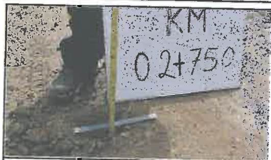
Foto N° 12: Desgaste del espesor del afirmado
