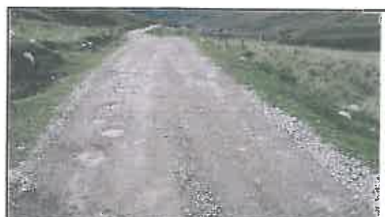
Foto N° 74: Evidencia de baches afectando la plataforma en el Km 14+390
