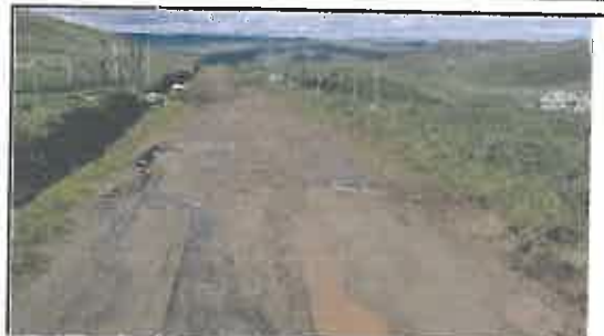
Foto N° 156: Evidencia de erosión afectando la plataforma en el Km 27+465
