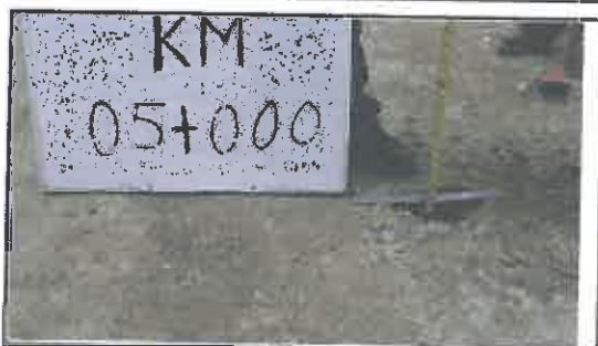
Foto N° 21: Desgaste del espesor del afirmado
