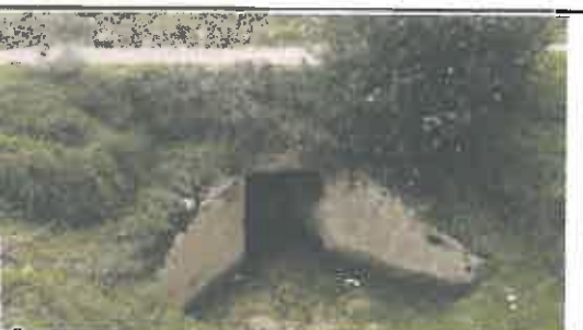
Foto N° 23: Alcantarilla de mampostería de 0.6 x 0.8 m con losa de madera, ubicada en la progresiva 07+719.
