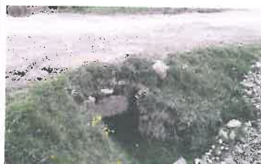
Alcantarilla de mampostería y losa de troncos de madera en mal estado, ubicada en la progresiva 16+420
