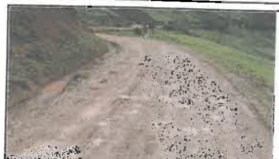
Foto N° 16: Evidencia de baches afectando la plataforma en el Km 02+370
