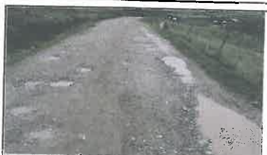
Foto N° 70: Evidencia de erosión afectando la plataforma en el Km 13+850
