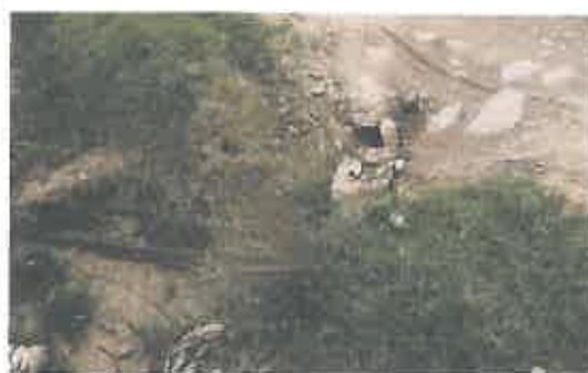
Alcantarilla de mampostería y losa de troncos de madera en mal estado, ubica en la progresiva 07+614
