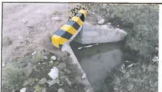
Foto N° 103: Alcantarilla tipo marco de 0.8 x 0.9 m en buen estado, ubicada en la progresiva 28+210.
