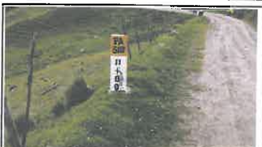
Foto N° 76: Poste kilométrico con desgaste de pintura, ubicado en la progresiva 10+930.
