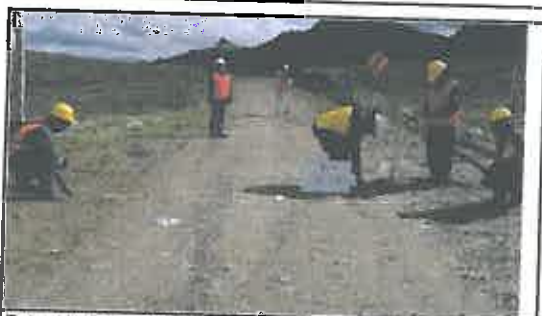
Foto N° 571: Prueba de la anchura de la superficie de rodadura en el Km 28+500.
