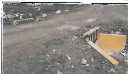
Foto N° 76: Alcantarilla tipo marco de 0.8 \times 0.6 \text{ m} en buen estado, ubicada en la progresiva 17+890.
