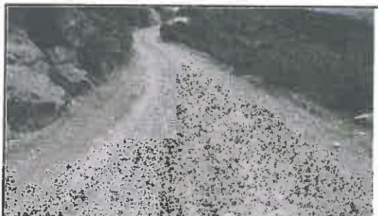
Foto N° 27: Evidencia de erosión afectando la plataforma en el Km 05+630
