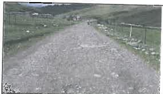
Foto N° 66: Evidencia de erosión afectando la plataforma en el Km 13+340
