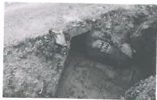
Alcantarilla de mampostería y losa de troncos de madera en mal estado, ubica en la progresiva 05+717
