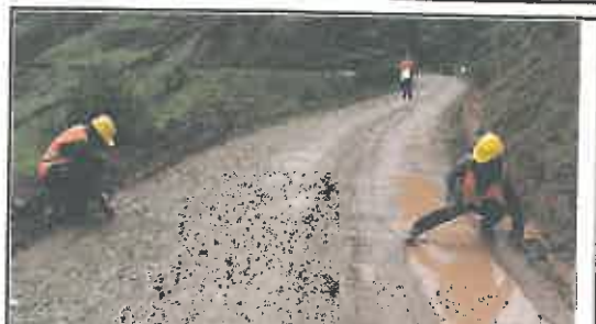
Foto N° 40: Prueba de la anchura de la superficie de rodadura en el Km 01+950.
