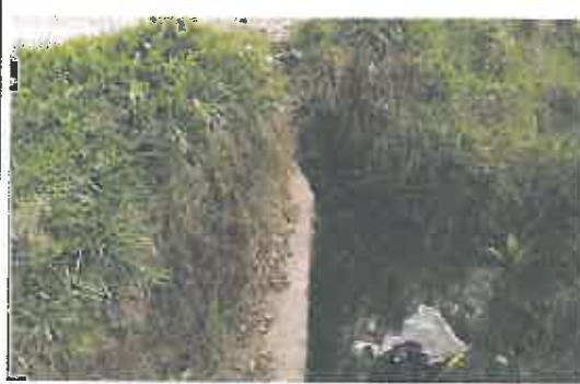
Alcantarilla de mampostería y losa de troncos de madera en mal estado, ubica en la progresiva 09+788
