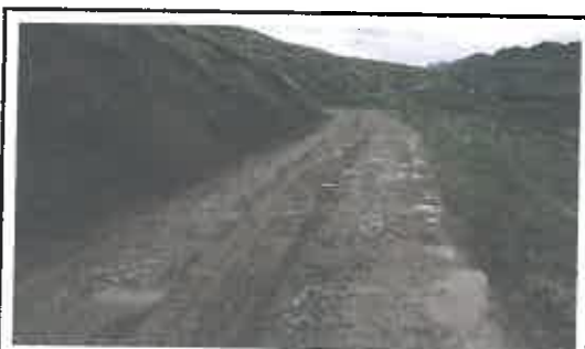
Foto N° 7: Se aprecia un talud inestable ubicado entre las progresivas Km 11+510 - Km 11+690.
