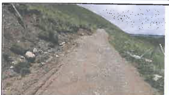
Foto N° 134: Evidencia de erosión afectando la plataforma en el Km 23+460
