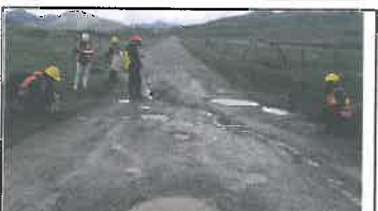
Foto N° 389: Prueba de la anchura de la superficie de rodadura en el Km 19+400.
