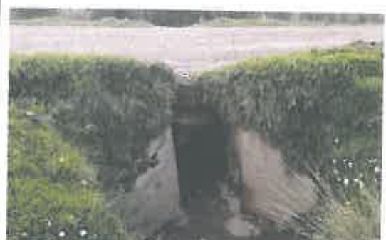
Alcantarilla de mampostería y losa de troncos de madera en mal estado, ubica en la progresiva 14+971
