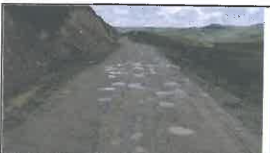
Foto N° 132: Evidencia de baches afectando la plataforma en el Km 23+150
