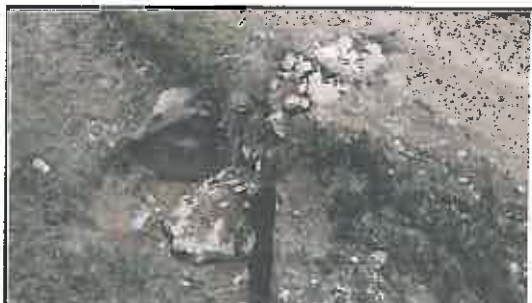
Foto N° 17: Alcantarilla de mampostería obstruida con rocas, ubicada en la progresiva 05+038.
