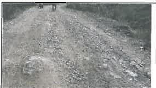
Foto N° 3: Evidencia de erosión afectando la plataforma en el Km 00+255
