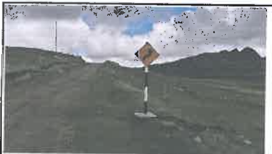
Foto N° 175: Señal preventiva de 0.8 x 0.8 m en buen estado, alerta de una curva en "S", ubicada en la progresiva 28+936.
