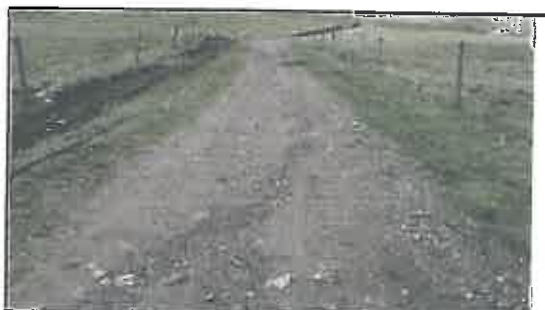
Foto N° 162: Evidencia de erosión afectando la plataforma en el Km 28+500
