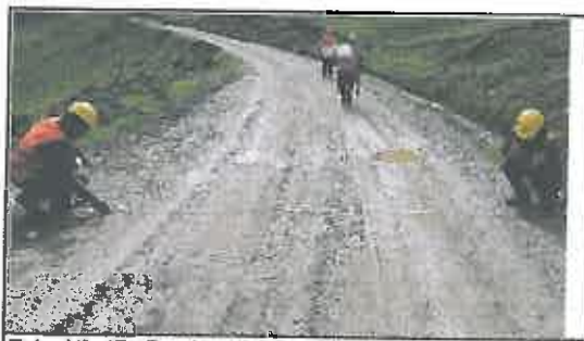
Foto N° 17: Prueba de la anchura de la superficie de rodadura en el Km 00+800.
