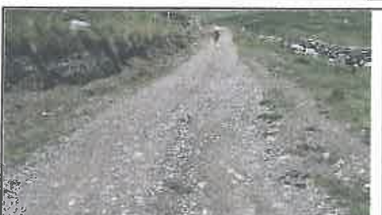
Foto N° 139: Evidencia de erosión afectando la plataforma en el Km 24+420
