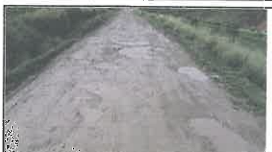
Foto N° 76: Evidencia de baches afectando la plataforma en el Km 14+900
