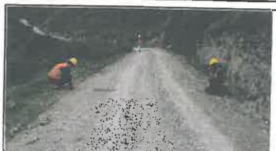
Foto N° 110: Prueba de la anchura de la superficie de rodadura en el Km 05+450.
