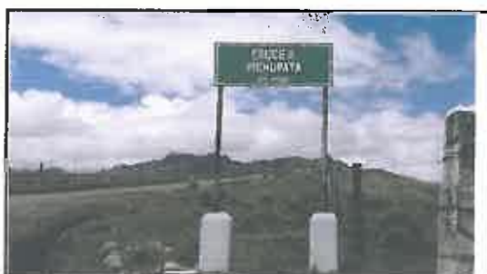
Foto N° 109: Señal informativa de 1.5 x 0.6 m en buen estado, indica el desvío a Pichupata, ubicada en la progresiva 21+195.
