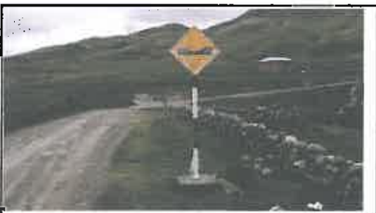
Foto N° 91: Señal preventiva de 0.8 x 0.8 m en buen estado, alerta de la proximidad de un badén, ubicada en la progresiva 17+636.
