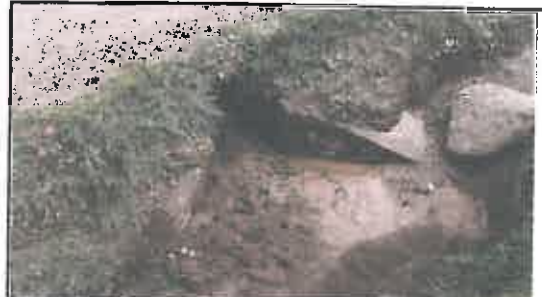
Foto N° 10: Alcantarilla de Mampostería y losa con troncos de madera, ubicada en la progresiva 02+722.
