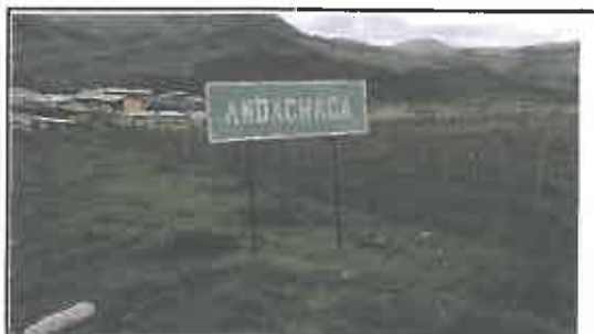
Foto N° 92: Señal informativa de 1.8 x 0.6 m en mal estado, indica el pueblo de Andachaca, ubicada en la progresiva 17+771.
