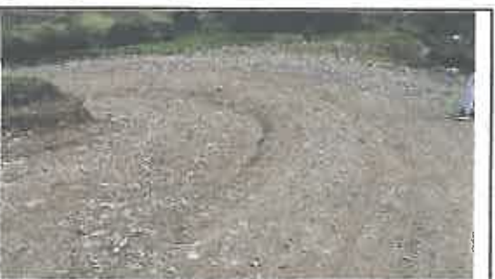
Foto N° 7: Evidencia de erosión afectando la plataforma en el Km 01+585
