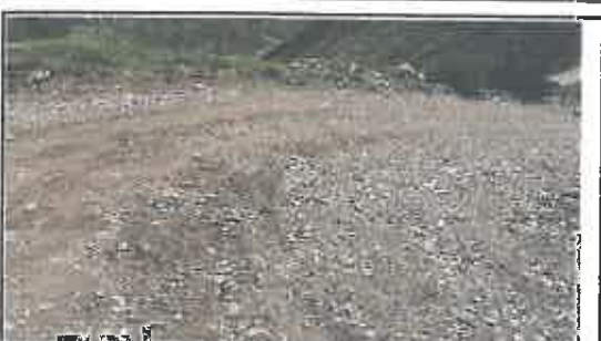
Foto N° 8: Evidencia de erosión afectando la plataforma en el Km 01+690
