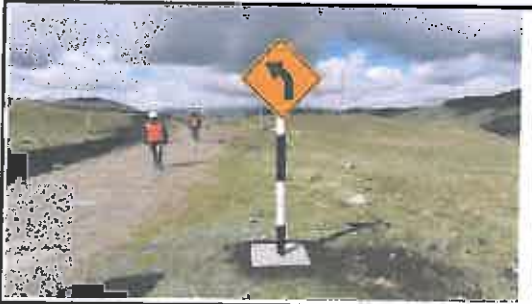
Foto N° 171: Señal preventiva de 0.8 x 0.8 m en buen estado, alerta de una curva a la izquierda, ubicada en la progresiva 28+584.
