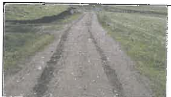
Foto N° 170: Evidencia de erosión afectando la plataforma en el Km 29+710
