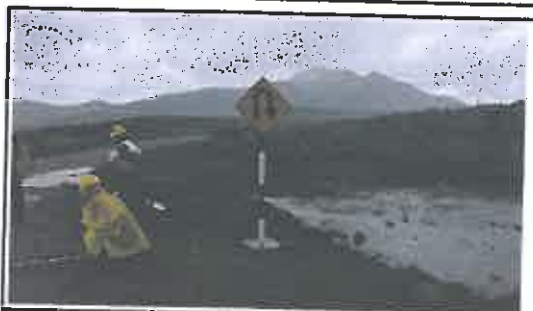
Foto N° 156: Señal preventiva de 0.8 x 0.8 m en buen estado, alerta de una curva en "U" a la derecha.
