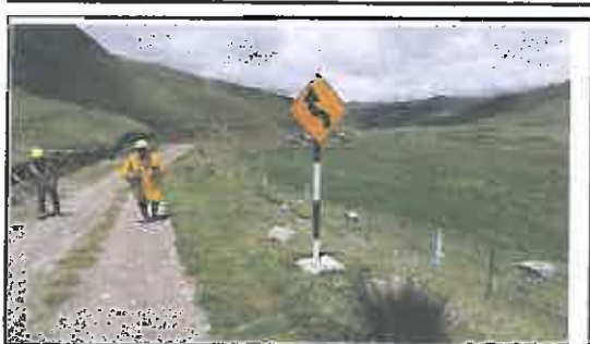
Foto N° 131: Señal preventiva de 0.8 x 0.8 m en buen estado, alerta de una curva en "S", ubicada en la progresiva 23+980.
