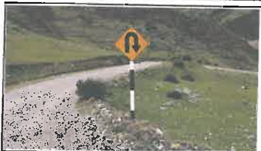
Foto N° 19: Señal preventiva de 0.8 x 0.8 m en buen estado, alerta de una curva en "U" a la derecha, ubicada en la progresiva 01+392.
