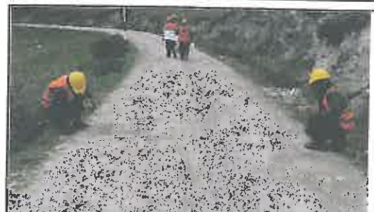
Foto N° 168: Prueba de la anchura de la superficie de rodadura en el Km 08+350.
