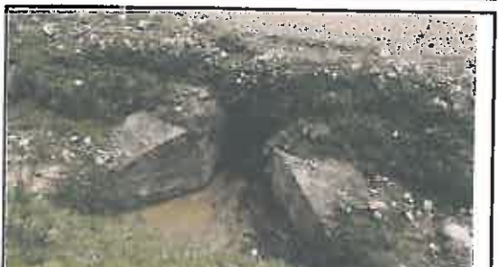
Foto N° 16: Entrada de alcantarilla de mampostería de 0.6 x 0.8 m, ubicada en la progresiva 04+846.
