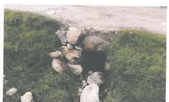
Alcantarilla de mampostería y losa de troncos de madera en mal estado, ubicada en la progresiva 17+420
