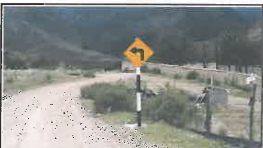
Foto N° 51: Señal preventiva de 0.8 x 0.8 m en buen estado, alerta de una curva pronunciada a la izquierda, ubicada en la progresiva 04+760.
