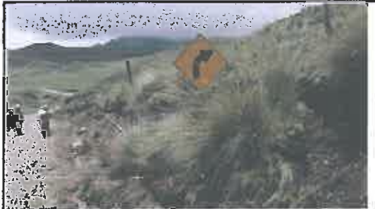
Foto N° 121: Señal preventiva de 0.8 x 0.8 m en buen estado, alerta de una curva a la derecha, ubicada en la progresiva 23+420.
