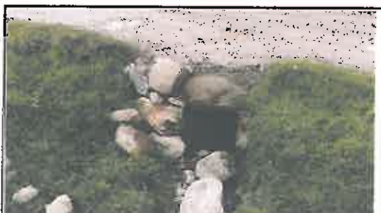
Foto N° 71: Alcantarilla en mal estado cubierto de rocas, ubicada en la progresiva 17+420.
