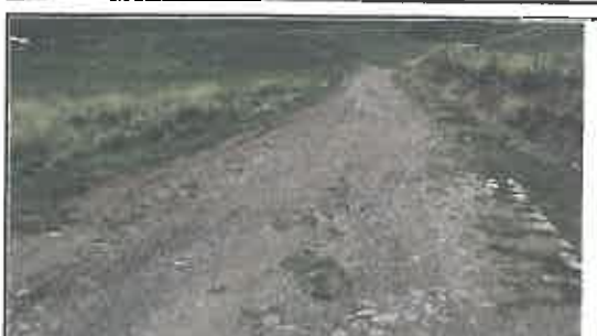
Foto N° 140: Evidencia de erosión afectando la plataforma en el Km 24+630
