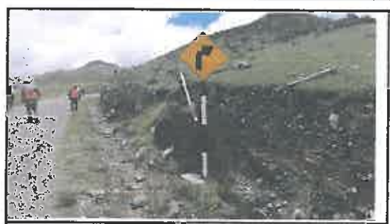
Foto N° 133: Señal preventiva de 0.8 x 0.8 m en buen estado, alerta de una curva a la derecha, ubicada en la progresiva 24+135.
