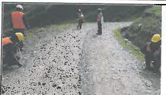
Foto N° 19: Prueba de la anchura de la superficie de rodadura en el Km 00+900.
