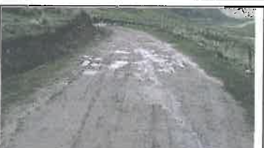
Foto N° 141: Evidencia de baches afectando la plataforma en el Km 24+850
