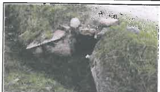
Foto N° 32: Entrada de alcantarilla de mampostería semiobstruida, ubicada en la progresiva 09+960.
