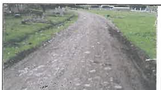
Foto N° 58: Evidencia de erosión afectando la plataforma en el Km 12+400
