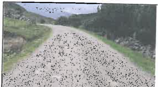
Foto N° 50: Evidencia de baches afectando la plataforma en el Km 10+380
