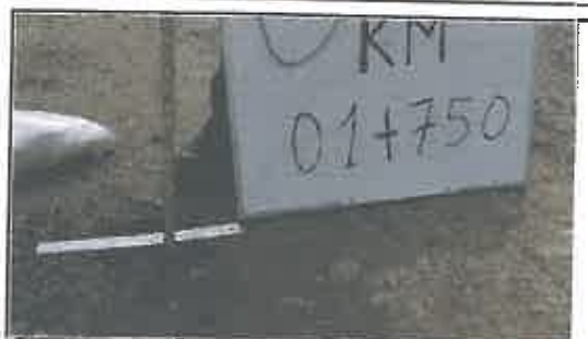
Foto N° 8: Desgaste del espesor del afirmado
