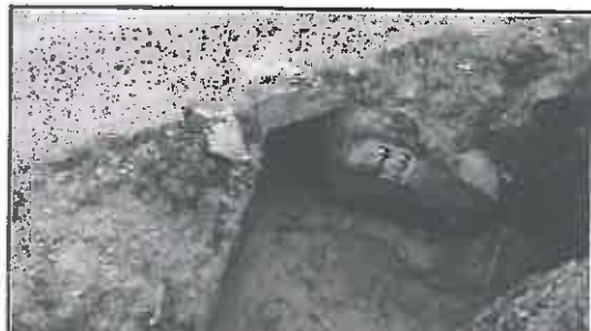
Foto N° 18: Alcantarilla de mampostería de 0.6 x 0.8 m, ubicada en la progresiva 05+717.
