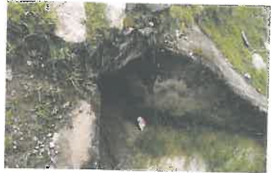
Alcantarilla de mampostería y losa de troncos de madera en mal estado, ubica en la progresiva 03+316
