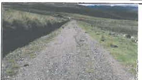
Foto N° 148: Evidencia de erosión afectando la plataforma en el Km 26+085
