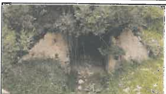
Foto N° 20: Salida de alcantarilla de mampostería de 0.6 x 0.8 m, ubicada en la progresiva 06+985.
