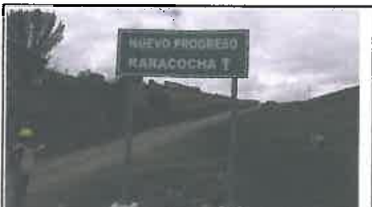
Foto N° 99: Señal informativa de 1.5 x 0.6 m en buen estado, indica la ruta a Nuevo Progreso, ubicada en la progresiva 19+931.
