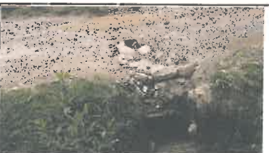
Foto N° 21: Salida de alcantarilla de mampostería obstruida, ubicada en la progresiva 07+405.
