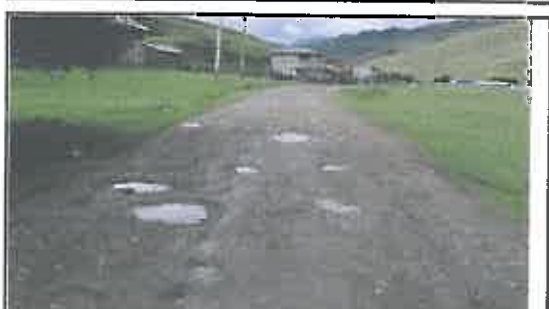
Foto N° 60: Evidencia de cruce de agua afectando la plataforma en el Km 12+595
