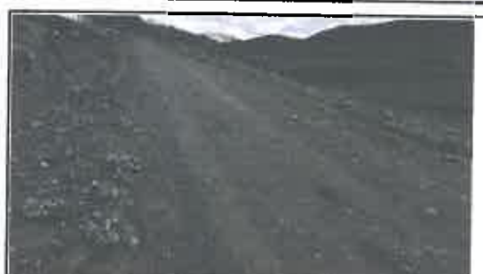
Foto N° 166: Evidencia de erosión afectando la plataforma en el Km 29+245
