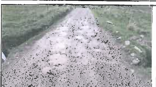
Foto N° 78: Evidencia de baches afectando la plataforma en el Km 15+230
