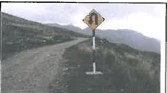
Foto N° 147: Señal preventiva de 0.8 x 0.8 m en buen estado, alerta de una curva en "U" a la izquierda, ubicada en la progresiva 25+030.
