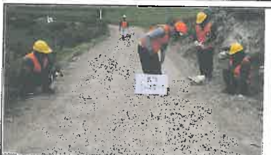
Foto N° 91: Prueba de la anchura de la superficie de rodadura en el Km 04+500.
