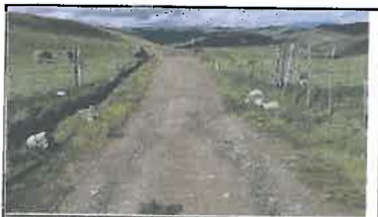
Foto N° 157: Evidencia de erosión afectando la plataforma en el Km 27+680
