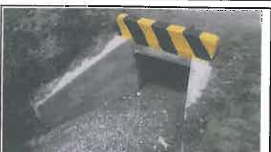
Foto N° 86: Alcantarilla tipo marco de 0.8 x 0.8 m en buen estado, ubicada en la progresiva 21+220.
