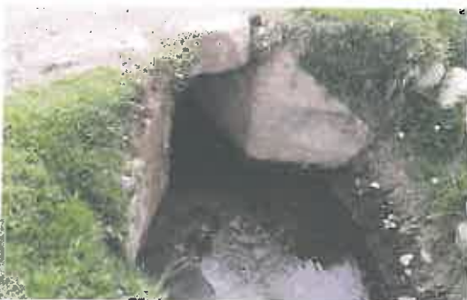
Alcantarilla de mampostería y losa de troncos de madera en mal estado, ubica en la progresiva 15+528
