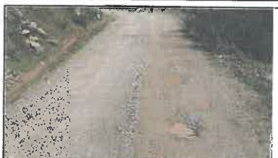
Foto N° 4: Evidencia de baches afectando la plataforma en el Km 00+515
