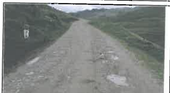
Foto N° 56: Evidencia de baches afectando la plataforma en el Km 11+900
