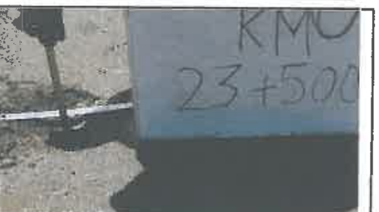
Foto N° 95: Desgaste del espesor del afirmado
