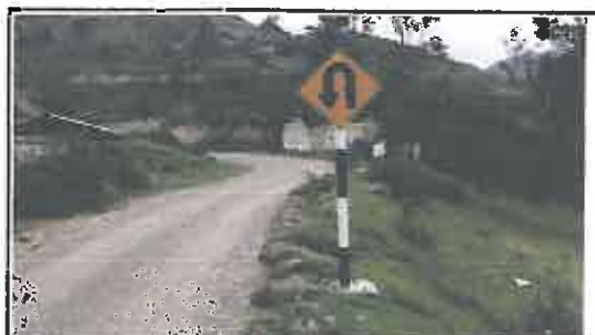
Foto N° 44: Señal preventiva de 0.8 x 0.8 m en buen estado, alerta de una curva en "U" a la izquierda, ubicada en la progresiva 04+260.
