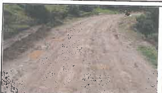
Foto N° 13: Evidencia de baches afectando la plataforma en el Km 02+260
