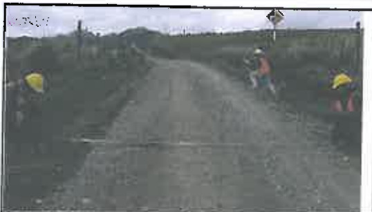
Foto N° 429: Prueba de la anchura de la superficie de rodadura en el Km 21+400.
