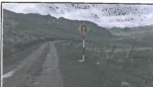
Foto N° 142: Señal preventiva de 0.8 x 0.8 m en buen estado, alerta de una curva en "U" a la derecha, ubicada en la progresiva 24+830.
