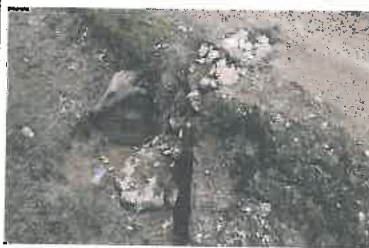
Alcantarilla de mampostería y losa de troncos de madera en mal estado, ubica en la progresiva 05+038
