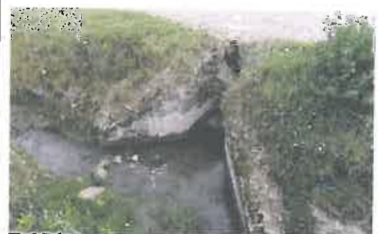
Alcantarilla de mampostería y losa de troncos de madera en mal estado, ubica en la progresiva 10+714
