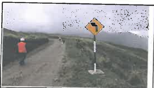
Foto N° 153: Señal preventiva de 0.8 x 0.8 m en buen estado, alerta de una curva a la izquierda, ubicada en la progresiva 25+480.
