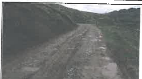
Foto N° 54: Evidencia de baches afectando la plataforma en el Km 11+520
