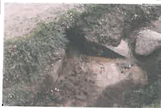
Alcantarilla de mampostería y losa de troncos de madera en mal estado, ubica en la progresiva 02+722
