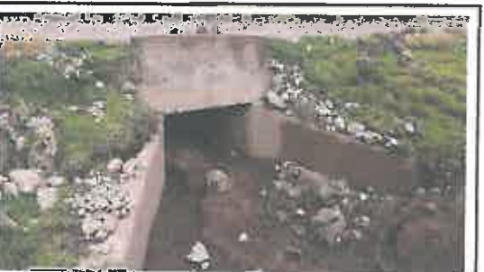
Foto N° 7: Cabezal de entrada tipo caja de alcantarilla tipo marco, ubicada en la progresiva 02+450.
