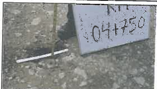
Foto N° 20: Desgaste del espesor del afirmado
