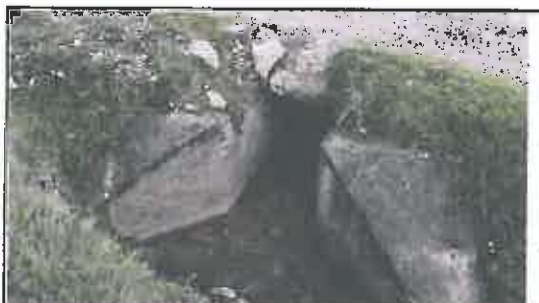
Foto N° 41: Alcantarilla de mampostería de 0.6 x 0.8 m, ubicada en la progresiva 11+360.
