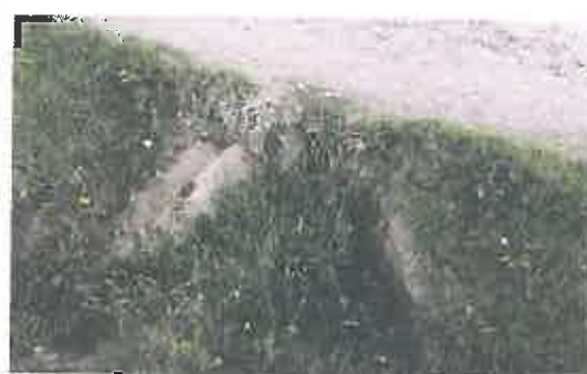
Alcantarilla de mampostería y losa de troncos de madera en mal estado, ubica en la progresiva 11+112
