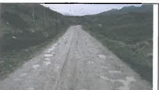
Foto N° 47: Evidencia de baches afectando la plataforma en el Km 09+515
