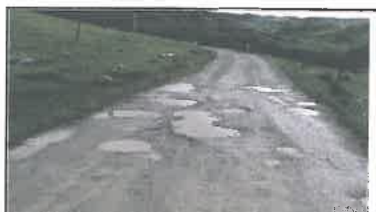
Foto N° 98: Evidencia de baches afectando la plataforma en el Km 17+200
