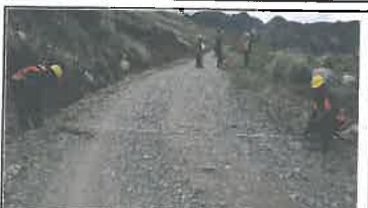
Foto N° 499: Prueba de la anchura de la superficie de rodadura en el Km 24+900.
