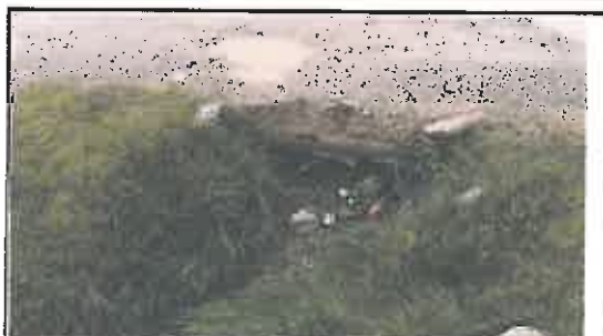
Foto N° 75: Tajea con losa de madera colapsada, ubicada en la progresiva 17+720.
