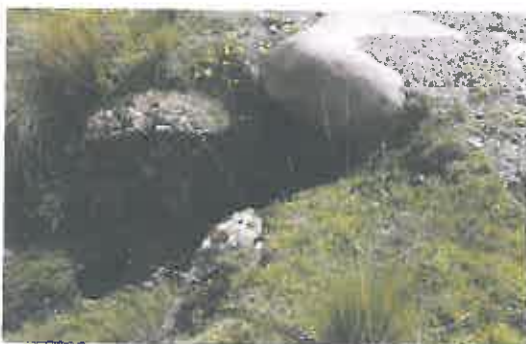
Alcantarilla de mampostería y losa de troncos de madera en mal estado, ubicada en la progresiva 18+670
