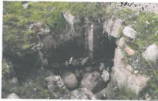
Alcantarilla de mampostería y losa de troncos de madera en mal estado, ubica en la progresiva 12+166
