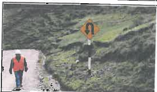
Foto N° 22: Señal preventiva de 0.8 x 0.8 m en buen estado, alerta de una curva en "U" a la izquierda, ubicada en la progresiva 01+625.
