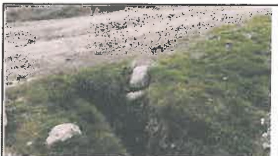
Foto N° 81: Tajea de PVC de 6" semiobstruida, ubicada en la progresiva 19+932.
