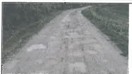
Foto N° 127: Evidencia de baches afectando la plataforma en el Km 22+415
