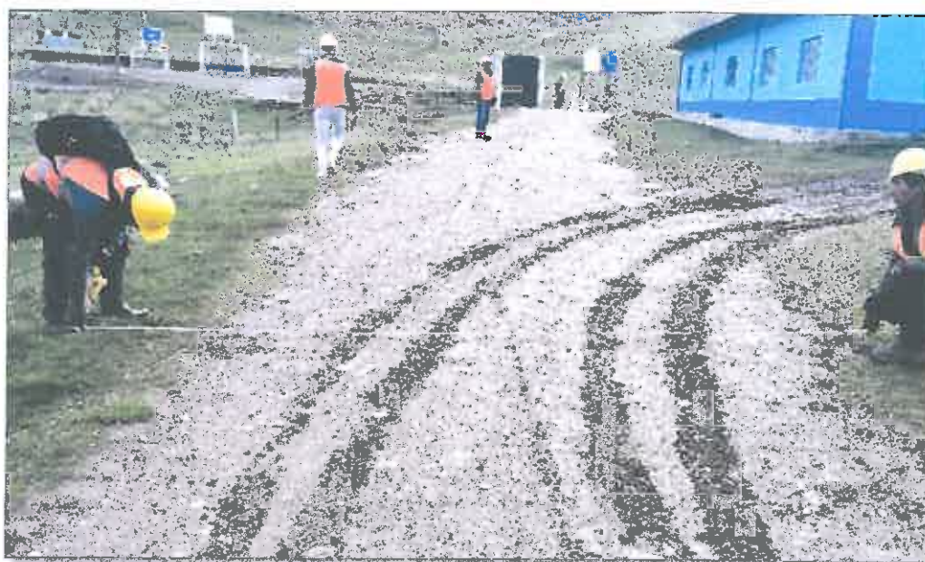
Medición del ancho de superficie de rodadura Km 29+700
