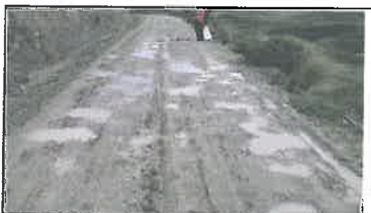
Foto N° 121: Evidencia de baches afectando la plataforma en el Km 21+530
