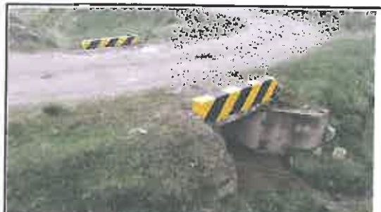
Foto N° 98: Alcantarilla tipo marco de 0.8 x 0.9 m en buen estado, ubicada en la progresiva 25+830.
