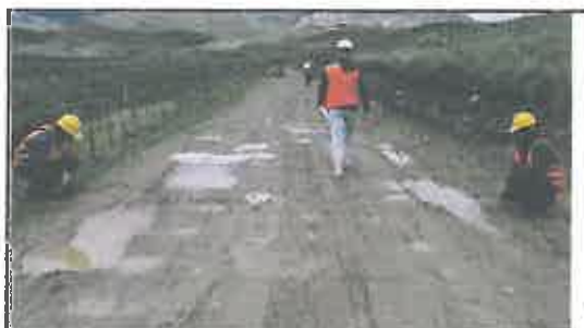
Foto N° 433: Prueba de la anchura de la superficie de rodadura en el Km 21+600.
