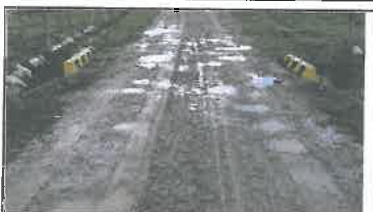
Foto N° 165: Evidencia de baches afectando la plataforma en el Km 29+075
