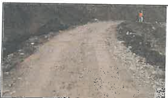
Foto N° 17: Evidencia de erosión afectando la plataforma en el Km 02+500
