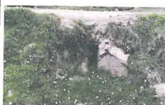
Alcantarilla de mampostería y losa de troncos de madera en mal estado, ubicada en la progresiva 16+879
