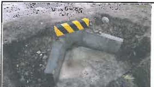
Foto N° 97: Alcantarilla de PVC de 12" en buen estado, ubicada en la progresiva 25+604.
