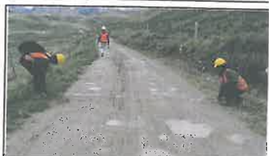
Foto N° 448: Prueba de la anchura de la superficie de rodadura en el Km 22+350.
