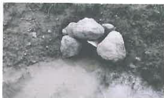
Tajea de piedra colapsada ubicada en la progresiva 20+388
