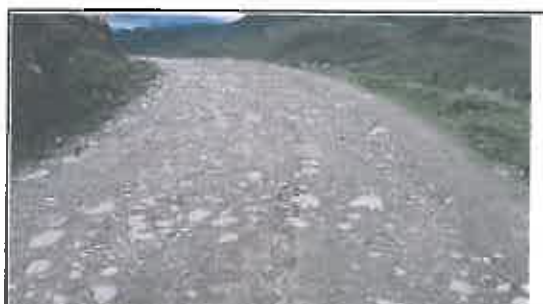
Foto N° 81: Evidencia de erosión afectando la plataforma en el Km 15+490
