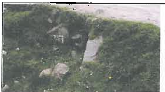
Foto N° 35: Salida de alcantarilla de mampostería tapada con rocas, ubicada en la progresiva 10+241.
