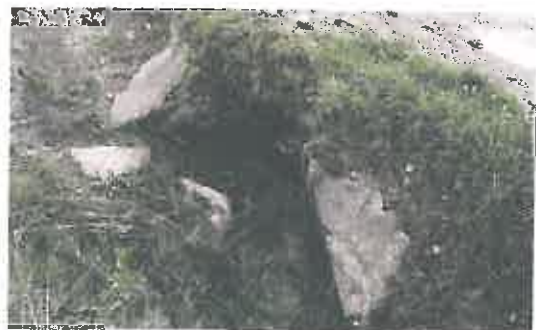
Alcantarilla de mampostería y losa de troncos de madera en mal estado, ubica en la progresiva 09+398
