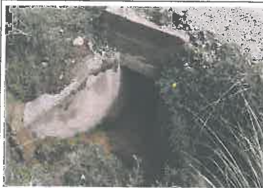
Salida de alcantarilla de concreto semi obstruida, ubicada en la progresiva 00+608
