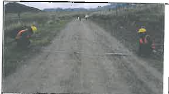
Foto N° 410: Prueba de la anchura de la superficie de rodadura en el Km 20+450.
