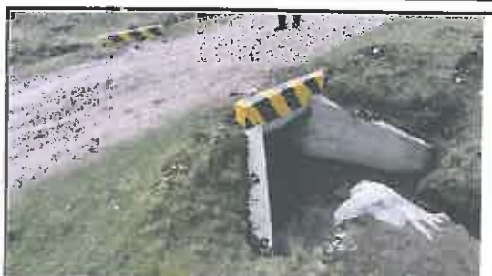
Foto N° 104: Alcantarilla tipo marco de 0.8 x 0.8 m en buen estado, ubicada en la progresiva 28+850.
