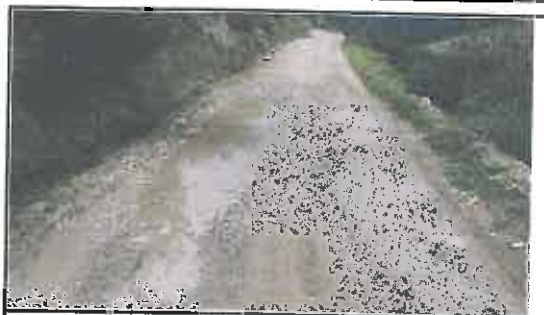
Foto N° 36: Evidencia de cruce de agua afectando la plataforma en el Km 07+400
