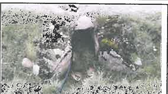
Foto N° 64: Alcantarilla de mampostería generando erosión en la plataforma, ubicada en la progresiva 16+330.
