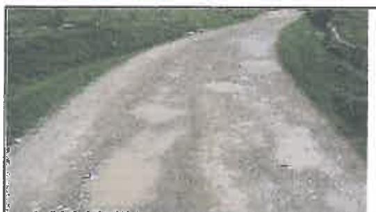
Foto N° 41: Evidencia de baches afectando la plataforma en el Km 08+060
