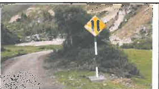
Foto N° 5: Señal preventiva de dimensiones 0.8 x 0.8 m de acceso a un pontón angosto, ubicada en la progresiva 00+347.
