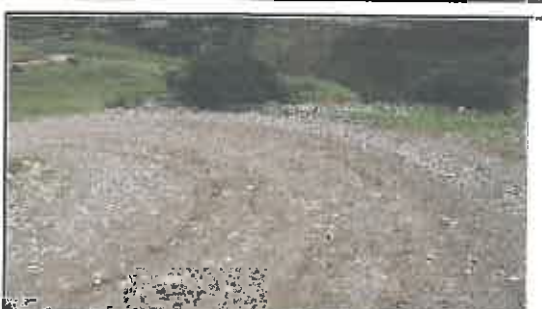
Foto N° 6: Evidencia de erosión afectando la plataforma en el Km 01+050
