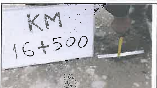
Foto N° 67: Desgaste del espesor del afirmado
