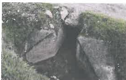
Alcantarilla de mampostería y losa de troncos de madera en mal estado, ubica en la progresiva 11+360
