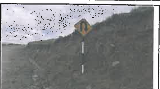
Foto N° 150: Señal preventiva de 0.8 x 0.8 m en buen estado, alerta de una curva en "U" a la derecha, ubicada en la progresiva 25+290.
