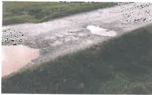
Alcantarilla de mampostería y losa de troncos de madera en mal estado, ubicada en la progresiva 17+270
