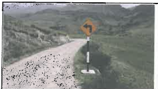
Foto N° 65: Señal preventiva de 0.8 x 0.8 m en buen estado, alerta de una curva pronunciada a la izquierda, ubicada en la progresiva 07+360.
