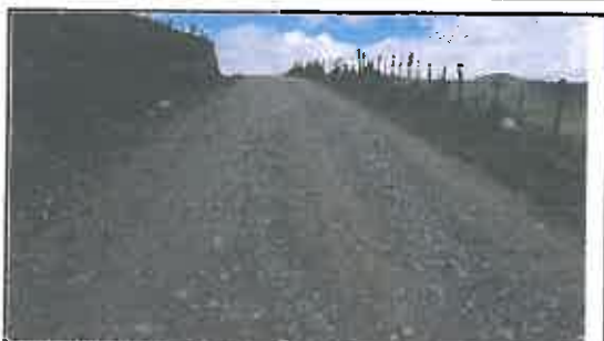
Foto N° 123: Evidencia de erosión afectando la plataforma en el Km 21+790
