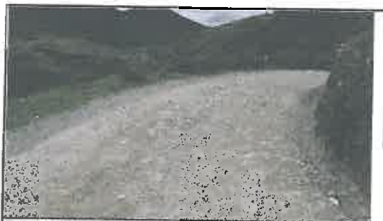
Foto N° 33: Evidencia de erosión afectando la plataforma en el Km 07+035
