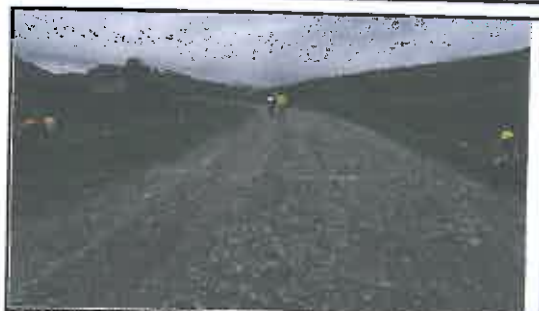
Foto N° 398: Prueba de la anchura de la superficie de rodadura en el Km 19+850.
