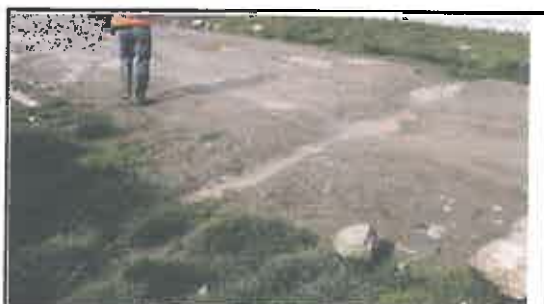
Foto N° 77: Alcantarilla de mampostería de piedra obstruida, causando desvío de aguas hacia la plataforma, ubicada en la progresiva 17+976.
