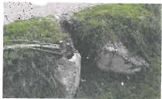
Alcantarilla de mampostería y losa de troncos de madera en mal estado, ubica en la progresiva 09+114
