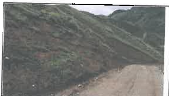
Foto N° 9: Evidencia de erosión del talud superior en el Km 01+720
