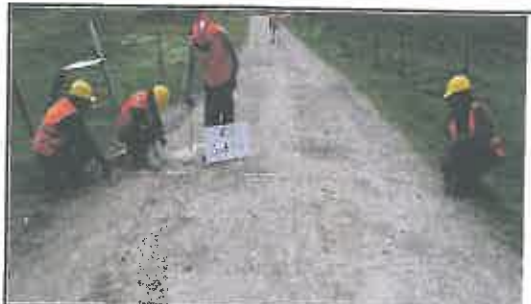
Foto N° 166: Prueba de la anchura de la superficie de rodadura en el Km 08+250.
