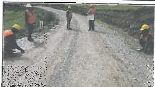
Foto N° 20: Prueba de la anchura de la superficie de rodadura en el Km 00+950.
