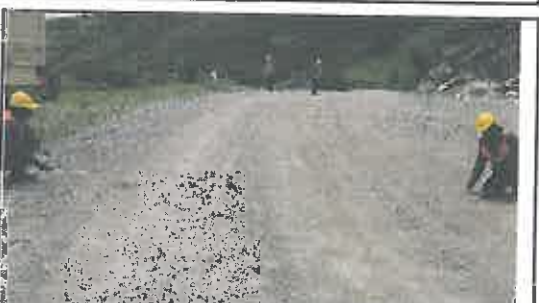
Foto N° 139: Prueba de la anchura de la superficie de rodadura en el Km 06+900.
