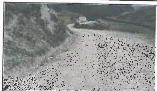
Foto N° 24: Evidencia de erosión del talud superior en el Km 04+900
