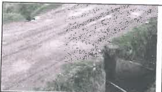
Foto N° 49: Alcantarilla de 0.6 x 0.9 m en regular estado, ubicada en la progresiva 14+015.
