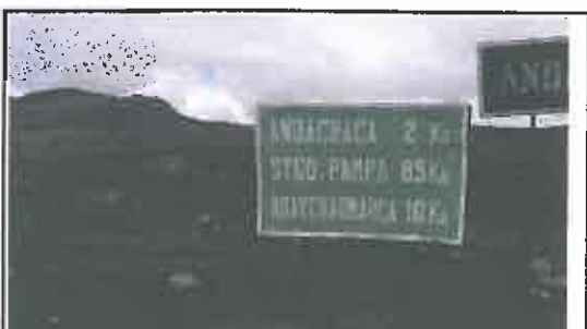
Foto N° 96: Señal informativa de 1.8 x 1.2 m en mal estado, indica la distancia a los pueblos de Andachaca, Santiago Pampa y Huaychaamarca, ubicada en la progresiva 19+900.
