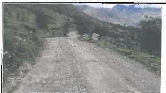
Foto N° 31: Evidencia de erosión afectando la plataforma en el Km 06+200
