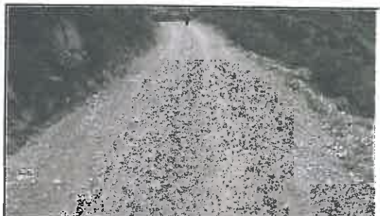
Foto N° 28: Evidencia de erosión afectando la plataforma en el Km 05+800
