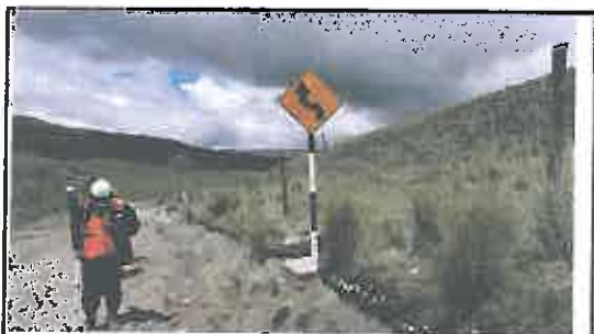
Foto N° 137: Señal preventiva de 0.8 x 0.8 m en buen estado, alerta de una curva en "S", ubicada en la progresiva 24+545.
