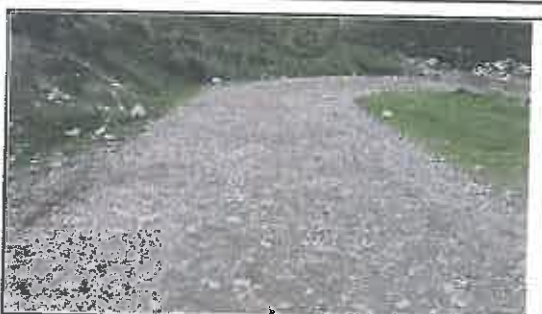
Foto N° 69: Evidencia de erosión afectando la plataforma en el Km 13+750
