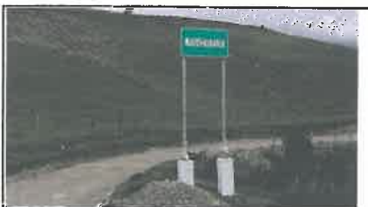
Foto N° 48: Señal informativa de 1.2 x 0.7 m en buen estado, indica la ubicación del pueblo Huaychaamarca, ubicada en la progresiva 04+557.
