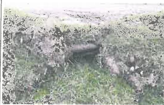
Alcantarilla de mampostería y losa de troncos de madera en mal estado, ubicada en la progresiva 16+095
