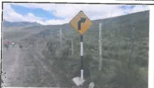
Foto N° 115: Señal preventiva de 0.8 x 0.8 m en buen estado, alerta de una curva a la derecha, ubicada en la progresiva 22+030.
