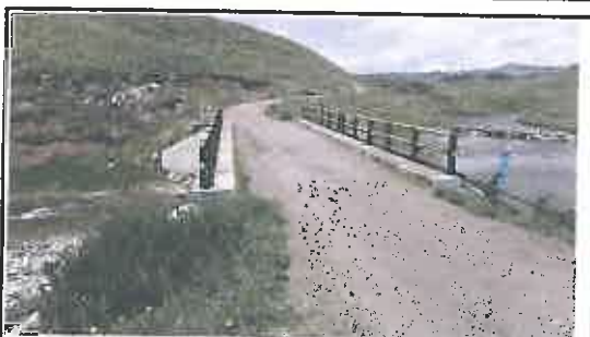
Foto N° 93: Puente de A = 3.8 m y L = 17 m, ubicado en la progresiva 23+570.
