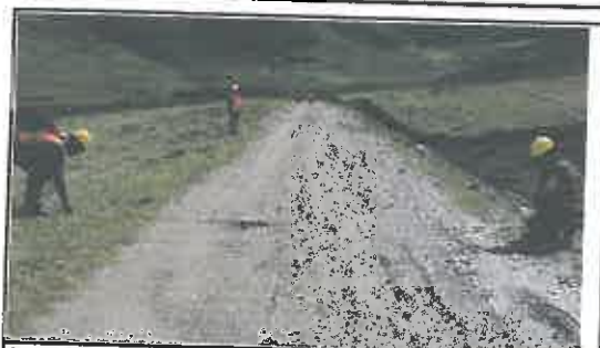
Foto N° 575: Prueba de la anchura de la superficie de rodadura en el Km 28+700.
