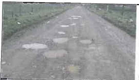
Foto N° 113: Evidencia de baches afectando la plataforma en el Km 19+400
