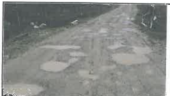
Foto N° 122: Evidencia de baches afectando la plataforma en el Km 21+680
