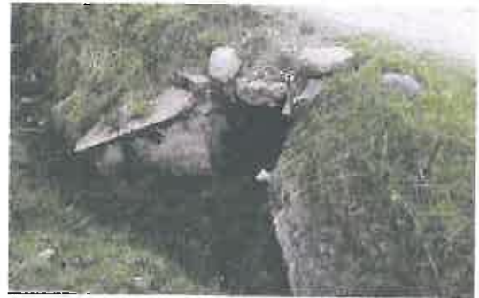
Alcantarilla de mampostería y losa de troncos de madera en mal estado, ubica en la progresiva 09+960
