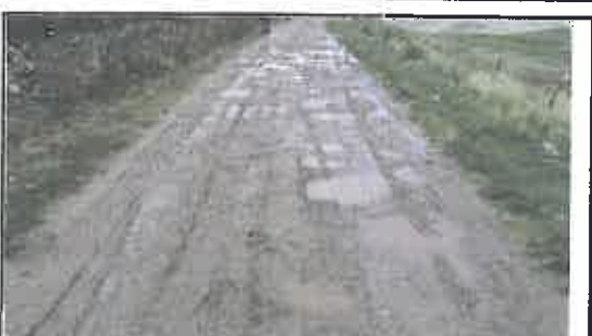
Foto N° 150: Evidencia de baches afectando la plataforma en el Km 26+740
