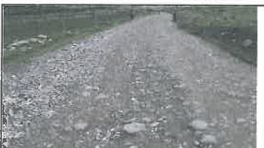
Foto N° 75: Evidencia de erosión afectando la plataforma en el Km 14+450
