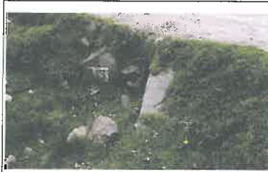
Salida de alcantarilla de concreto semi obstruida, ubicada en la progresiva 10+241
