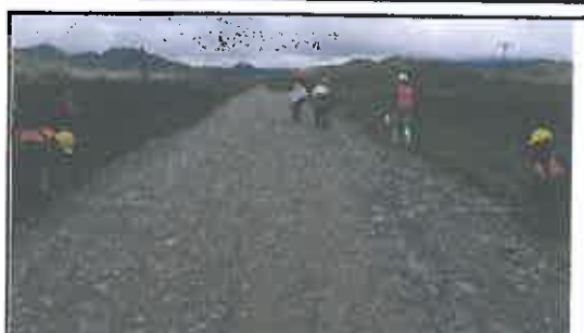
Foto N° 380: Prueba de la anchura de la superficie de rodadura en el Km 18+950.
