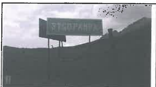
Foto N° 61: Señal informativa de 1.8 x 0.6 m en mal estado, indica el pueblo de Santiago Pampa, ubicada en la progresiva 07+918.
