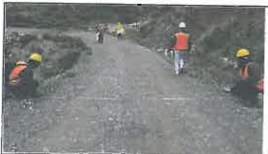
Foto N° 413: Prueba de la anchura de la superficie de rodadura en el Km 20+600.
