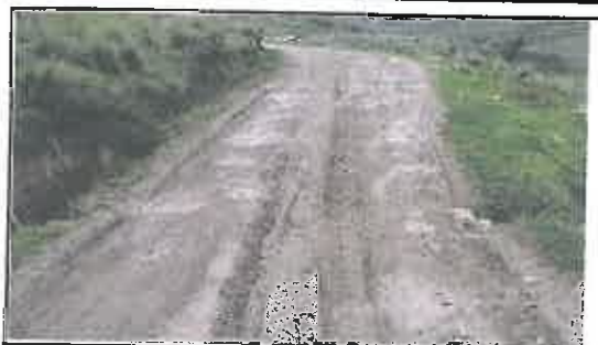
Foto N° 71: Evidencia de baches afectando la plataforma en el Km 14+015
