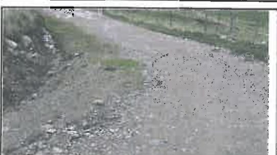
Foto N° 142: Evidencia de erosión afectando la plataforma en el Km 24+880
