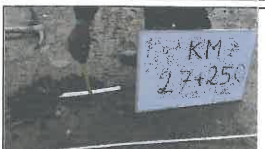
Foto N° 110: Desgaste del espesor del afirmado
