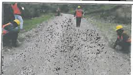
Foto N° 119: Prueba de la anchura de la superficie de rodadura en el Km 05+900.
