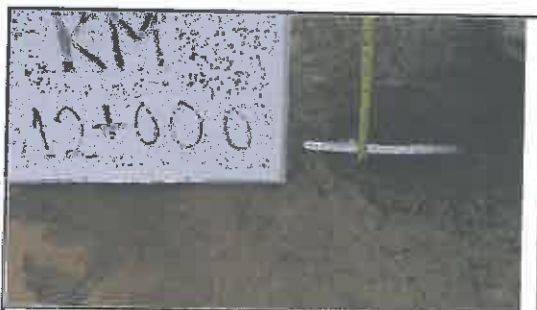
Foto N° 49: Desgaste del espesor del afirmado
