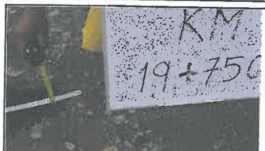
Foto N° 80: Desgaste del espesor del afirmado
