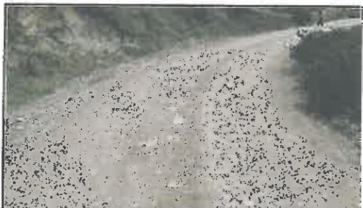
Foto N° 25: Evidencia de erosión afectando la plataforma en el Km 05+020
