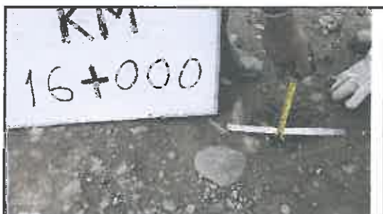
Foto N° 65: Desgaste del espesor del afirmado
