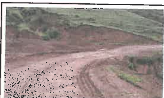
Foto N° 3: Se aprecia un talud inestable ubicado entre las progresivas Km 02+340 - Km 02+460.
