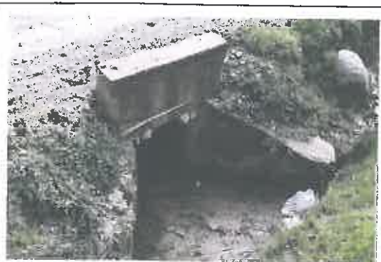
Salida de alcantarilla de concreto semi obstruida, ubicada en la progresiva 00+790
