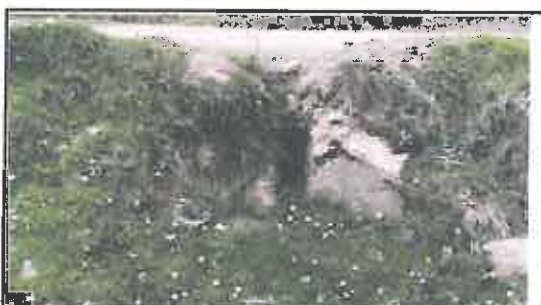
Foto N° 67: Alcantarilla de mampostería en mal estado, ubicada en la progresiva 16+879.
