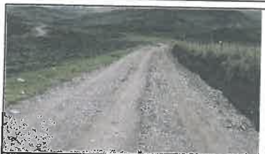
Foto N° 119: Evidencia de erosión afectando la plataforma en el Km 20+820
