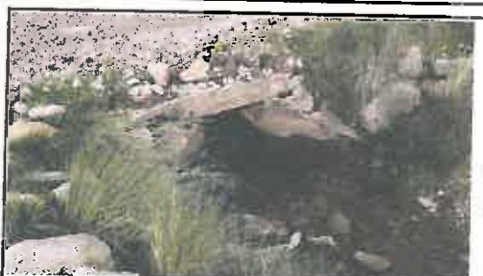
Foto N° 51: Alcantarilla de mampostería semiobstruida, ubicada en la progresiva 14+557.
