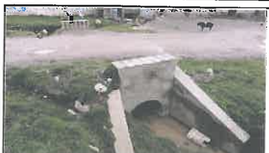
Foto N° 78: Alcantarilla de TMC 36" en buen estado, ubicada en la progresiva 18+190.
