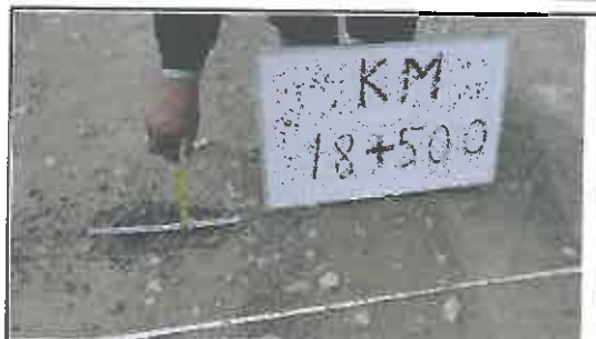
Foto N° 75: Desgaste del espesor del afirmado
