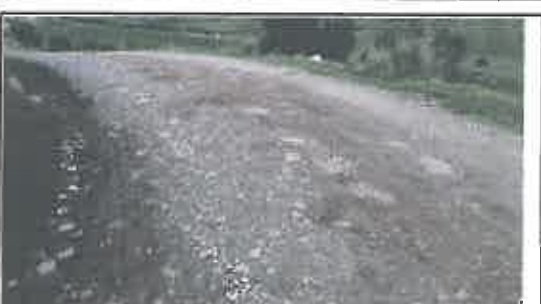
Foto N° 77: Evidencia de erosión afectando la plataforma en el Km 15+100
