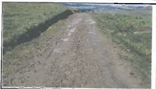
Foto N° 155: Evidencia de baches afectando la plataforma en el Km 27+355
