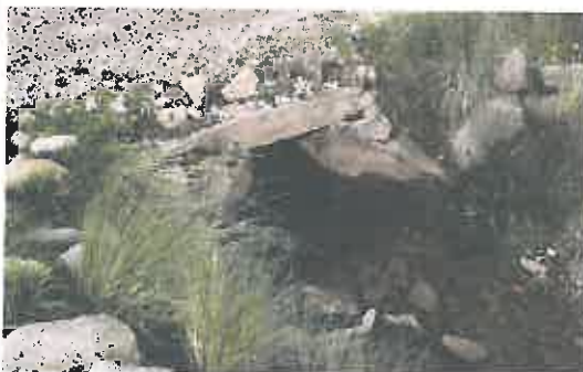
Alcantarilla de mampostería y losa de troncos de madera en mal estado, ubica en la progresiva 14+557
