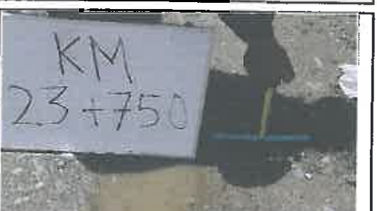
Foto N° 96: Desgaste del espesor del afirmado
