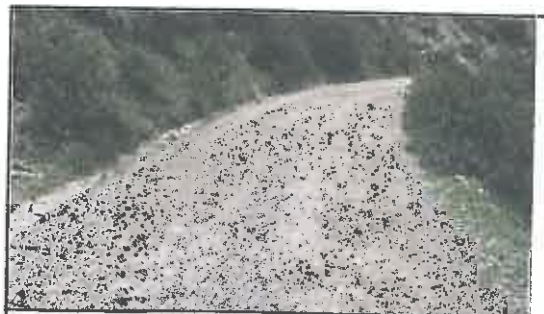
Foto N° 34: Evidencia de erosión afectando la plataforma en el Km 07+090
