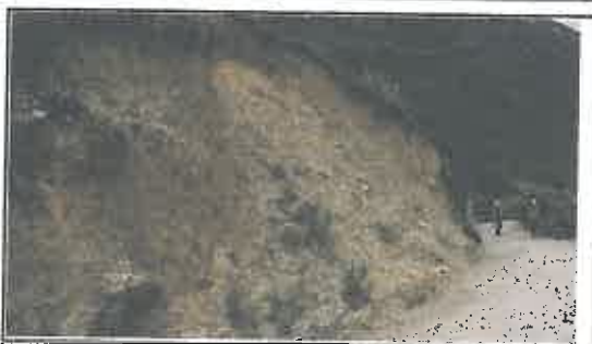
Foto N° 39: Evidencia de erosión del talud superior en el Km 07+610
