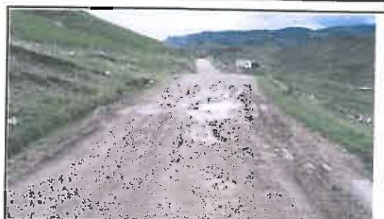
Foto N° 94: Evidencia de baches afectando la plataforma en el Km 16+740
