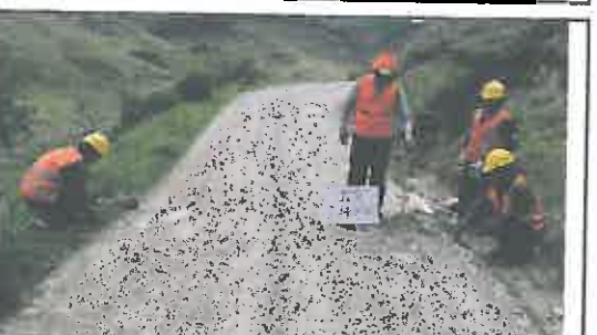
Foto N° 141: Prueba de la anchura de la superficie de rodadura en el Km 07+000.
