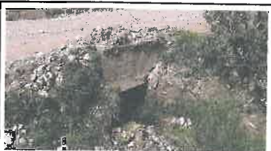
Foto N° 4: Cabezal de entrada de alcantarilla de concreto tipo marco, ubicada en la progresiva 00+790.
