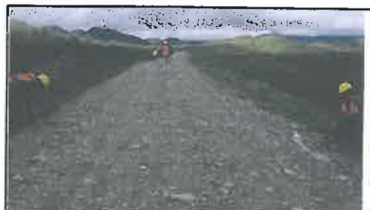
Foto N° 378: Prueba de la anchura de la superficie de rodadura en el Km 18+850.
