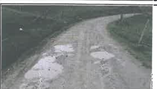
Foto N° 48: Evidencia de baches afectando la plataforma en el Km 09+790
