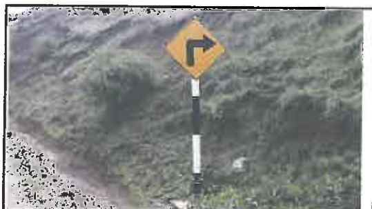
Foto N° 33: Señal preventiva de 0.8 x 0.8 m en buen estado, alerta de una curva pronunciada a la derecha, ubicada en la progresiva 02+780.
