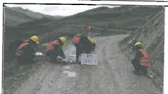
Foto N° 176: Prueba de la anchura de la superficie de rodadura en el Km 08+750.
