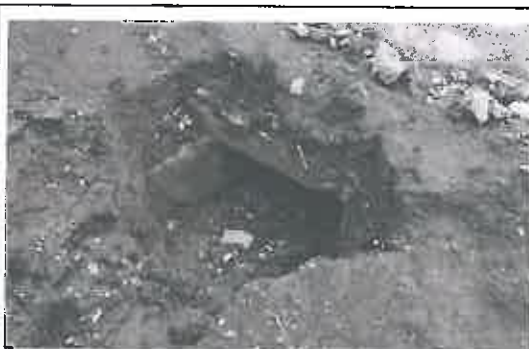
Salida de alcantarilla de concreto semi obstruida, ubicada en la progresiva 02+538
