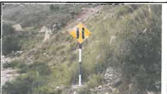
Foto N° 3: Señal preventiva de 0.8 x 0.8 m en buen estado, de acceso a un pontón angosto, ubicada en la progresiva 00+265.
