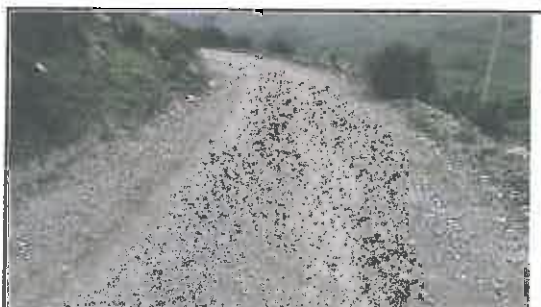
Foto N° 29: Evidencia de erosión afectando la plataforma en el Km 05+950
