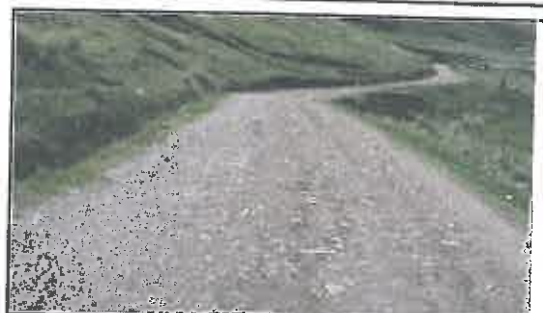
Foto N° 72: Evidencia de erosión afectando la plataforma en el Km 14+050
