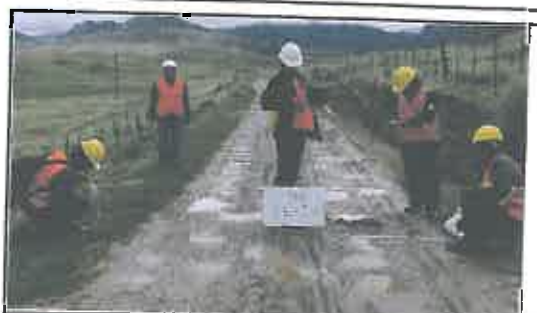
Foto N° 536: Prueba de la anchura de la superficie de rodadura en el Km 26+750.
