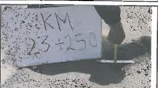
Foto N° 94: Desgaste del espesor del afirmado
