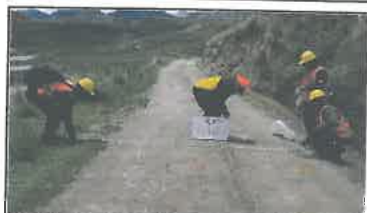
Foto N° 446: Prueba de la anchura de la superficie de rodadura en el Km 22+250.
