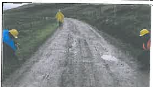
Foto N° 222: Prueba de la anchura de la superficie de rodadura en el Km 11+050.
