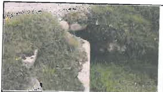
Foto N° 50: Salida de alcantarilla con entrada obstruida, ubicada en la progresiva 14+398.
