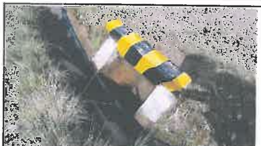
Foto N° 100: Cabezal de entrada con caja de alcantarilla tipo marco de 0.8 x 0.9 m en buen estado, ubicada en la progresiva 27+360.
