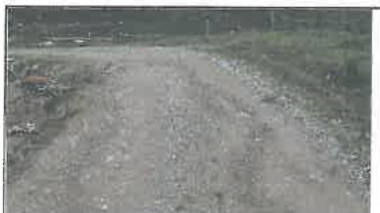
Foto N° 137: Evidencia de erosión afectando la plataforma en el Km 23+875
