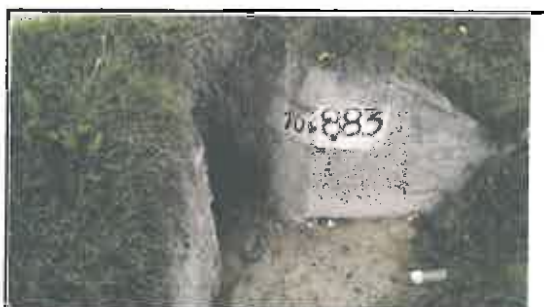
Foto N° 37: Salida de alcantarilla de mampostería obstruida, ubicada en la progresiva 10+810.
