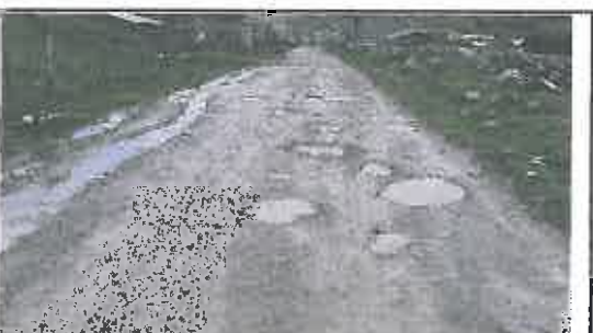
Foto N° 109: Evidencia de erosión con presencia de baches afectando la plataforma en el Km 18+300
