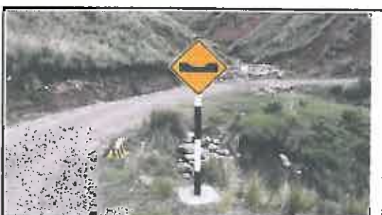
Foto N° 102: Señal preventiva de 0.8 x 0.8 m en buen estado, alerta la proximidad de un badén, ubicada en la progresiva 20+649.
