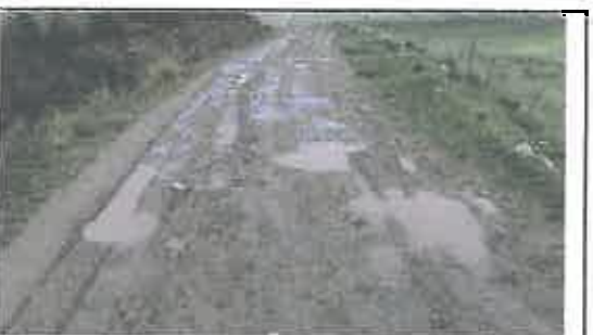
Foto N° 151: Evidencia de baches afectando la plataforma en el Km 26+880
