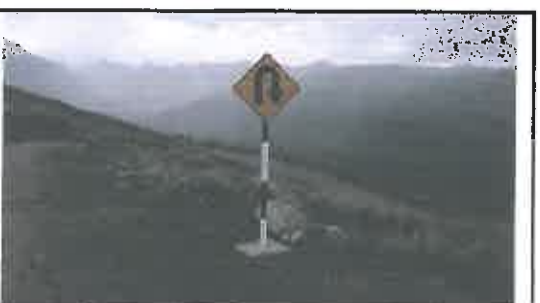
Foto N° 149: Señal preventiva de 0.8 x 0.8 m en buen estado, alerta de una curva en "U" a la derecha, ubicada en la progresiva 25+120.
