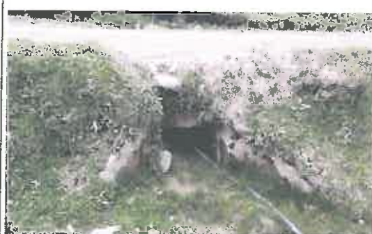
Alcantarilla de mampostería y losa de troncos de madera en mal estado, ubicada en la progresiva 16+675
