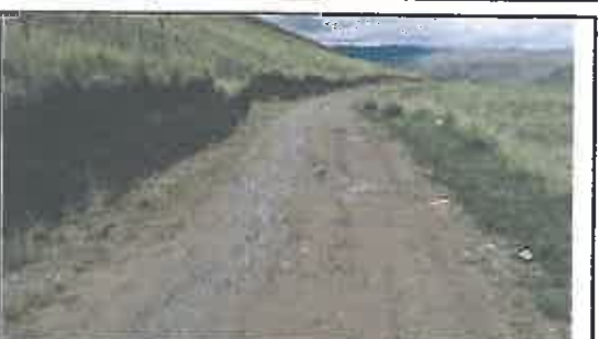
Foto N° 152: Evidencia de erosión afectando la plataforma en el Km 26+950
