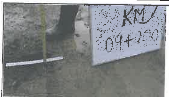
Foto N° 37: Desgaste del espesor del afirmado
