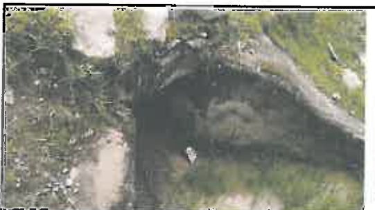
Foto N° 13: Alcantarilla de mampostería de 0.6 x 0.8 m. y losa de madera, ubicada en la progresiva 03+316.
