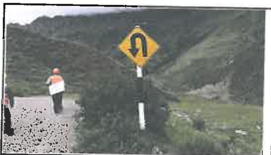
Foto N° 17: Señal preventiva de 0.8 x 0.8 m en buen estado, alerta de una curva en "U" a la izquierda, ubicada en la progresiva 01+273.
