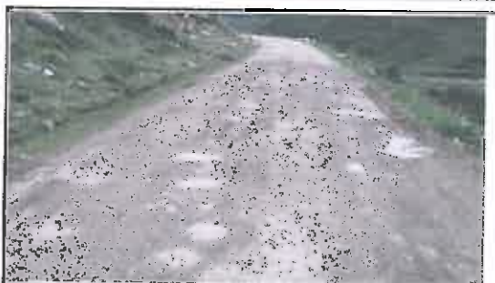
Foto N° 95: Evidencia de baches afectando la plataforma en el Km 16+875
