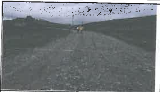
Foto N° 115: Evidencia de erosión afectando la plataforma en el Km 19+850
