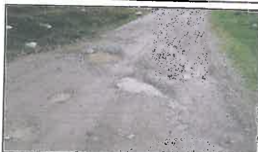
Foto N° 68: Evidencia de cruce de agua afectando la plataforma en el Km 13+675
