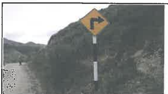
Foto N° 46: Señal preventiva de 0.8 x 0.8 m en buen estado, alerta de una curva pronunciada a la derecha, ubicada en la progresiva 04+372.
