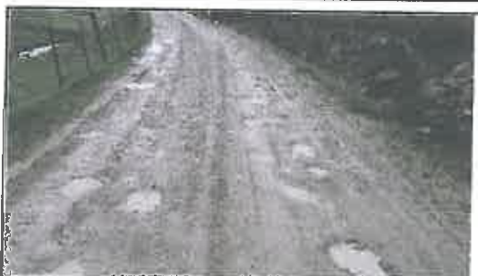
Foto N° 51: Evidencia de baches afectando la plataforma en el Km 10+710
