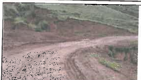
Foto N° 15: Evidencia de cruce de agua afectando la plataforma en el Km 02+340
