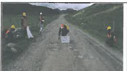
Foto N° 371: Prueba de la anchura de la superficie de rodadura en el Km 18+500.
