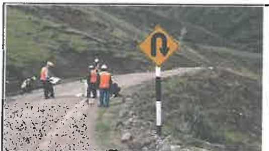
Foto N° 25: Señal preventiva de 0.8 x 0.8 m en buen estado, alerta de una curva en "U" a la derecha, ubicada en la progresiva 01+754.
