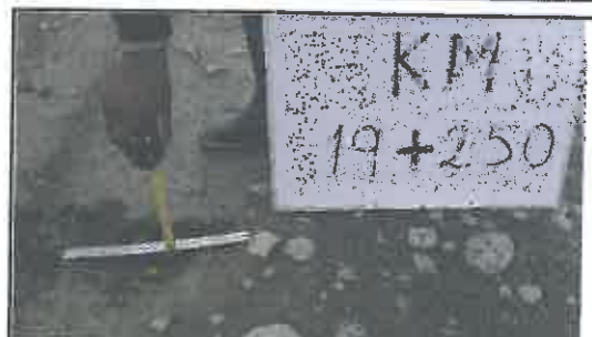
Foto N° 78: Desgaste del espesor del afirmado
