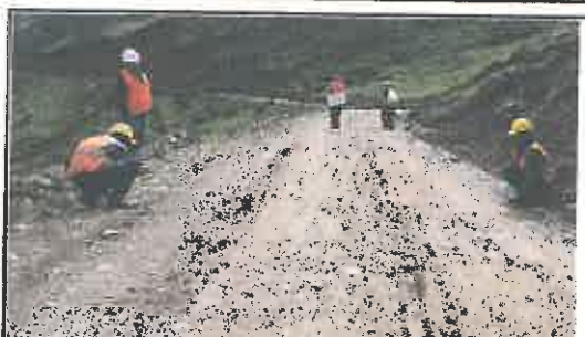
Foto N° 35: Prueba de la anchura de la superficie de rodadura en el Km 01+700.
