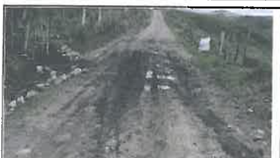
Foto N° 125: Evidencia de ahuellamiento afectando la plataforma en el Km 22+020
