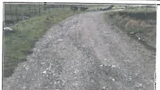
Foto N° 168: Evidencia de erosión afectando la plataforma en el Km 29+560
