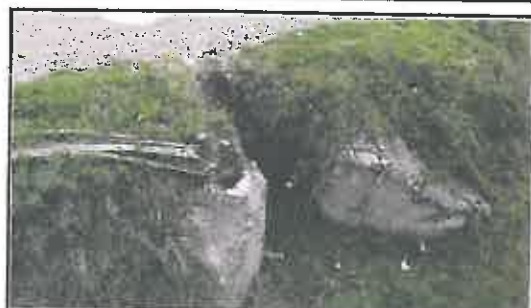
Foto N° 28: Entrada de alcantarilla de mampostería, presenta erosión en la plataforma, ubicada en la progresiva 09+114.
