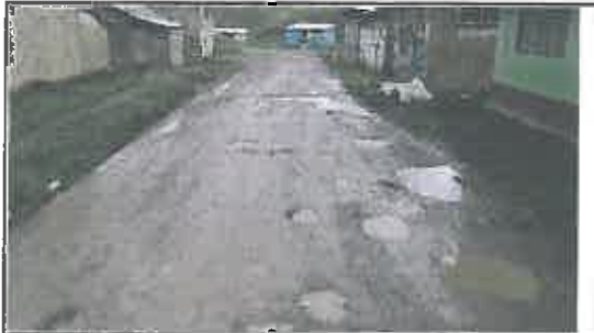
Foto N° 105: Evidencia de baches afectando la plataforma en el Km 17+950
