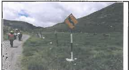
Foto N° 128: Señal preventiva de 0.8 x 0.8 m en buen estado, alerta de una curva en "S", ubicada en la progresiva 23+835.
