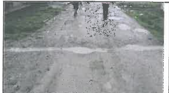
Foto N° 106: Evidencia de cruce de agua afectando la plataforma en el Km 17+970
