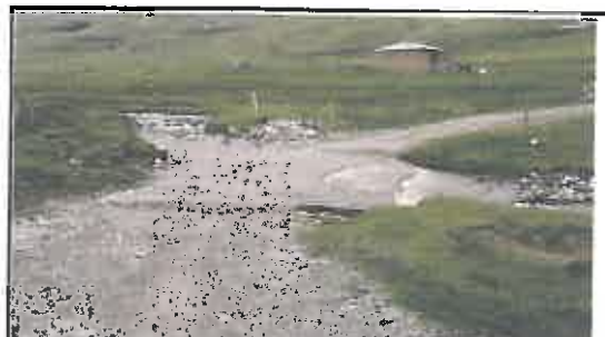
Foto N° 74: Badén de concreto con A = 5.7 \text{ m} L = 15 \text{ m} , ubicado en la progresiva 17+590.
