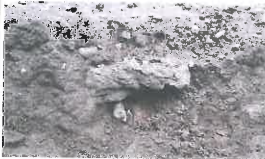
Tajea de piedra obstruida en regular estado, ubicada en la progresiva 15+978
