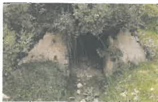
Alcantarilla de mampostería y losa de troncos de madera en mal estado, ubica en la progresiva 06+985
