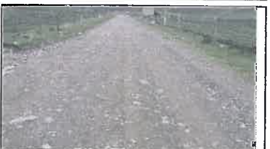
Foto N° 112: Evidencia de erosión afectando la plataforma en el Km 19+200
