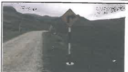
Foto N° 64: Señal preventiva de 0.8 x 0.8 m en buen estado, alerta de una curva pronunciada a la derecha, ubicada en la progresiva 07+274.
