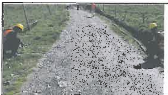
Foto N° 553: Prueba de la anchura de la superficie de rodadura en el Km 27+600.
