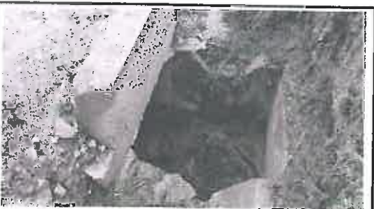
Foto N° 6: Cabezal de salida de alcantarilla tipo marco, ubicada en la progresiva 02+370.
