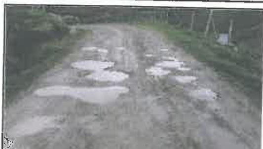
Foto N° 52: Evidencia de baches afectando la plataforma en el Km 11+045
