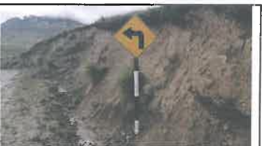
Foto N° 165: Señal preventiva de 0.8 x 0.8 m en buen estado, alerta de una curva pronunciada a la izquierda, ubicada en la progresiva 27+085.
