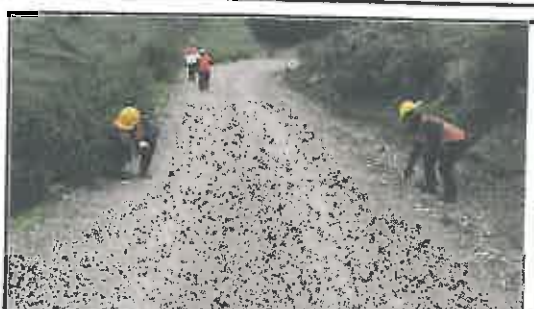
Foto N° 94: Prueba de la anchura de la superficie de rodadura en el Km 04+650.
