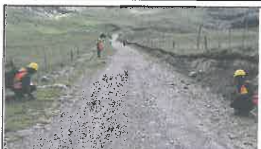
Foto N° 579: Prueba de la anchura de la superficie de rodadura en el Km 28+900.
