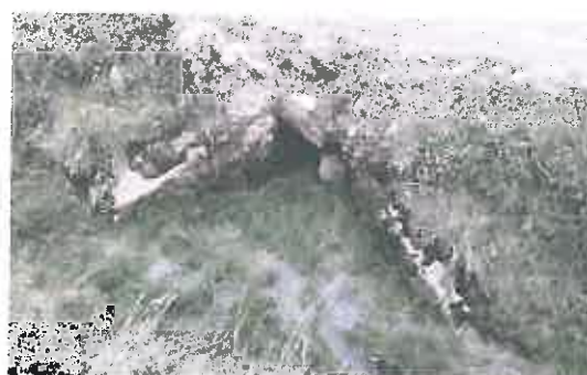
Alcantarilla de mampostería y losa de troncos de madera en mal estado, ubicada en la progresiva 16+263
