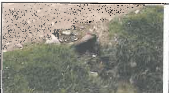
Foto N° 15: Salida de alcantarilla de mampostería con obstrucción, ubicada en la progresiva 04+550.
