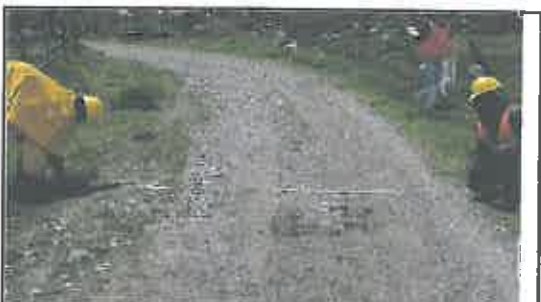
Foto N° 478: Prueba de la anchura de la superficie de rodadura en el Km 23+850.
