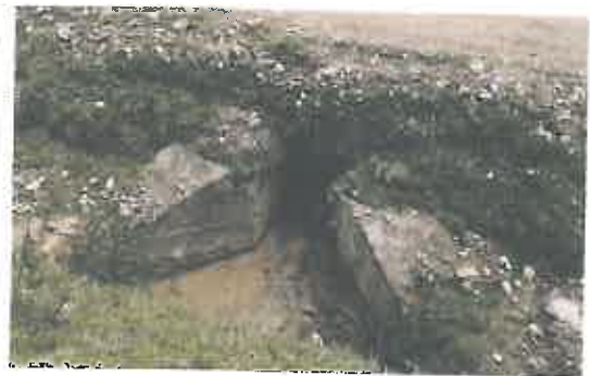
Alcantarilla de mampostería y losa de troncos de madera en mal estado, ubica en la progresiva 04+846
