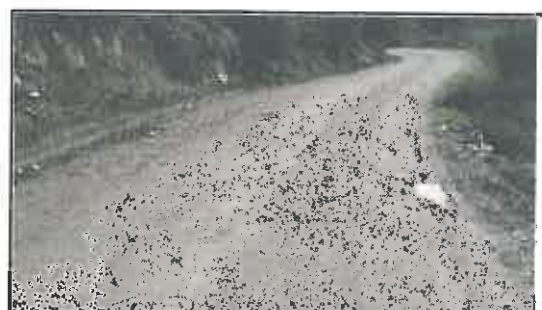
Foto N° 2: Evidencia de cruce de agua afectando la plataforma en el Km 00+100
