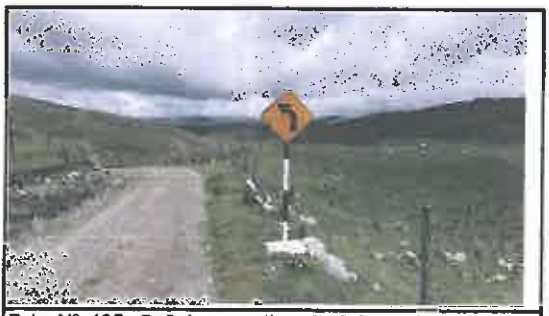
Foto N° 135: Señal preventiva de 0.8 x 0.8 m en buen estado, alerta de una curva a la izquierda, ubicada en la progresiva 24+230.
