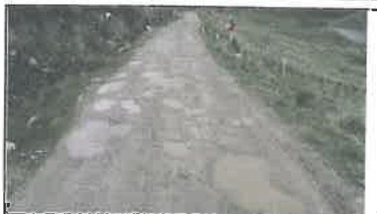
Foto N° 128: Evidencia de baches afectando la plataforma en el Km 22+550
