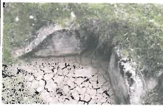
Alcantarilla de mampostería y losa de troncos de madera en mal estado, ubica en la progresiva 08+075
