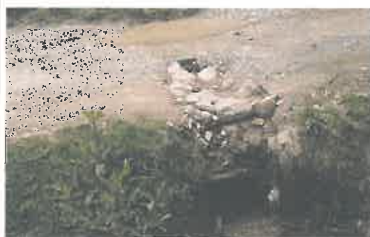
Alcantarilla de mampostería y losa de troncos de madera en mal estado, ubica en la progresiva 07+405
