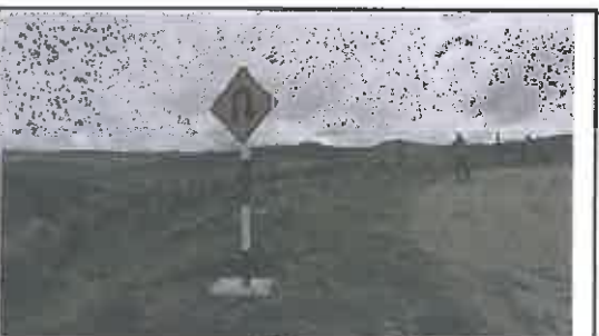
Foto N° 103: Señal preventiva de 0.8 x 0.8 m en buen estado, alerta de una curva en "U" a la derecha, ubicada en la progresiva 20+708.
