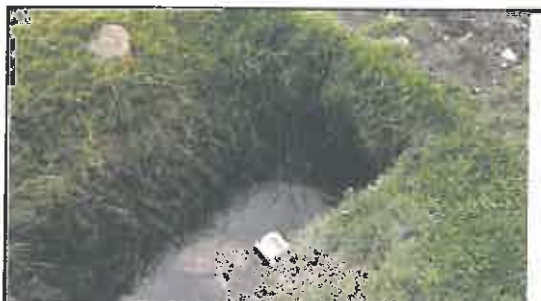
Foto N° 73: Cruce de agua con tajea utilizada como toma de agua para riego, ubicada en la progresiva 17+527.
