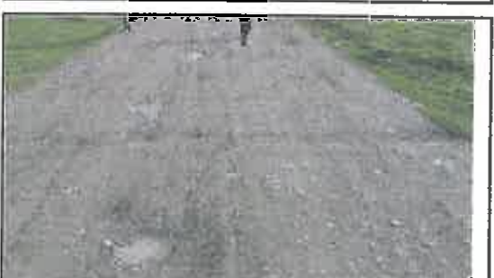
Foto N° 62: Evidencia de cruce de agua afectando la plataforma en el Km 12+820
