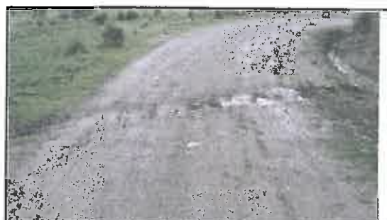
Foto N° 146: Evidencia de cruce de agua afectando la plataforma en el Km 25+615
