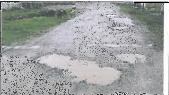
Foto N° 107: Evidencia de cruce de agua afectando la plataforma en el Km 18+205
