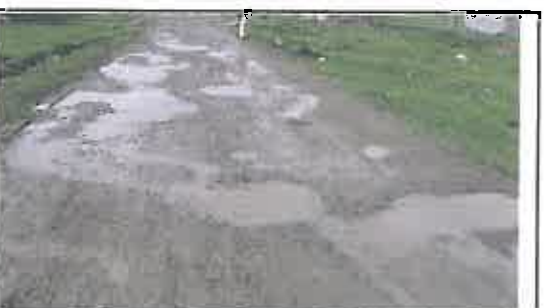
Foto N° 63: Evidencia de baches afectando la plataforma en el Km 12+860
