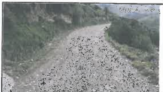
Foto N° 30: Evidencia de erosión afectando la plataforma en el Km 06+080
