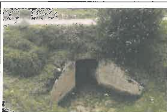
Alcantarilla de mampostería y losa de troncos de madera en mal estado, ubica en la progresiva 07+719
