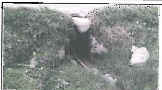
Foto N° 68: Salida de alcantarilla en regular estado, ubicada en la progresiva 16+970.
