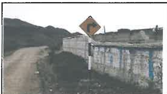
Foto N° 41: Señal preventiva de 0.8 x 0.8 m en buen estado, alerta de una curva pronunciada a la derecha, ubicada en la progresiva 04+470.
