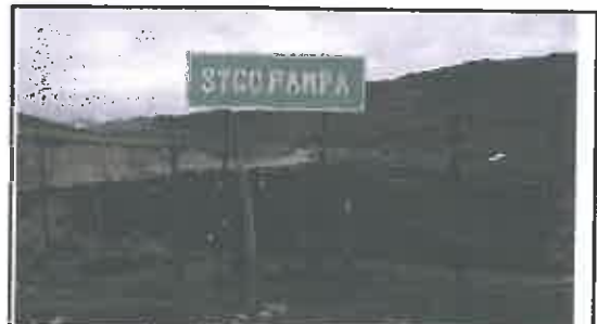
Foto N° 82: Señal informativa de 1.8 x 0.6 m en mal estado, indica el pueblo de Santiago Pampa, ubicada en la progresiva 13+777.
