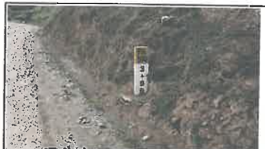
Foto N° 34: Poste kilométrico en regular estado, ubicado en la progresiva 02+900.
