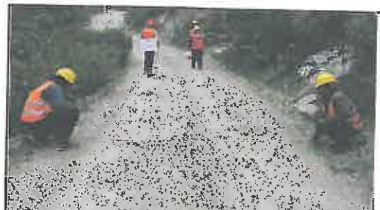
Foto N° 114: Prueba de la anchura de la superficie de rodadura en el Km 05+650.
