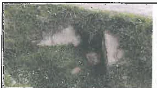
Foto N° 39: Entrada de alcantarilla de mampostería semiobstruida, ubicada en la progresiva 11+040.
