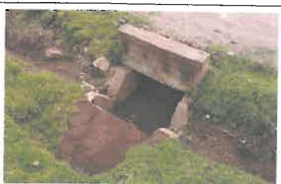
Salida de alcantarilla de concreto semi obstruida, ubicada en la progresiva 02+450
