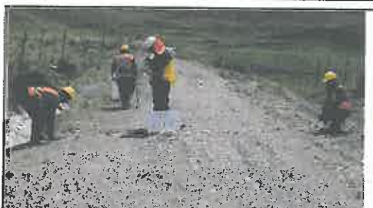
Foto N° 491: Prueba de la anchura de la superficie de rodadura en el Km 24+500.
