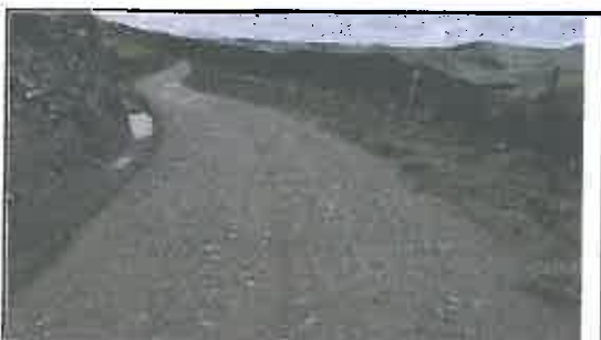
Foto N° 131: Evidencia de erosión afectando la plataforma en el Km 23+040
