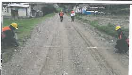
Foto N° 79: Prueba de la anchura de la superficie de rodadura 03+900.
