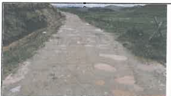
Foto N° 135: Evidencia de baches afectando la plataforma en el Km 23+520
