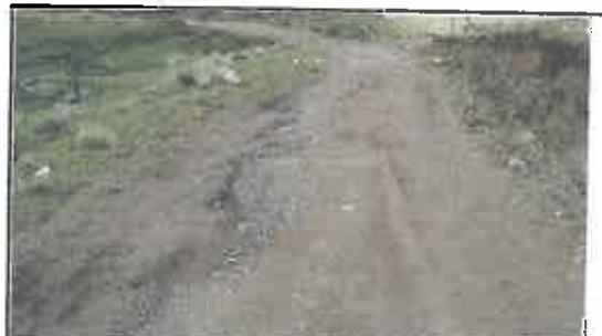
Foto N° 158: Evidencia de erosión afectando la plataforma en el Km 27+810
