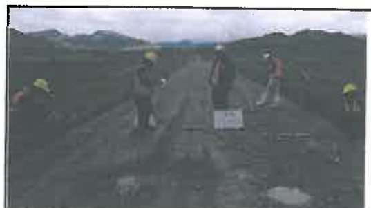
Foto N° 386: Prueba de la anchura de la superficie de rodadura en el Km 19+250.
