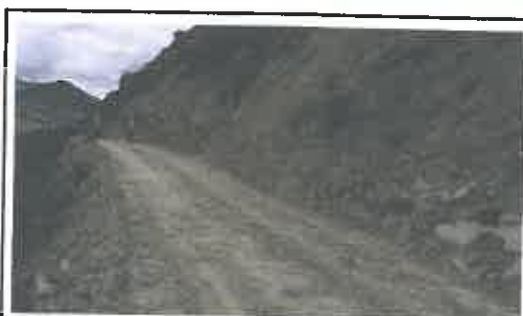
Foto N° 4: Se aprecia un talud inestable ubicado entre las progresivas Km 05+300 - Km 05+430.
