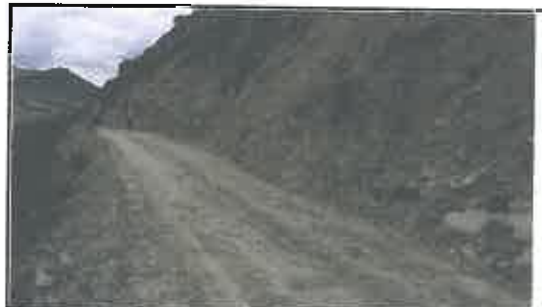
Foto N° 26: Evidencia de erosión del talud superior en el Km 05+300
