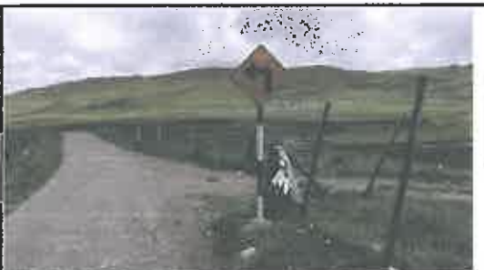
Foto N° 127: Señal preventiva de 0.8 x 0.8 m en buen estado, alerta de una curva pronunciada a la izquierda, ubicada en la progresiva 23+715.
