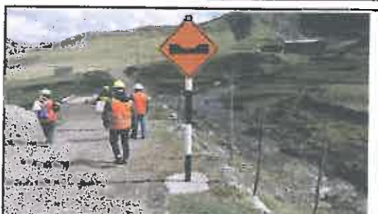
Foto N° 179: Señal preventiva de 0.8 x 0.8 m en buen estado, alerta la proximidad de un badén, ubicada en la progresiva 29+540.
