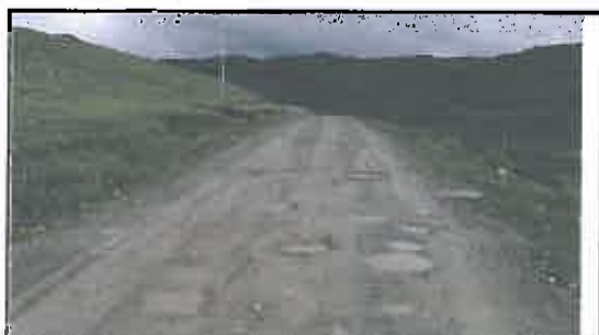
Foto N° 97: Evidencia de baches afectando la plataforma en el Km 17+050
