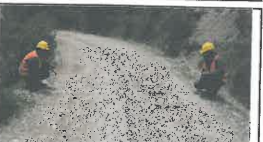
Foto N° 142: Prueba de la anchura de la superficie de rodadura en el Km 07+050.
