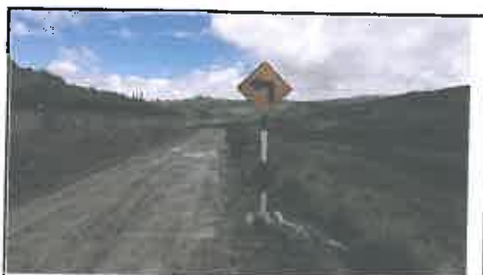
Foto N° 113: Señal preventiva de 0.8 x 0.8 m en buen estado, alerta de una curva pronunciada a la izquierda, ubicada en la progresiva 21+520.
