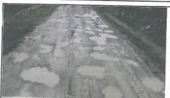
Foto N° 117: Evidencia de baches afectando la plataforma en el Km 20+400
