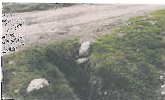
Tajea de Tubería PVC de 6" semi obstruida en regular estado, ubicada en la progresiva 19+932.
