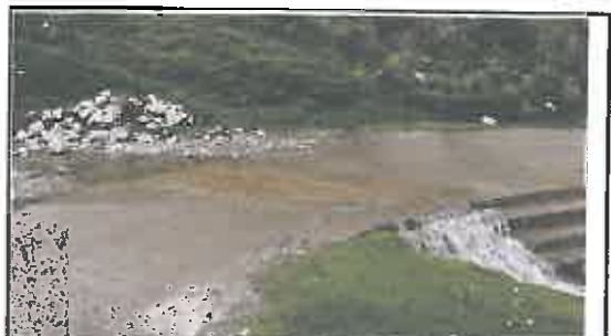
Foto N° 48: Badén de A = 4.4, L = 15 m; con dissipador de caída, ubicado en la progresiva 13+680.
