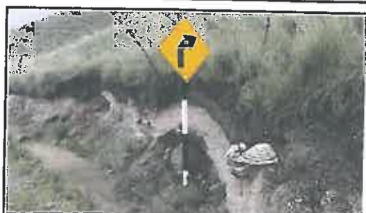
Foto N° 118: Señal preventiva de 0.8 x 0.8 m en buen estado, alerta de una curva a la derecha, ubicada en la progresiva 22+970.
