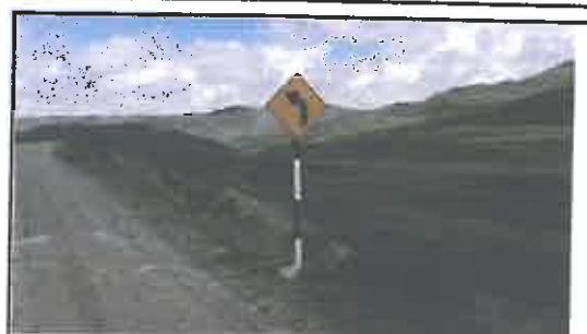
Foto N° 120: Señal preventiva de 0.8 x 0.8 m en buen estado, alerta de una curva a la izquierda, ubicada en la progresiva 23+065.
