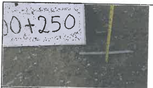
Foto N° 2: Desgaste del espesor del afirmado
