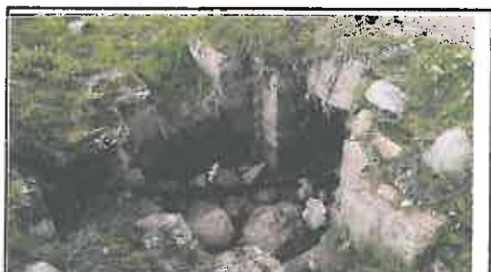
Foto N° 45: Entrada de alcantarilla tipo caja con rocas obstruyendo, ubicada en la progresiva 12+166.
