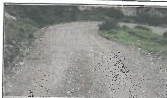
Foto N° 22: Evidencia de erosión afectando la plataforma en el Km 04+310
