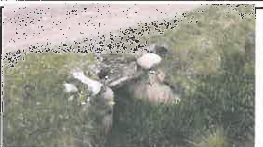
Foto N° 59: Alcantarilla de mampostería y losa de madera, ubicada en la progresiva 15+630.
