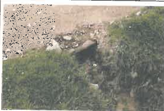
Alcantarilla de mampostería y losa de troncos de madera en mal estado, ubica en la progresiva 04+550
