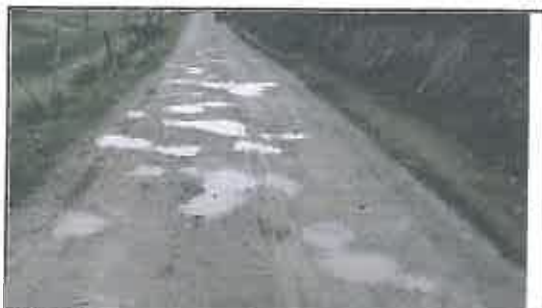
Foto N° 129: Evidencia de baches afectando la plataforma en el Km 22+770
