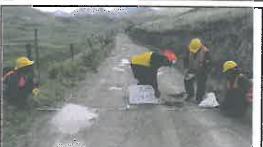
Foto N° 456: Prueba de la anchura de la superficie de rodadura en el Km 22+750.
