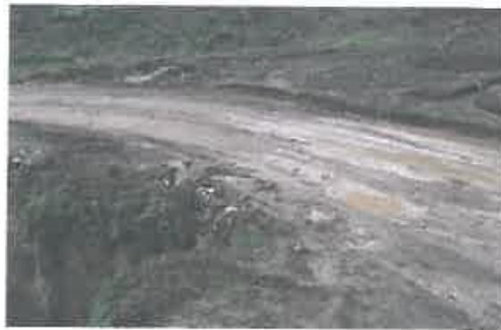
Baden enterrado debido a la erosión generado por el cruce de agua ubicado en la progresiva 02+342
