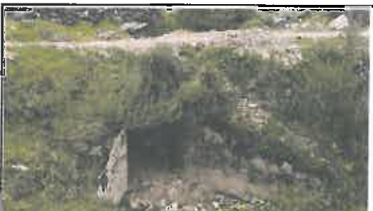
Foto N° 19: Salida de alcantarilla de mampostería de 0.6 x 0.8 m, ubicada en la progresiva 06+621.
