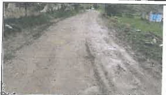
Foto N° 19: Evidencia de cruce de agua afectando la plataforma en el Km 03+700
