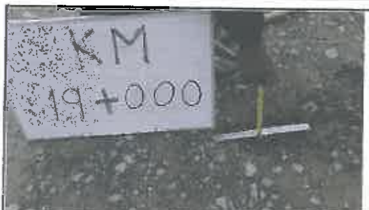
Foto N° 77: Desgaste del espesor del afirmado
