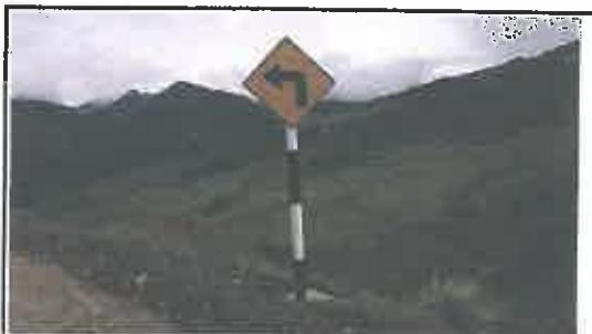
Foto N° 28: Señal preventiva de 0.8 x 0.8 m en buen estado, alerta de una curva pronunciada a la izquierda, ubicada en la progresiva 01+950.
