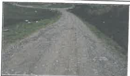
Foto N° 116: Evidencia de erosión afectando la plataforma en el Km 20+050
