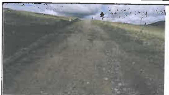
Foto N° 164: Evidencia de erosión afectando la plataforma en el Km 28+835
