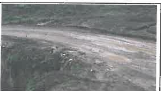
Foto N° 5: Badén enterrado debido a la erosión generada por el cruce de agua, ubicado en la progresiva 02+342.
