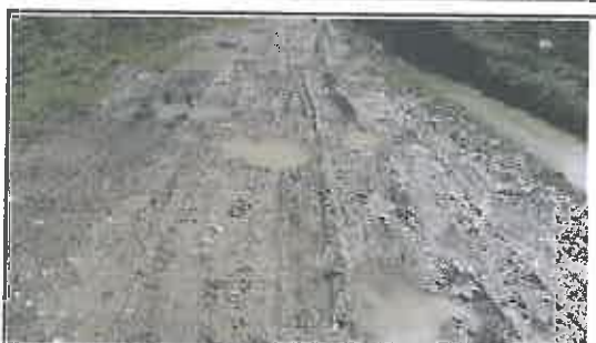
Foto N° 163: Evidencia de baches afectando la plataforma en el Km 28+680
