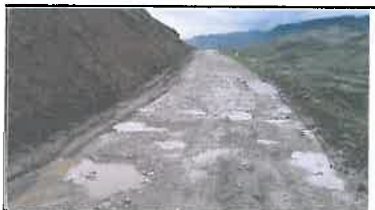
Foto N° 87: Evidencia de baches afectando la plataforma en el Km 15+970
