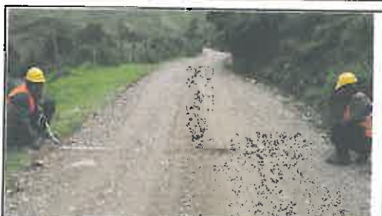
Foto N° 69: Prueba de la anchura de la superficie de rodadura en el Km 03+400.
