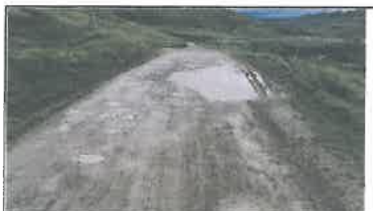
Foto N° 73: Evidencia de baches afectando la plataforma en el Km 14+065
