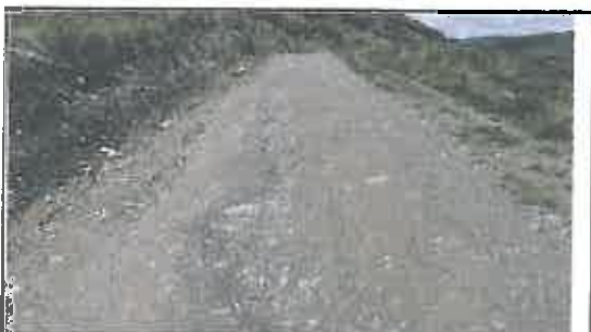
Foto N° 133: Evidencia de erosión afectando la plataforma en el Km 23+390
