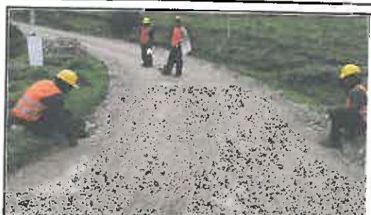
Foto N° 92: Prueba de la anchura de la superficie de rodadura en el Km 04+550.
