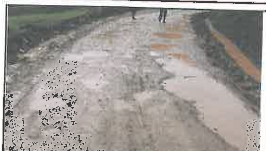
Foto N° 12: Evidencia de baches afectando la plataforma en el Km 02+060
