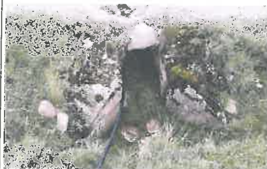
Alcantarilla de mampostería y losa de troncos de madera en mal estado, ubicada en la progresiva 16+330
