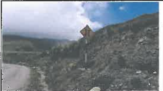
Foto N° 123: Señal preventiva de 0.8 x 0.8 m en buen estado, alerta de un puente angosto, ubicada en la progresiva 23+527.
