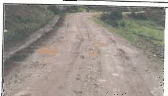
Foto N° 14: Evidencia de cruce de agua afectando la plataforma en el Km 02+290
