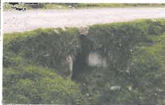
Alcantarilla de mampostería y losa de troncos de madera en mal estado, ubica en la progresiva 10+087
