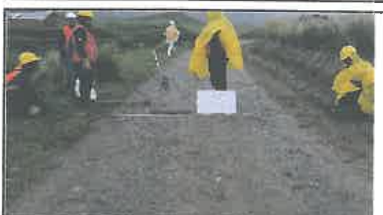
Foto N° 516: Prueba de la anchura de la superficie de rodadura en el Km 25+750.
