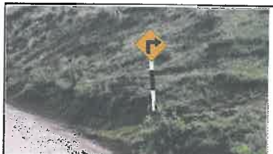
Foto N° 26: Señal preventiva de 0.8 x 0.8 m en buen estado, alerta de una curva pronunciada a la derecha, ubicada en la progresiva 01+777.
