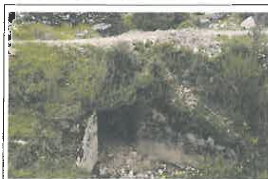
Alcantarilla de mampostería y losa de troncos de madera en mal estado, ubica en la progresiva 06+621
