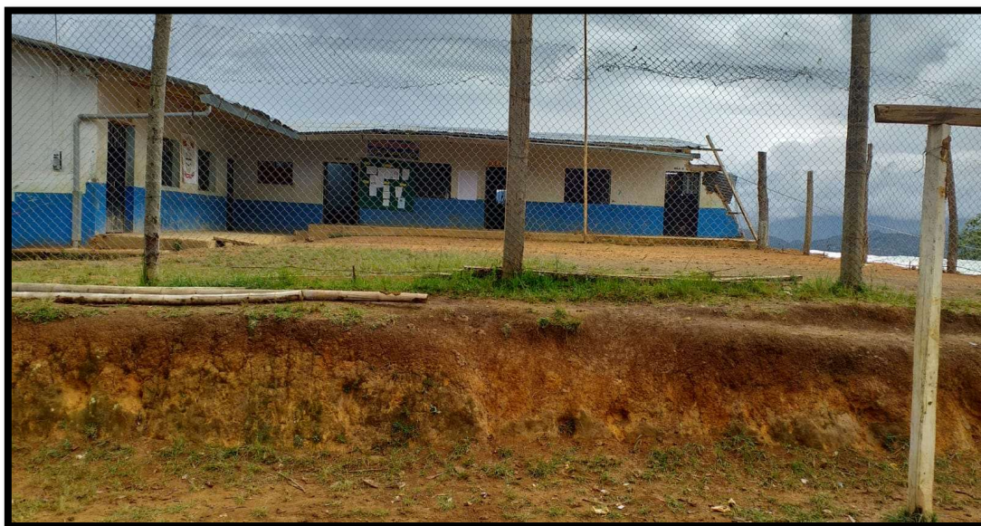
Foto 02: Se aprecia que parte del pabellón ya se ha derrumbado (Aula 6to de Primaria) y quedado expuesto parte de la cimentación hecha de piedra.
