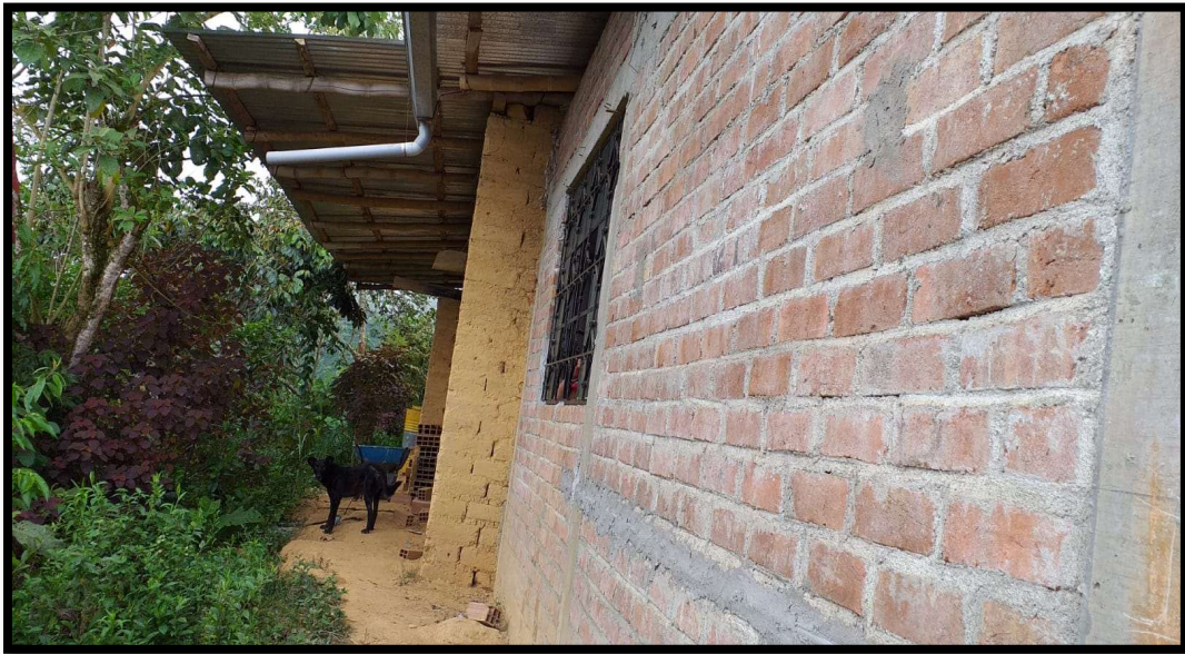
Foto 06: Vista posterior del Pabellón 03, donde se aprecia el material de adobe y albañilería.
