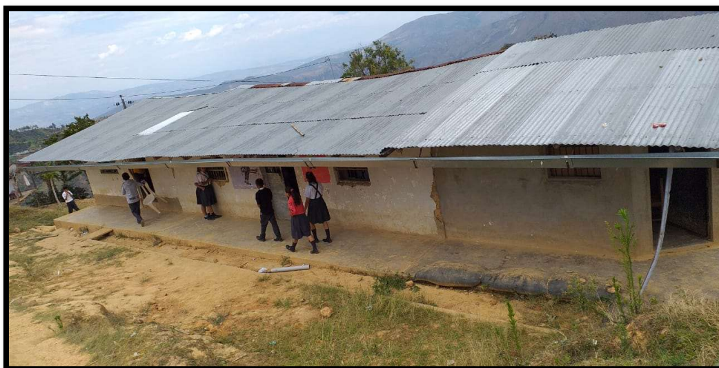
Foto 03: Pabellón 02, se observa el deterioro de su infraestructura, construido con falta de criterio técnico y sin ninguna norma técnica de edificaciones.
