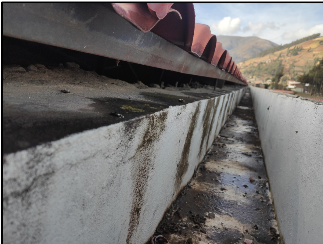
Foto 02: Espacio libre entre el Canal de Agua Pluvial y la Cubierta existente, la cual deberá ser tapada con concreto.
