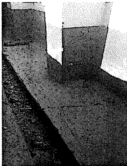
Fisuras en veredas
