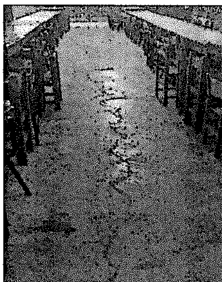
Vista interior de comedor. Nótese grietas en piso de cemento.
