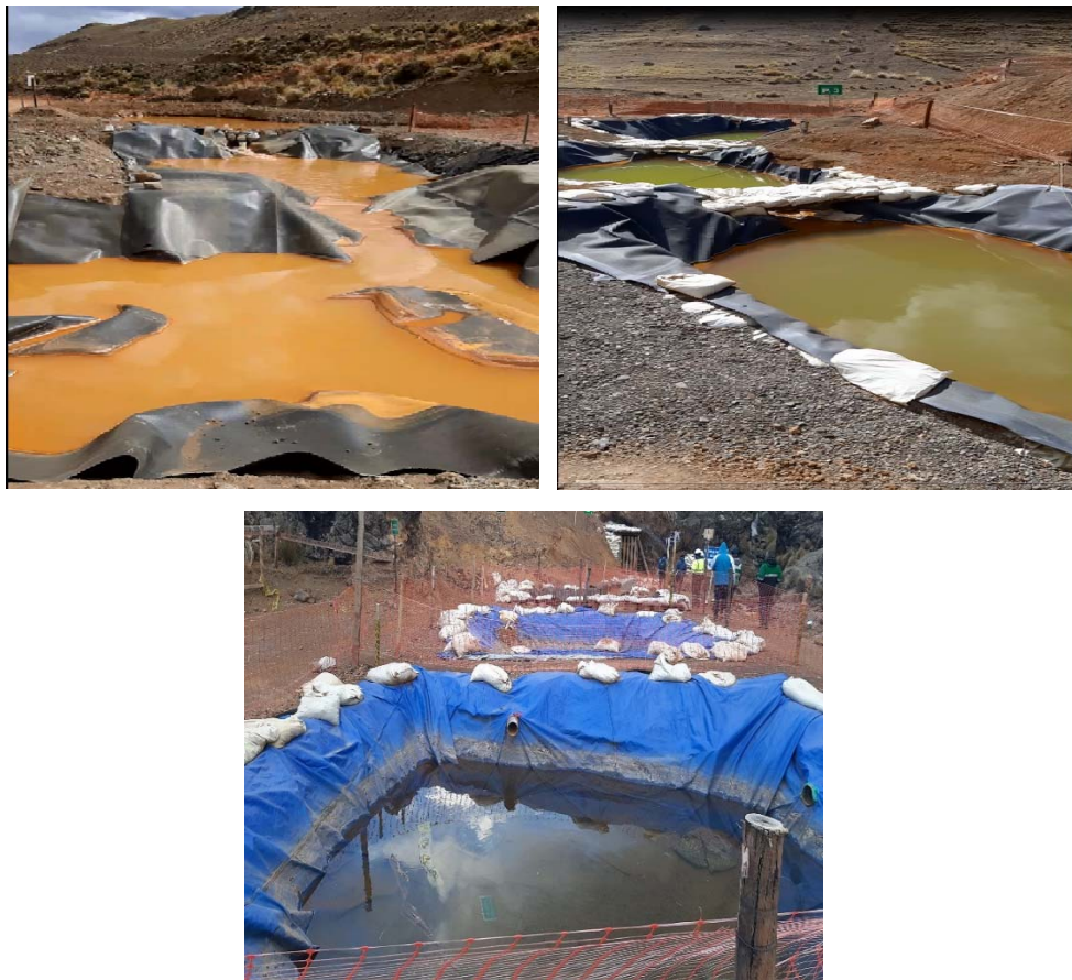
Imagen N° 01: Pozas de sedimentación para realizar habilitación
