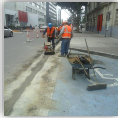
Reposición y nivelación de carpeta asfáltica [imagen referencial]
