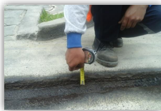
Espacio para colocar carpeta asfáltica [imagen referencial]
