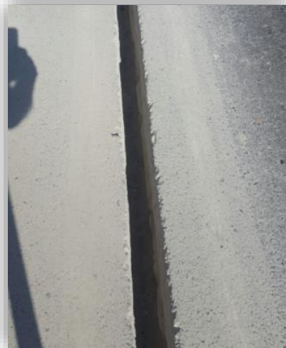
Corte de Microzanja [imagen referencial]
