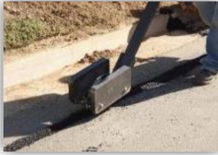
Reposición de asfalto [Imagen referencial]
