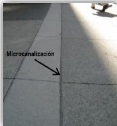
Acabado de Microcanalizado [Imagen referencial]
