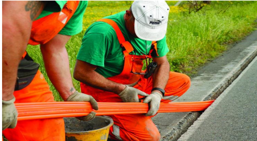
Instalacion de Microducto – Imagen referencial
