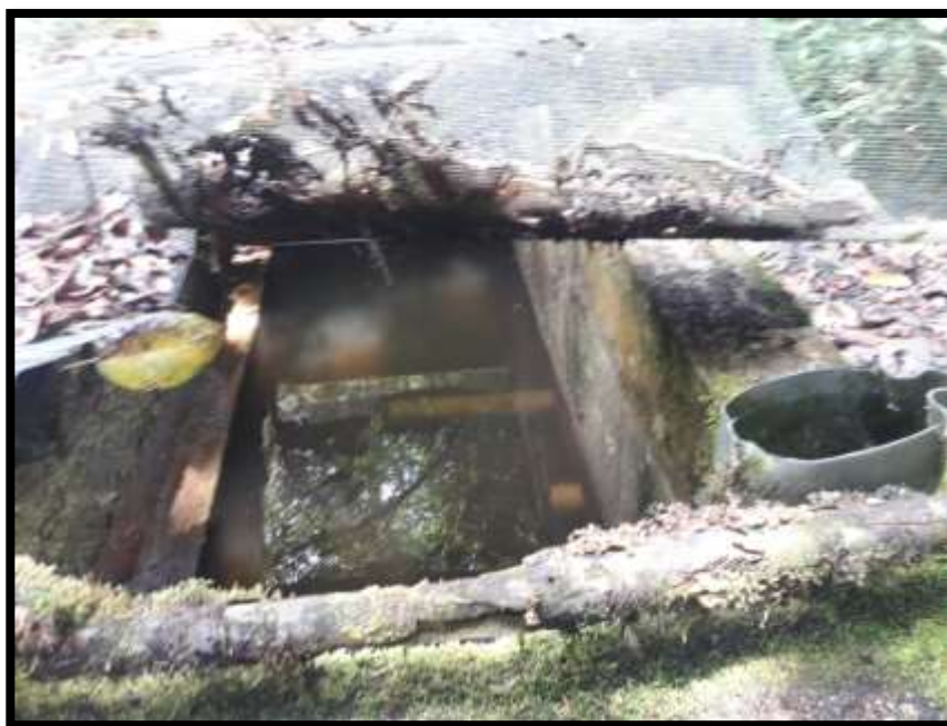
FOTO 2 - Desarenador Quebrada "El oso"
