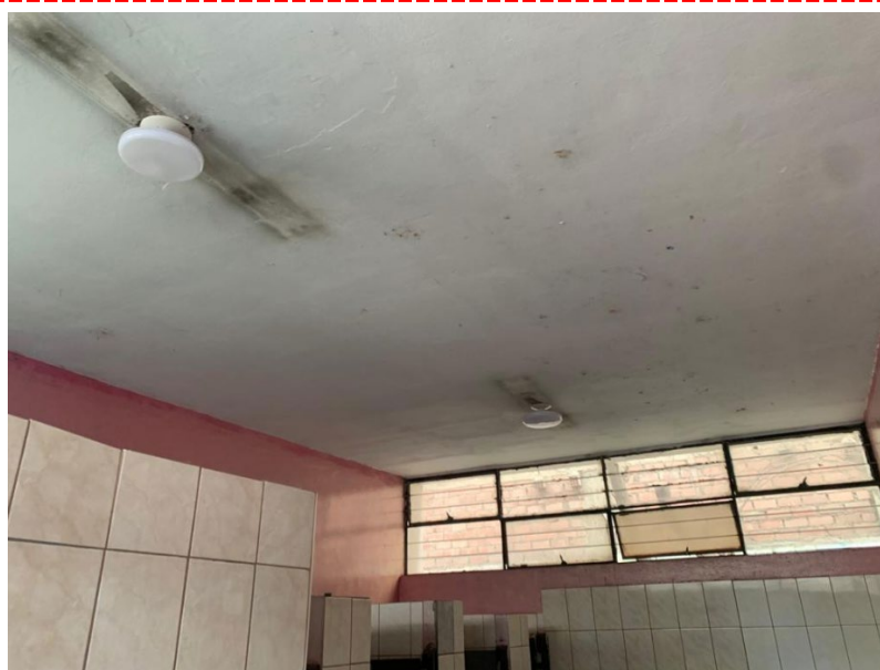
Fotografía 07: cielo raso de los servicios higiénicos 01. Se evidencia el deterioro de pintura y tarrajeo.
