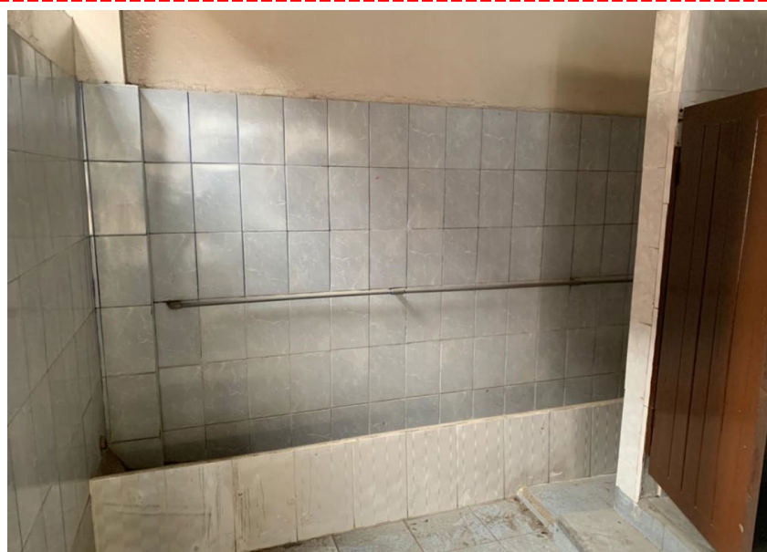
Fotografía 11: elevación 03 de los servicios higiénicos 02. Se evidencia el deterioro en los muros de los servicios higiénicos por falta de pintura y mantenimiento a las paredes.
