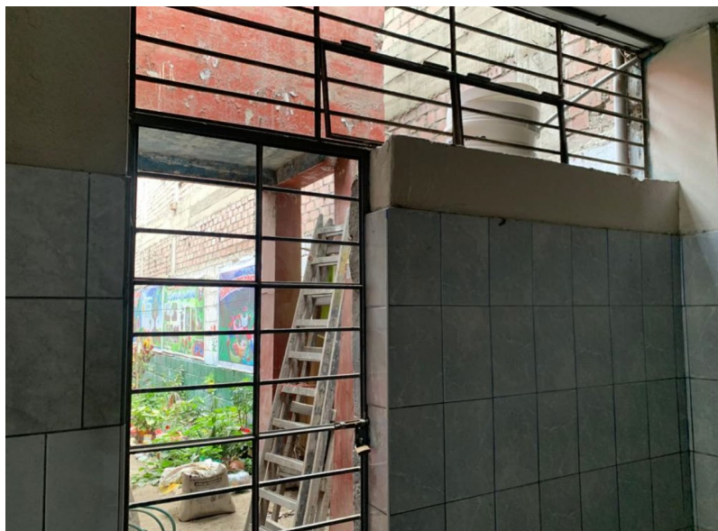
Fotografía 12: elevación 04 de los servicios higiénicos 02. Se evidencia que no existe vidrios en las puertas y ventanas que divida la parte externa (patio) con los servicios higiénicos.
