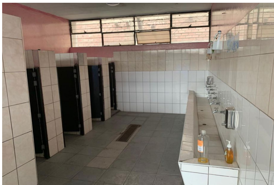
Fotografía 03: elevación 01 de los servicios higiénicos 01. Se evidencia que la puerta principal del ingreso al baño de mujeres no tiene vidrios de separación.
