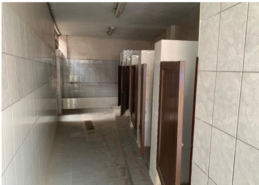
Fotografía 10: elevación 02 de los servicios higiénicos 02. Se evidencia el deterioro en el tarrajeo y pintura de las paredes del baño.
