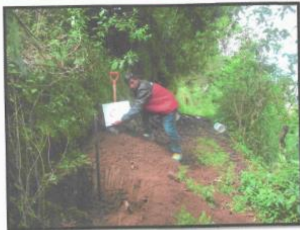
Ilustración N° 6: Calicata de inspección en terreno proyectado para captaciónFuente: Elaboración propia
