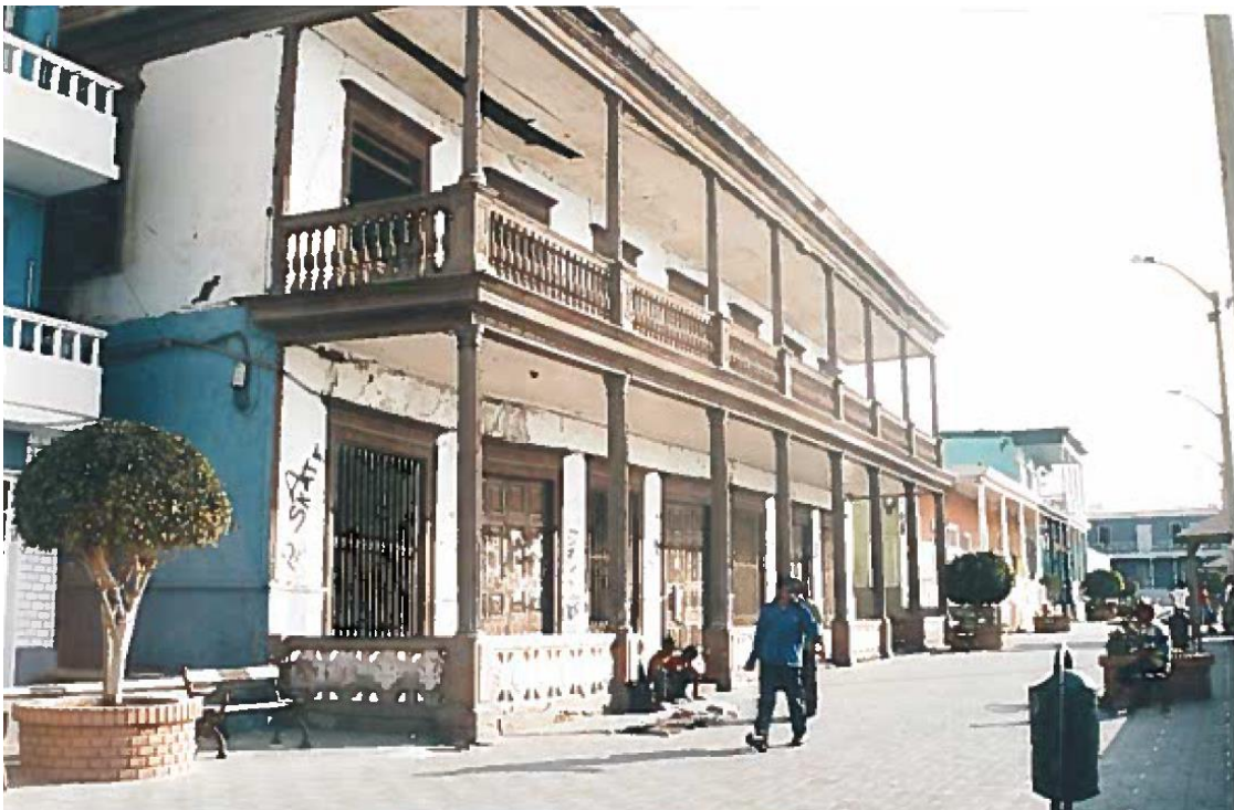
Vista de la Casona desde el Malecón Grau, donde se puede apreciar el asentamiento de los techos y el deterioro de los elementos arquitectónicos, convirtiéndose en peligro público ante su inminente colapso.
