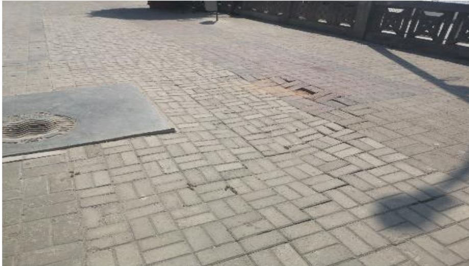
Imagen N°4: Asentamientos del suelo a lo largo del malecón– Fuente: Propia
