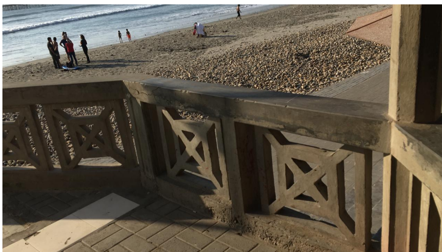
Imagen N°3: Muro del malecón en mal estado de conservación – Fuente: Propia
