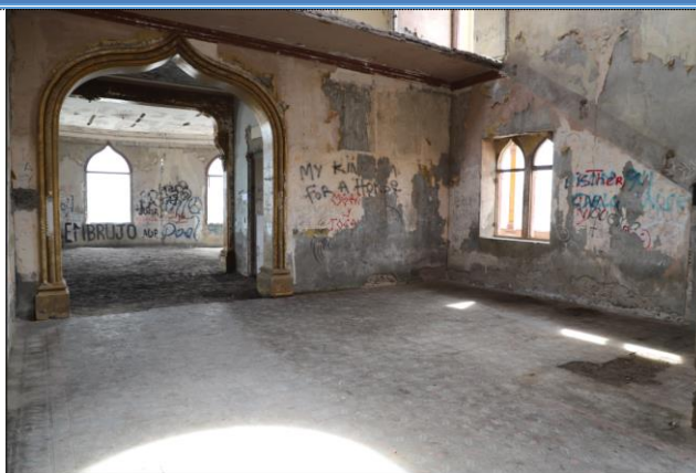
Vista del mal estado de conservación de los ambientes interiores del Castillo Forga, se aprecia la huella de la una escalera
