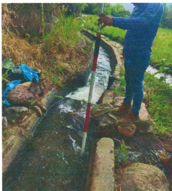
Toma lateral en canal revestido
