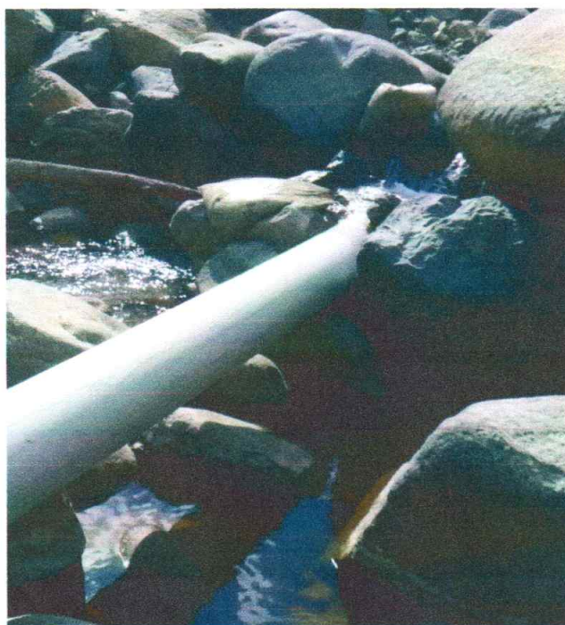
Línea de conducción expuesta y afectada
