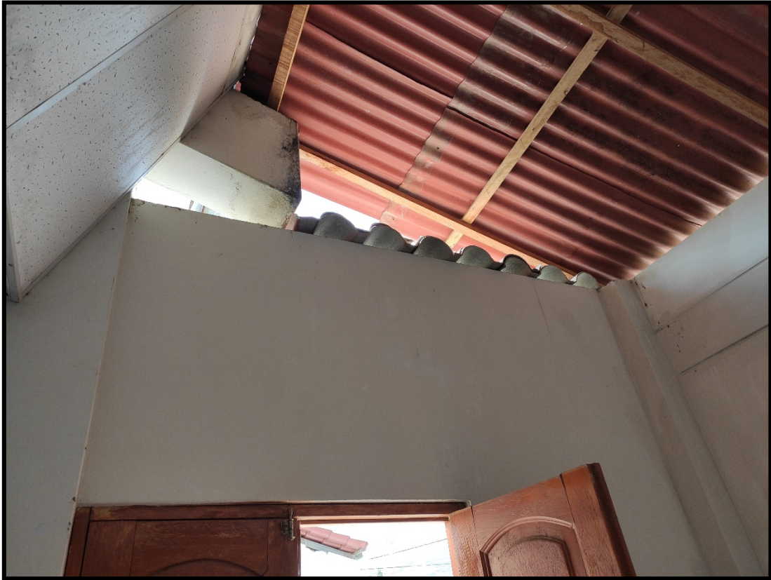
Foto 01: Borde Libre entre Muro y Cubierta Existente
