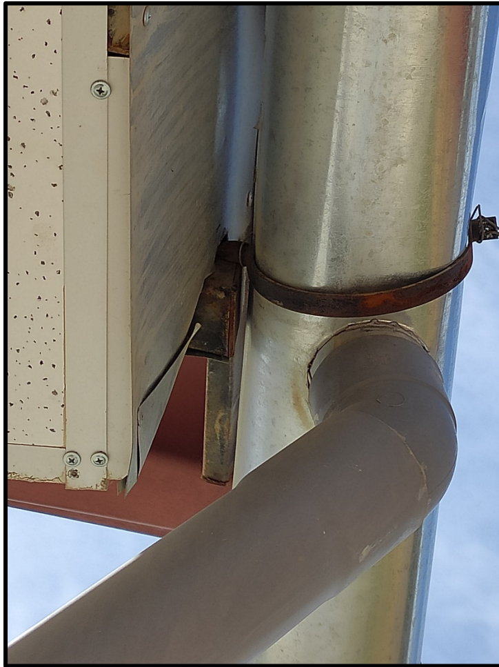
Foto 09: Bajante de Agua Pluvial
