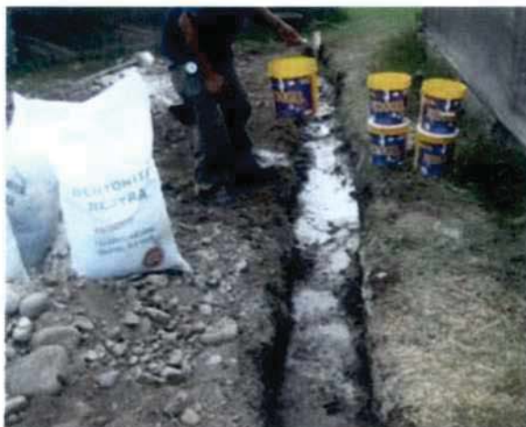
Vistas 2 del proceso de instalación de poza atierra horizontal (Imagen referencial)
