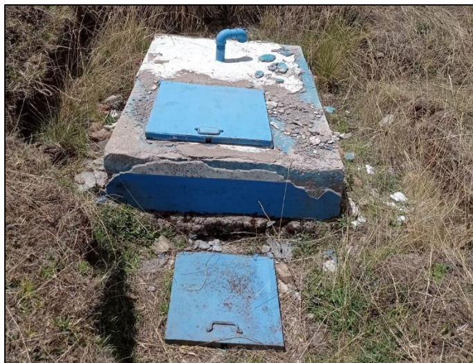
Ilustración 13: Cámara rompe presión - 1
