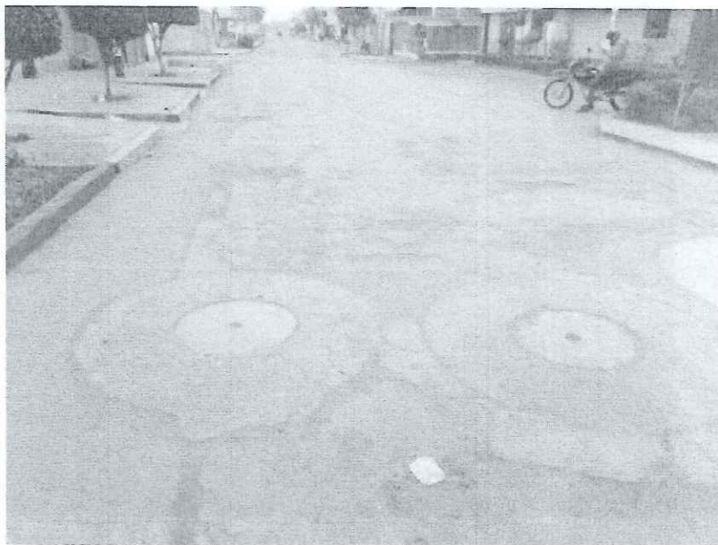
IMAGEN NRO 09: SE APRECIA GRIETAS Y FISURAS EN LA AV. INDOAMERICA ENTRE AV. J. GABRIEL CONDORCANQUI - CALLE LOS OLIVOS
