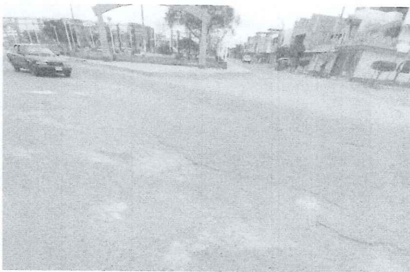
IMAGEN NRO 38: SE APRECIA GRIETAS Y FISURAS EN LA AV. CARDENALES ENTRE AV. G - CALLE 6
