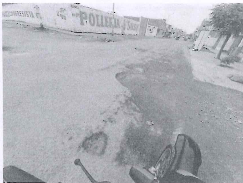
IMAGEN NRO 16: SE APRECIA GRIETAS Y FISURAS EN LA AV. INDOAMERICA ENTRE CALLE 6 DE ENERO - CALLE LOS REYES
