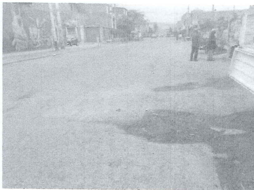
IMAGEN NRO 22: SE APRECIA GRIETAS Y FISURAS EN LA AV. EGIPTO ENTRE AV. CAHUIDE - CALLE LOS LAURELES
