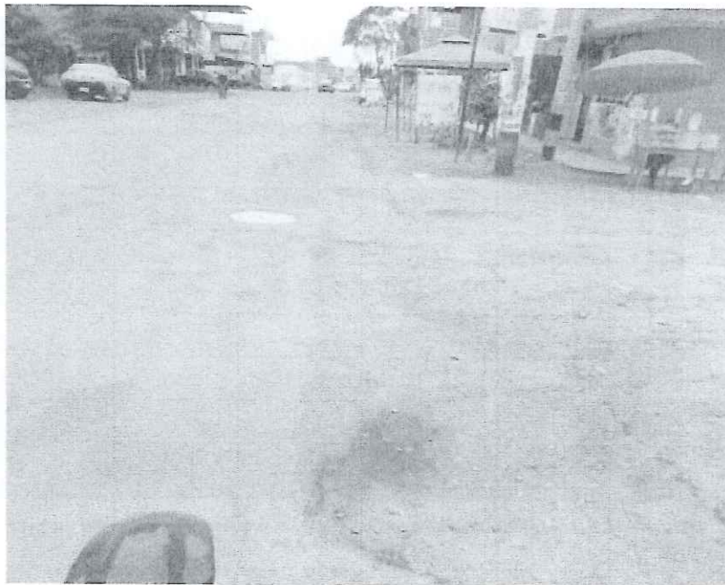
IMAGEN NRO 13: SE APRECIA GRIETAS Y FISURAS EN LA AV. INDOAMERICA ENTRE CALLE LOS CEDROS - JR. NICOLAS DE PIEROLA
