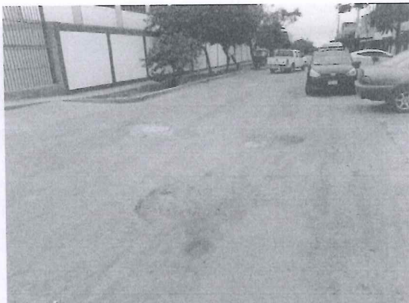
IMAGEN NRO 03: SE APRECIA GRIETAS Y FISURAS DESDE EL COMPLEJO PARQUE INDUSTRIAL – COLEGIO SAN JOSE (CALLE 9)
