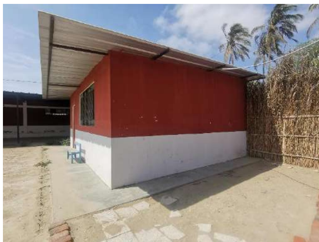
VISTA LATERAL DEL PABELLÓN 02, EDIFICACIÓN A BASE DE TRIPLAY Y MADERA Y COBERTURA DE CALAMINÓN.
