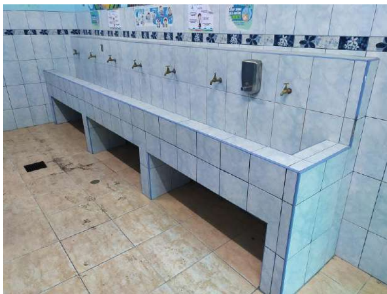
Fotografía 06: elevación 04 de los servicios higiénicos 01. Se evidencia fregadero en buen estado, rejillas en mal estado en piso
