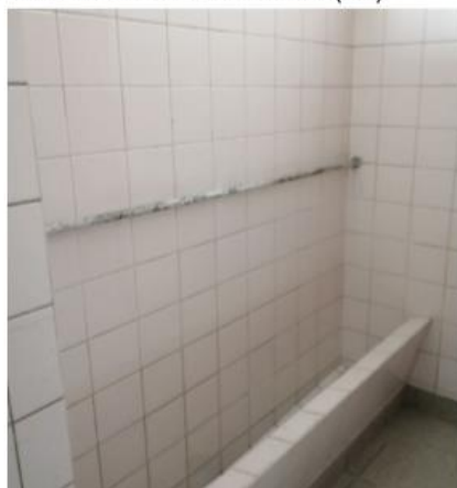
Imagen referencial de tubería a retirar
