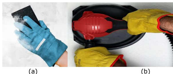
Figura N° 1. Proceso de lijado en pared; (a): Lijado a mano con lija al agua; (b): Lijado con lijadora eléctrica.
