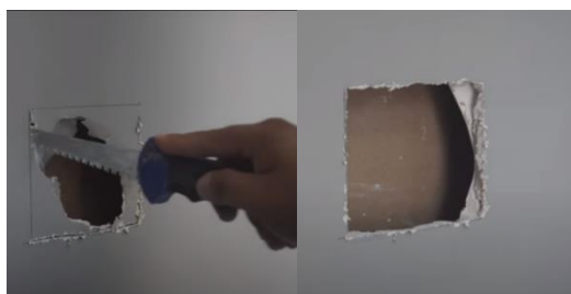
Figura 5. Perfilado de agujero con cúter o sierra para drywall.
