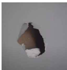
Figura 4. Agujero en panel de tabiquería móvil.
