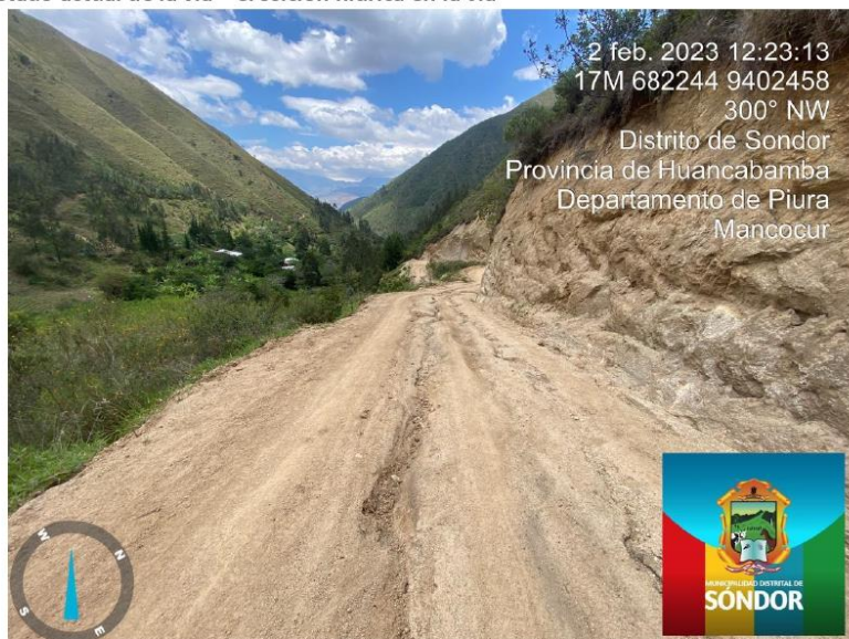
Estado actual de la vía – erosión hídrica en la vía
