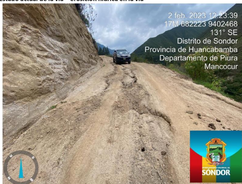
Estado actual de la vía – erosión hídrica en la vía
