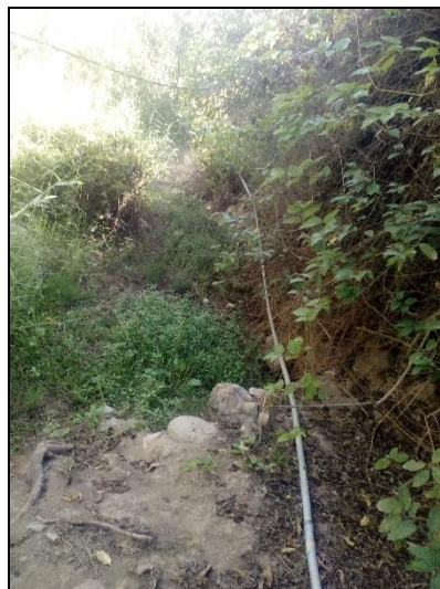
Vista: Tubería de conducción de agua potable existente expuesta.
