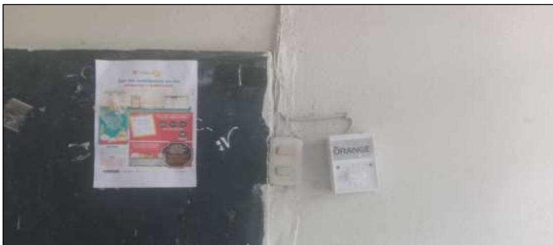
Foto N° 05: Se contempla una foto interior del pabellón 02. Las instalaciones electricas se encuentran expuestas, es decir no se encuentran empotradas ni canalizadas; por lo tanto representan un riesgo para los estudiantes.
