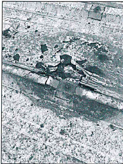
Figura 12 y 13. Se observa el estado de deterioro en diversos puntos de la cobertura que ha provocado la desintegración del recubrimiento de Aluzinc, exponiendo el núcleo de material aislante de las planchas
