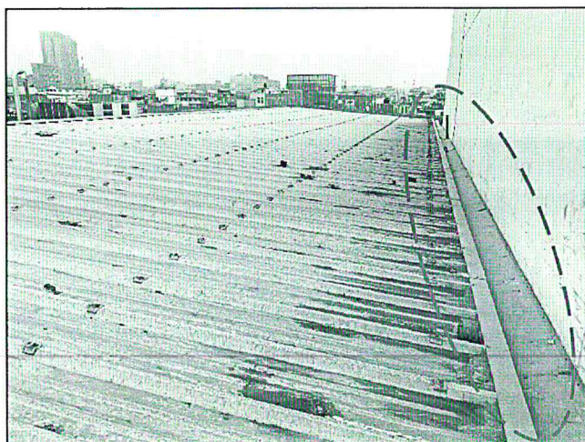
Figura 9. Se observa el ángulo de remate (esquinero) ubicado sobre la canaleta de concreto del lado derecho de la cobertura, el cual deberá ser desmontado para proceder con la limpieza de la canaleta de concreto del lado derecho de la cobertura.
