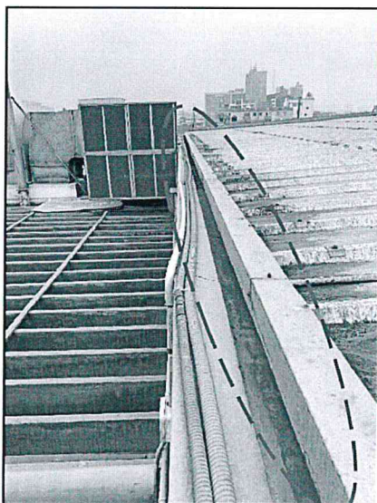
Figura 7 y 8. Se observa la canaleta de concreto del lado izquierdo de la cobertura, la cual se encuentra obstruida por los sedimentos arrastrados en el escurrimiento pluvial.
