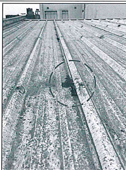
Figura 14 y 15. Se observa el estado de deterioro causado por el óxido en diversos puntos de la
