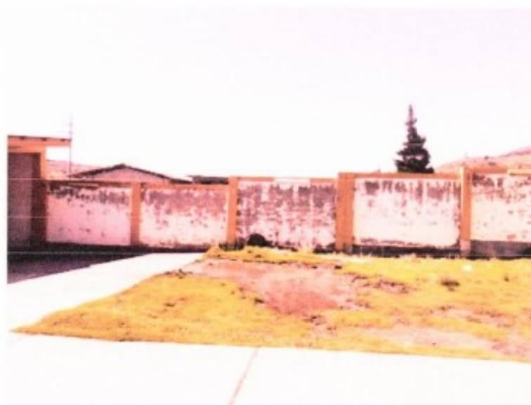
Foto 02. Se observa pintura exterior en mal estado
