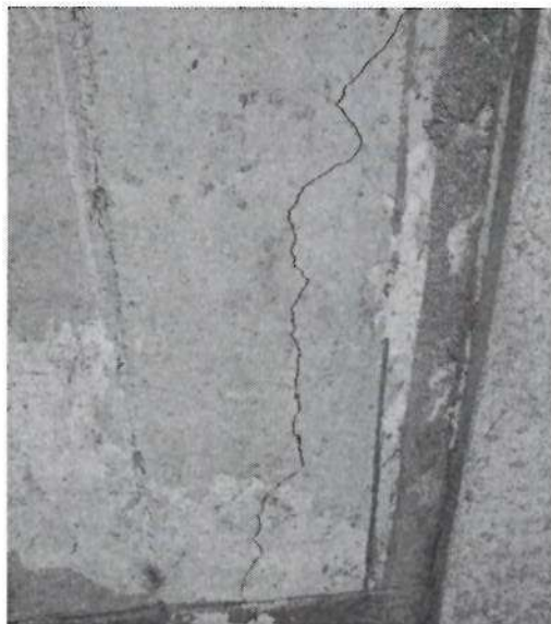
VISTA-01 DESCRIPCIÓN: (c) Fisuras en elementos estructurales de columnas del pabellon 2
