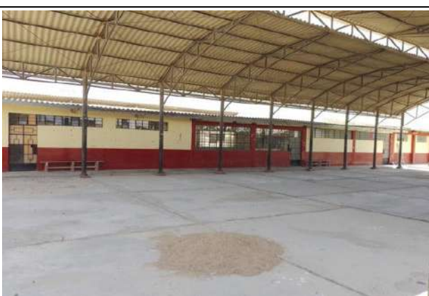
Vista de edificio 2, 3, 4 (cocina, aulas, almacen), cobertura liviana de calamina, muros de albañileria confinada
