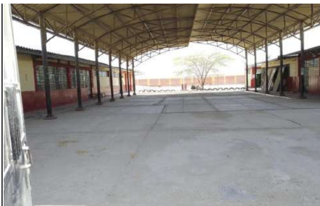
Vista desde el ingreso, se observa el patio techado y piso de cemento pulido con notariadad del desgaste
