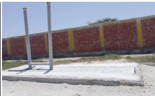
Vista de cerco perimetrico y tanque septico, se observa evidencia de la inundacion, eflorescencia en la base, asimismo deterioro del concreto
