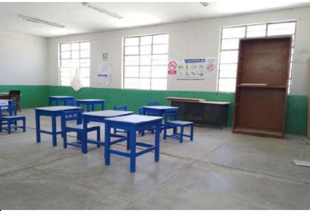
Vista interior de aula, se observa falso cielo raso, mobiliario deteriorado, piso de cemento pulido
