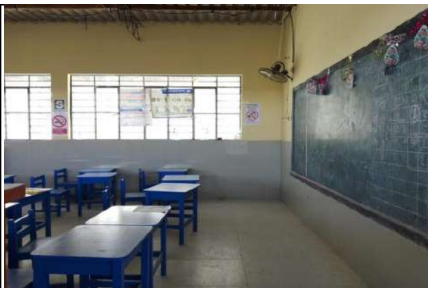
Vista interior de aula, se observa cobertura liviana, instalaciones electricas expuestas, piso de cemento pulido
