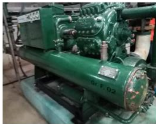
Grupos frigoríficos instalados en la C.H Charcani V
