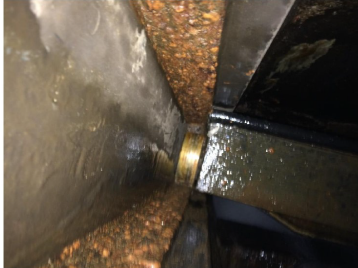
Foto 3: Vista de la rueda de la compuerta.
