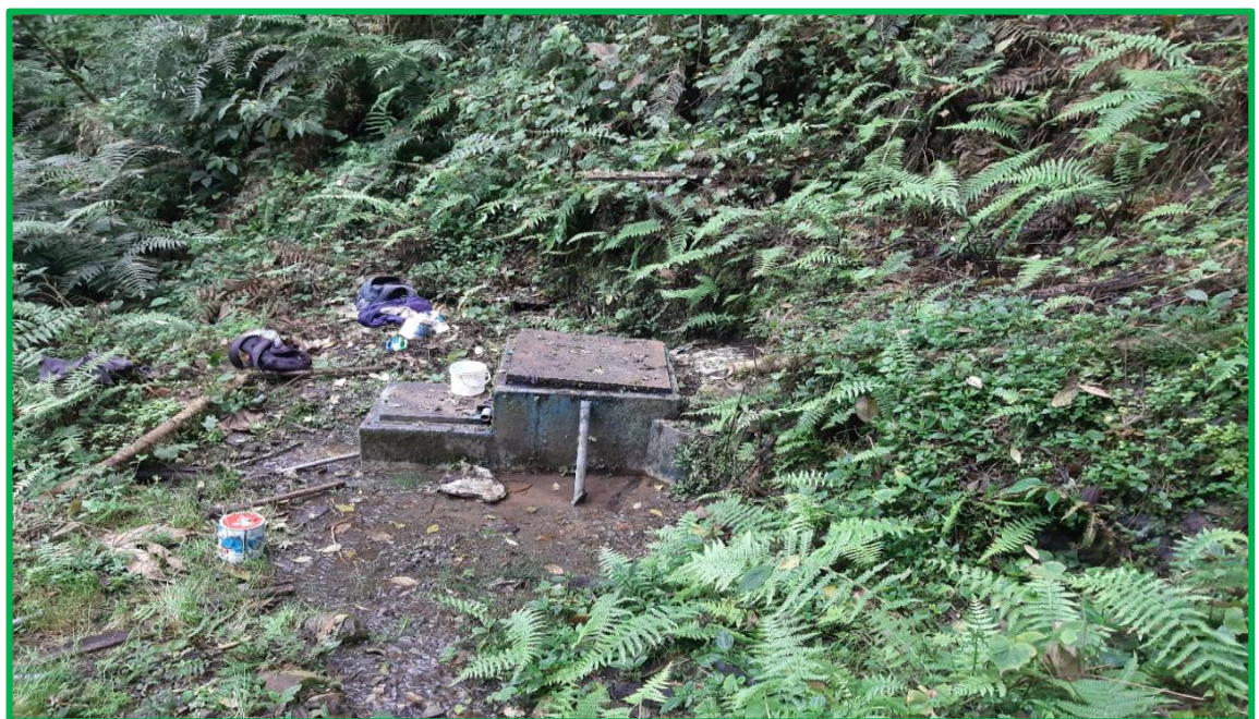
Figura 8. Se observa el estado actual del reservorio de agua potable de la localidad de Marcavalle, el cual tiene una antigüedad mayor a los 20 años
